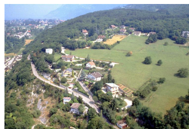
Vue aérienne : maison dite Les Touvières (en-haut à gauche) Repro. Denys Harreau IVR82_20147300046NUCB
