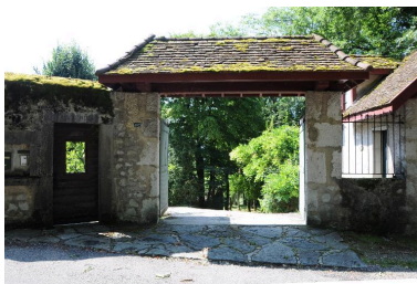
Portail d'entrée Phot. Denys Harreau IVR82_20137300702NUCA
