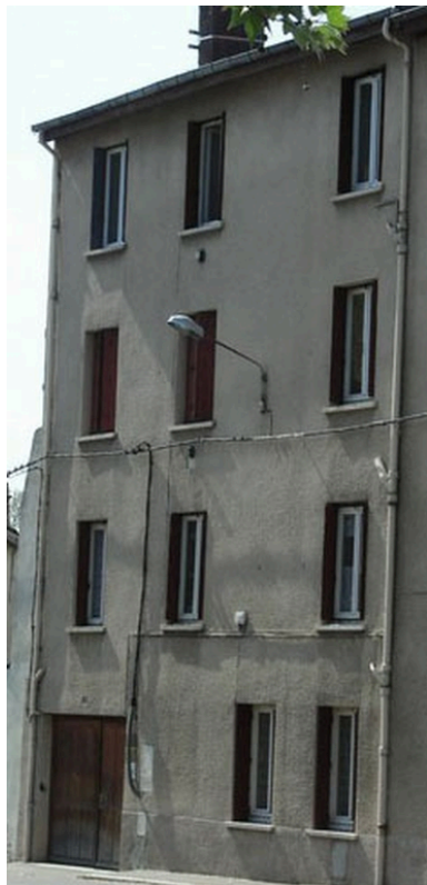
façade sud est Phot. Benoît Chapelle IVR82_20073800057NUCA
