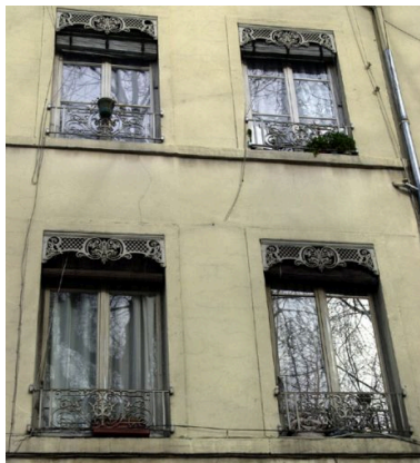
Détail des fenêtres Phot. Maryannick Chalabi IVR82_20016900274NUCA
