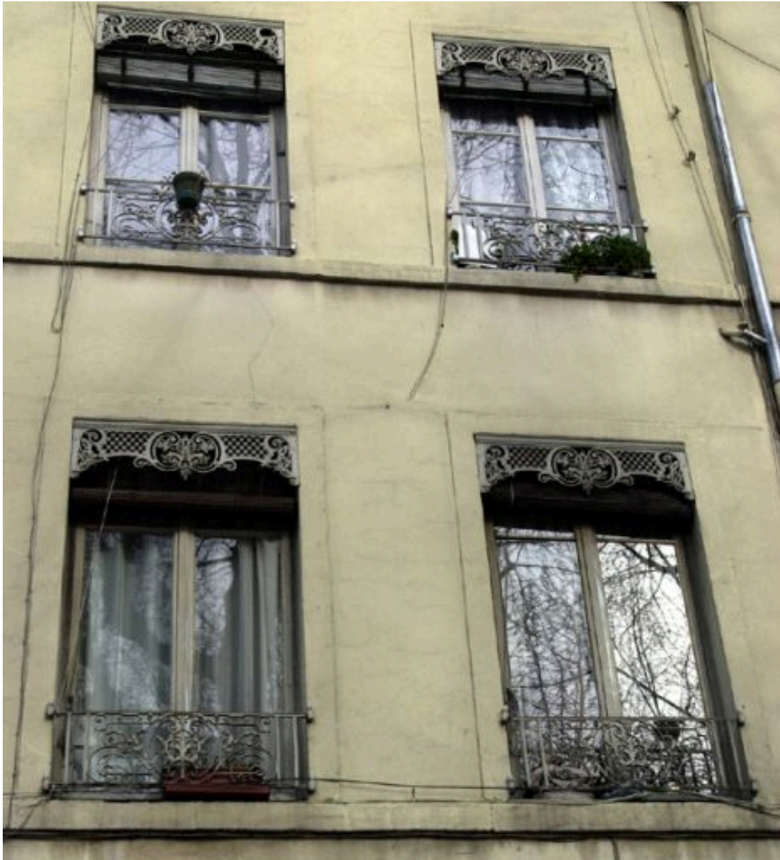
Détail des fenêtres
