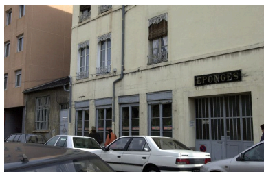
Vue du magasin d'éponges, rue Gilibert Phot. Maryannick Chalabi IVR82_20016900278NUCA
