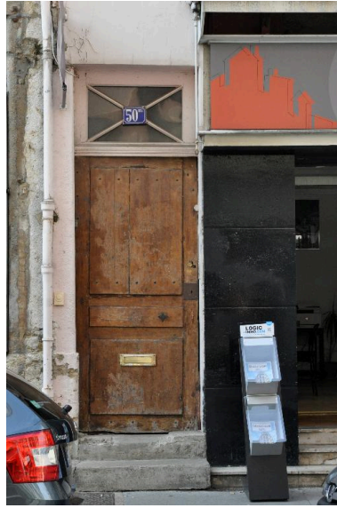
Vue rapprochée de la porte Phot. Magali Delavenne IVR84_20176901520NUCA
