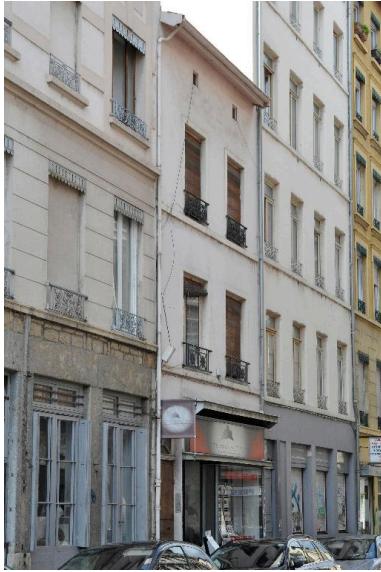
Vue générale, élévation sur rue Phot. Magali Delavenne IVR84_20176901519NUCA
