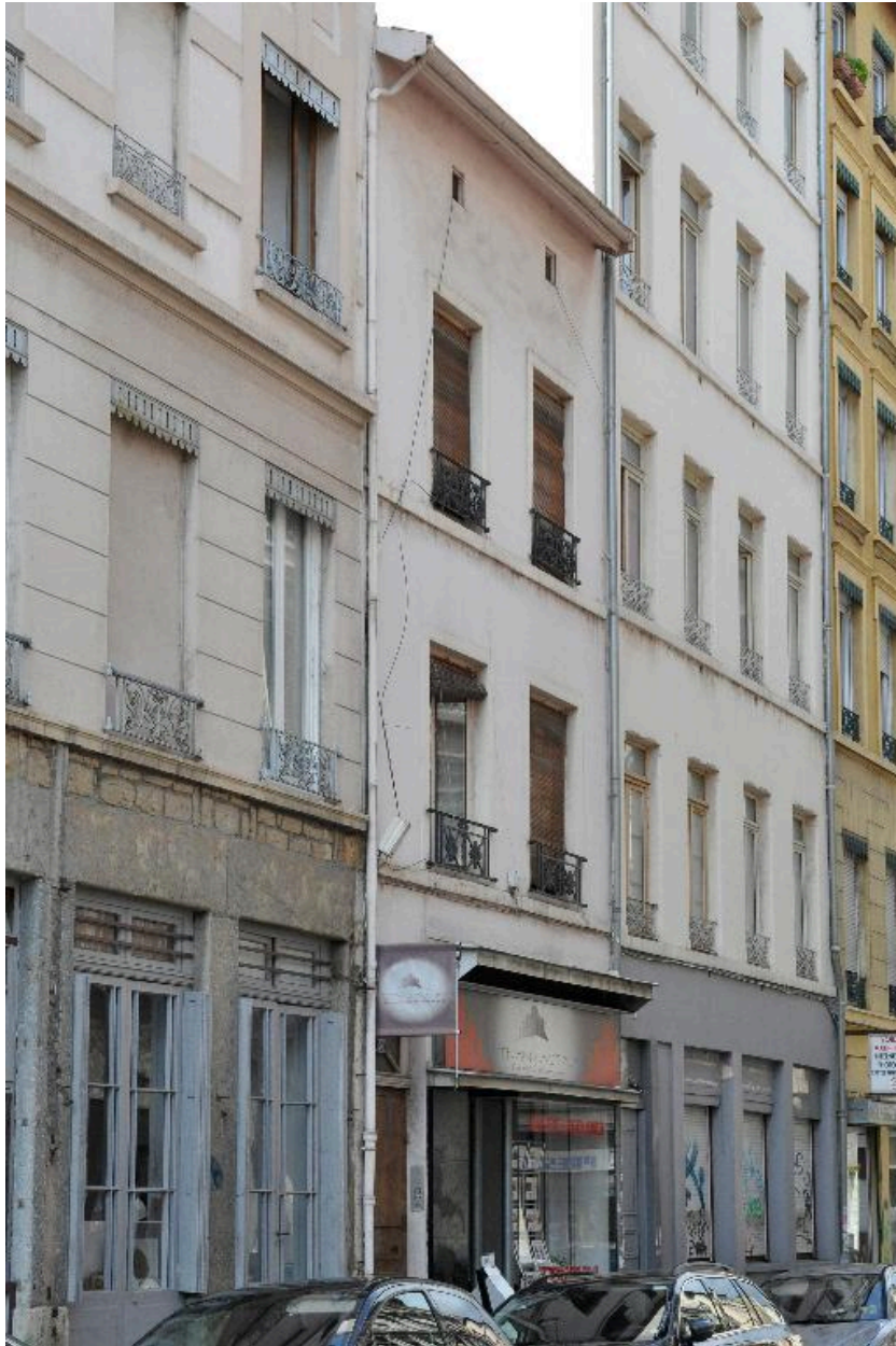
Vue générale, élévation sur rue
