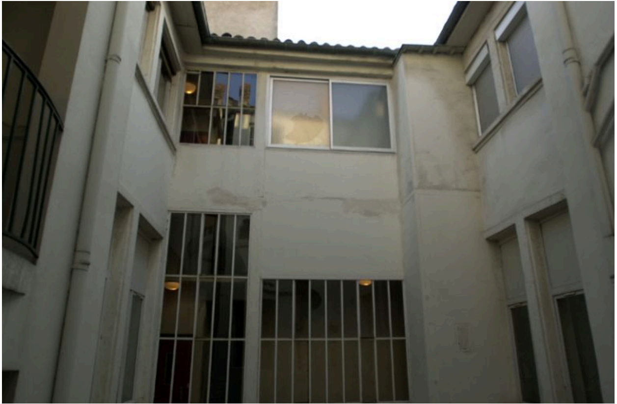
Cour nord, vue des 3e et 4e étages
