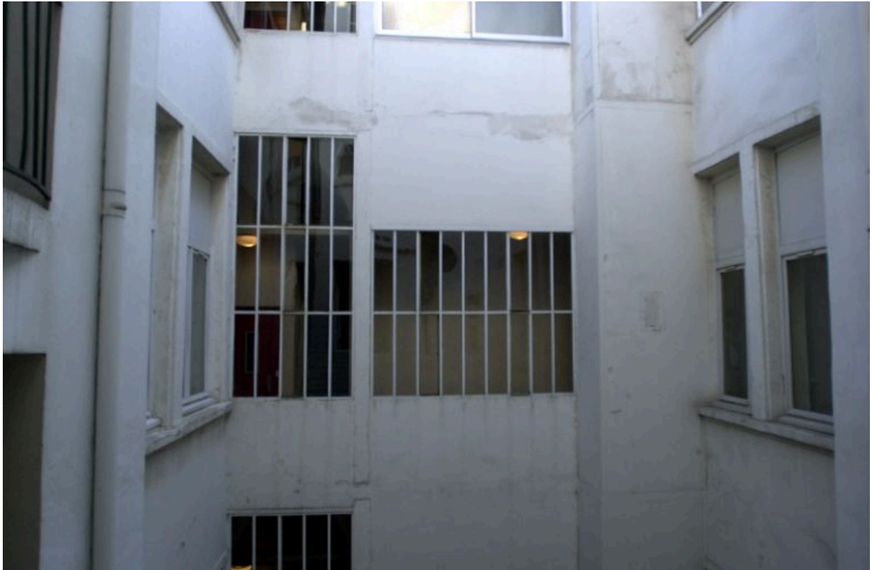
Cour nord, vue au niveau du 3e étage, face à la coursière aujourd'hui fermée
