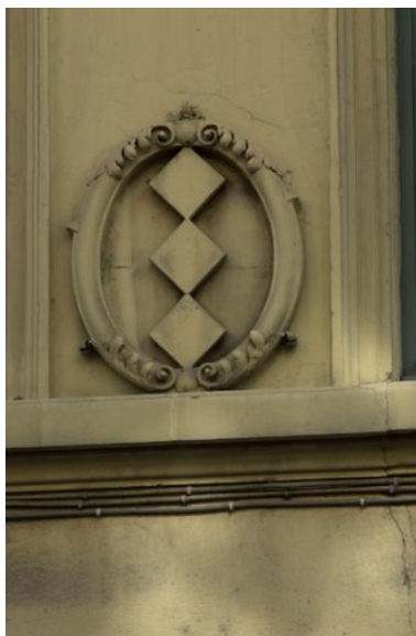
Façade, détail de l'enseigne Phot. Bernard Ducouret IVR82_20046900767NUCA
