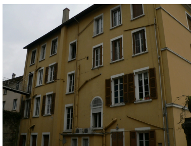
Façade arrière Phot. Isabelle Dupuis IVR82_20073800182NUCA
