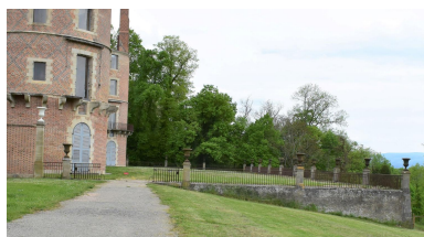
Vue d'ensemble Phot. Maryse Durin-Tercelin IVR84_20226300642NUCA
