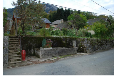
Vue d'ensemble du bassin. Phot. Thierry Monnet IVR84_20177300740NUCA
