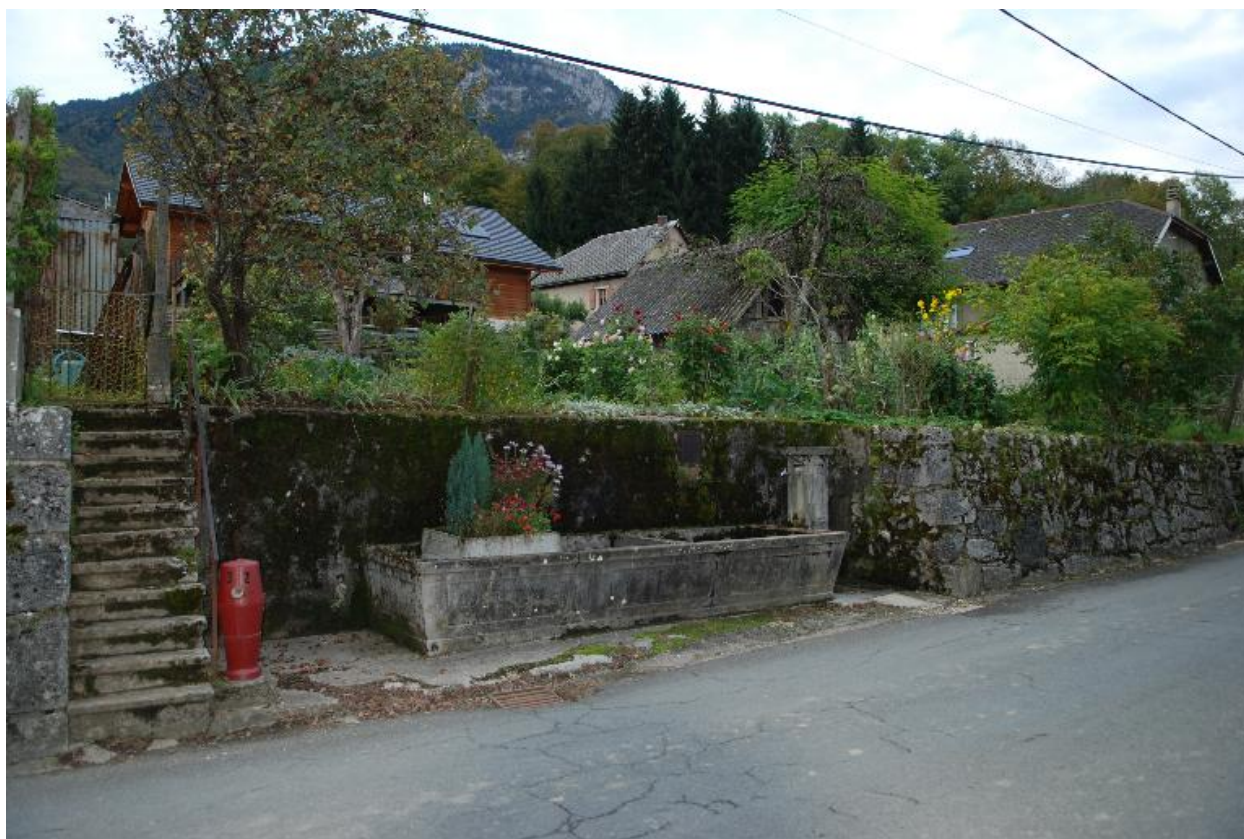
Vue d'ensemble du bassin.
