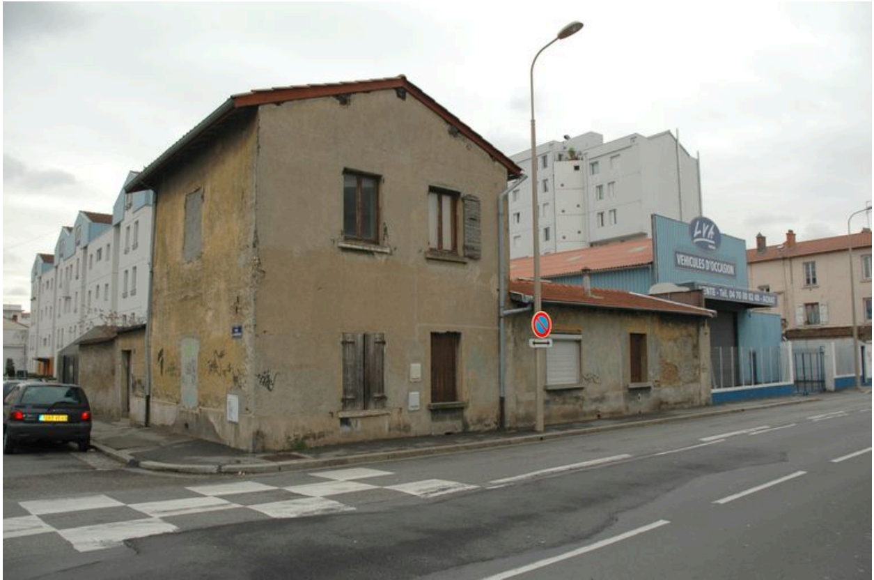
Vue de la façade postérieure de la maison
