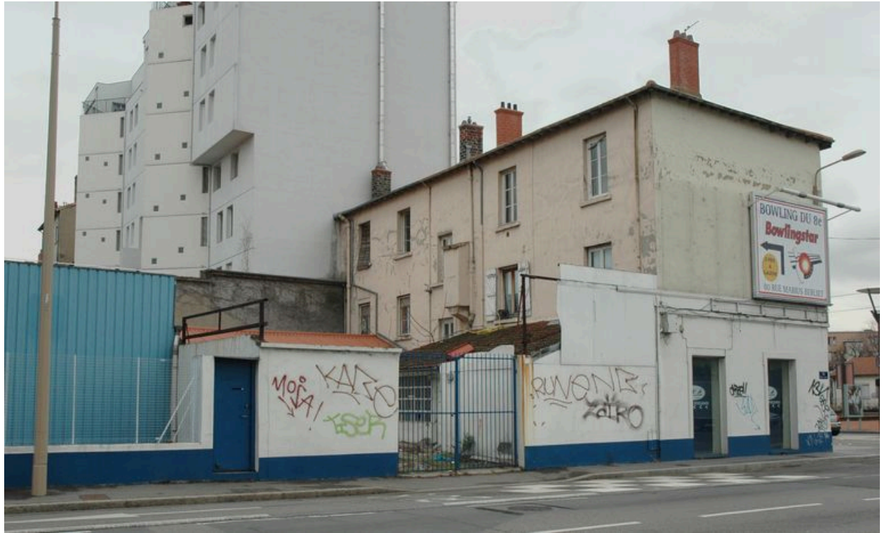
Vue de la façade postérieure de l'immeuble 245 avenue Berthelot
