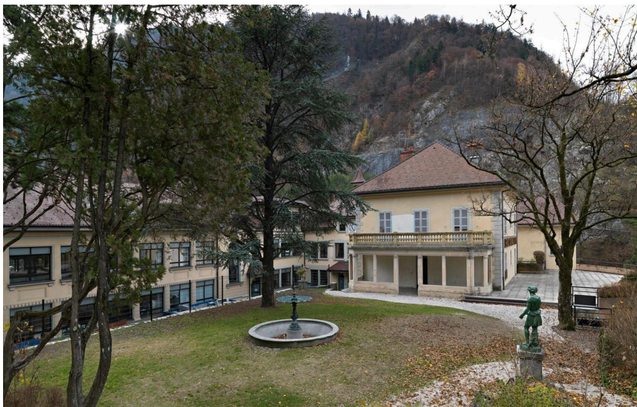
Vue sud du site côté jardin
