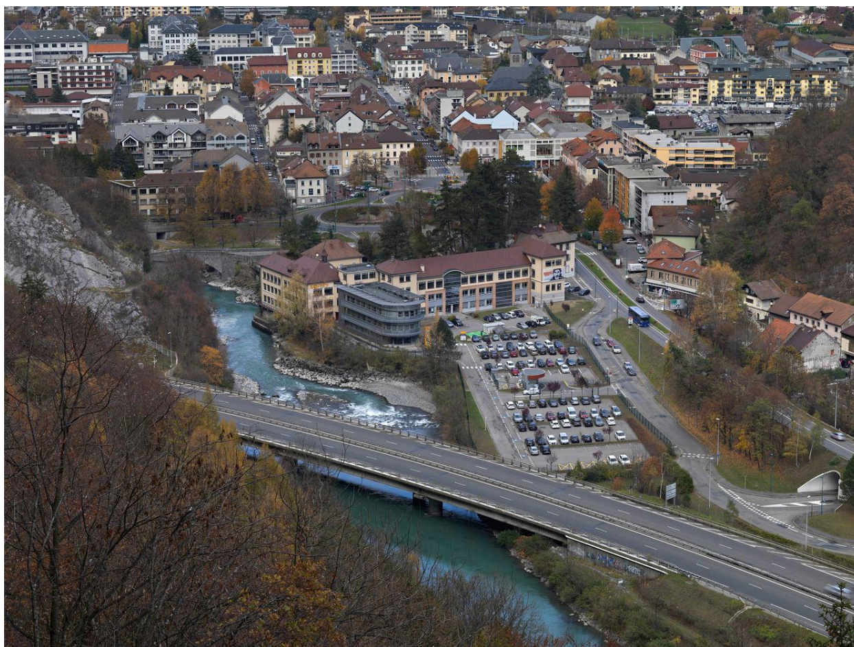
Vue d'ensemble sud-ouest
