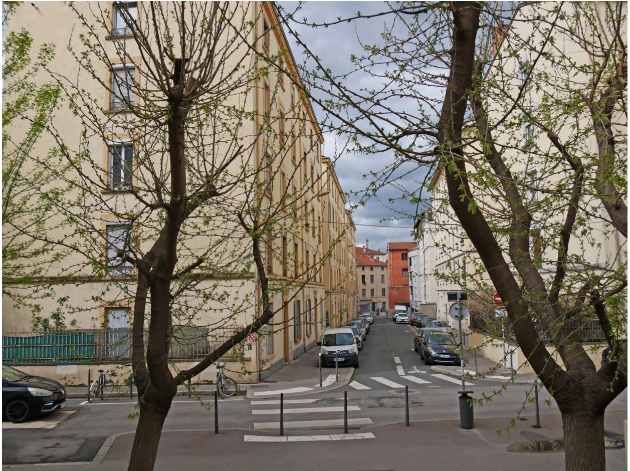
Vue des logements économiques de Vaise : rue des maisons nouvelles
