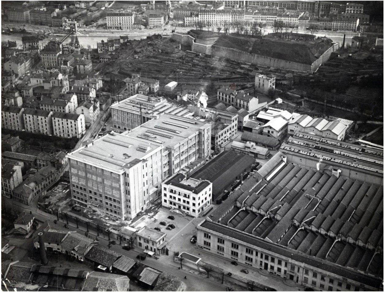
Vue des immeubles économiques sur la gauche de la photo (BML)
