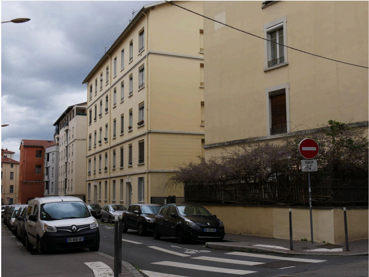
Vue des logements économiques de Vaise : façade principale
