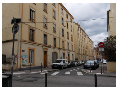
Vue des logements économique de Vaise Phot. Nadine Halitim-Dubois IVR84_20246900635NUCA
