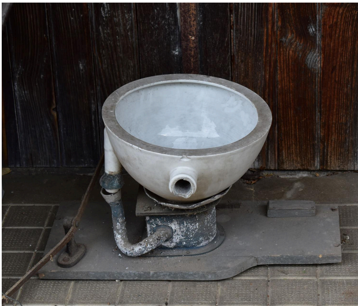
Vue générale de la vasque et du système d'évacuation
