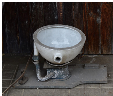
Vue générale de la vasque et du système d'évacuation Phot. Maryse Durin-Tercelin IVR84_20226300977NUC4A
