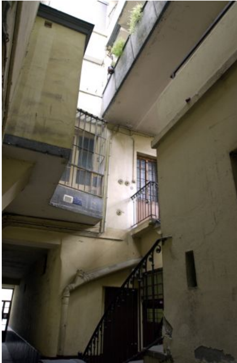
Elévation postérieure du bâtiment sur rue
