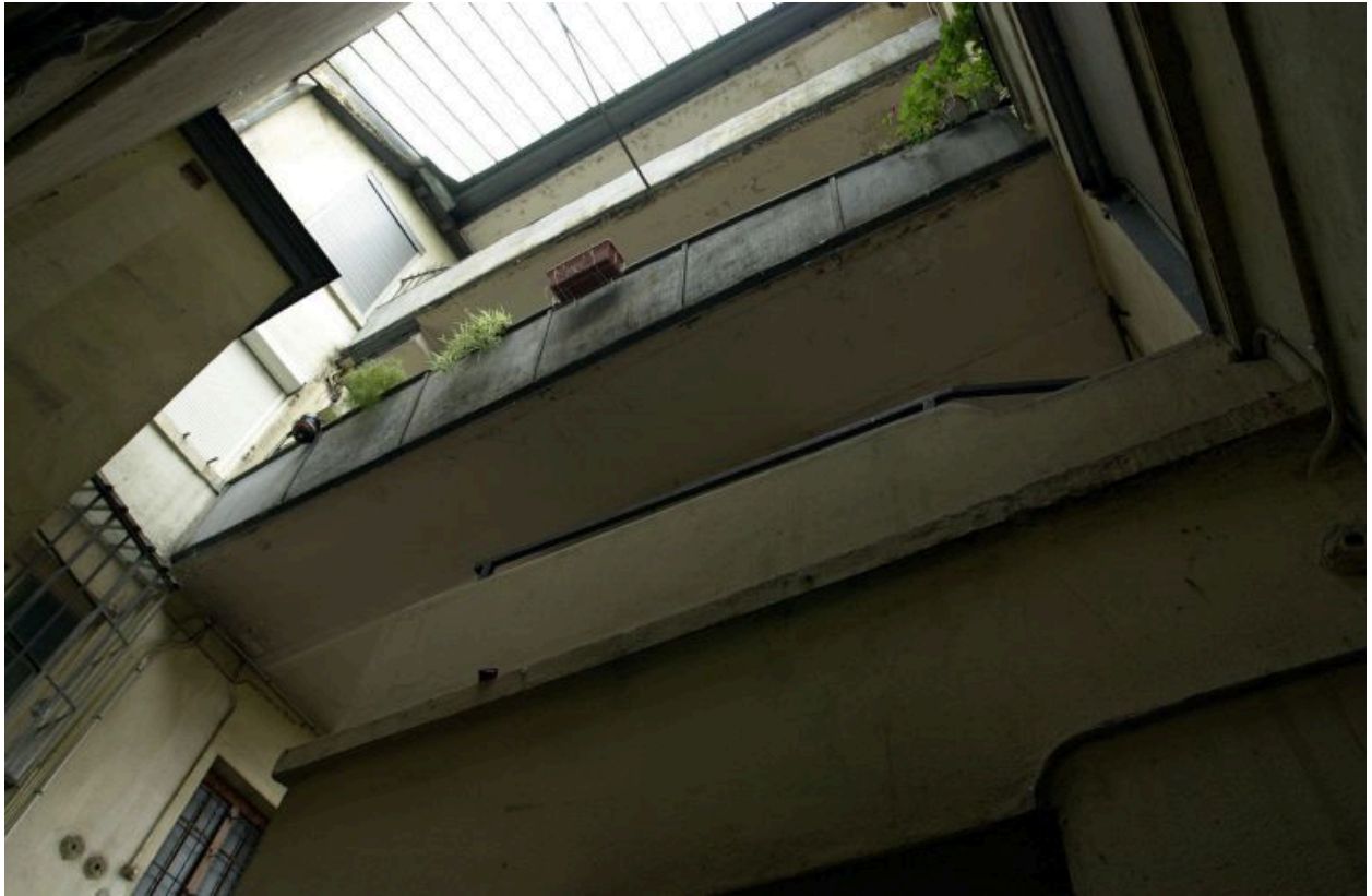
Vue de la verrière au-dessus de la cour
