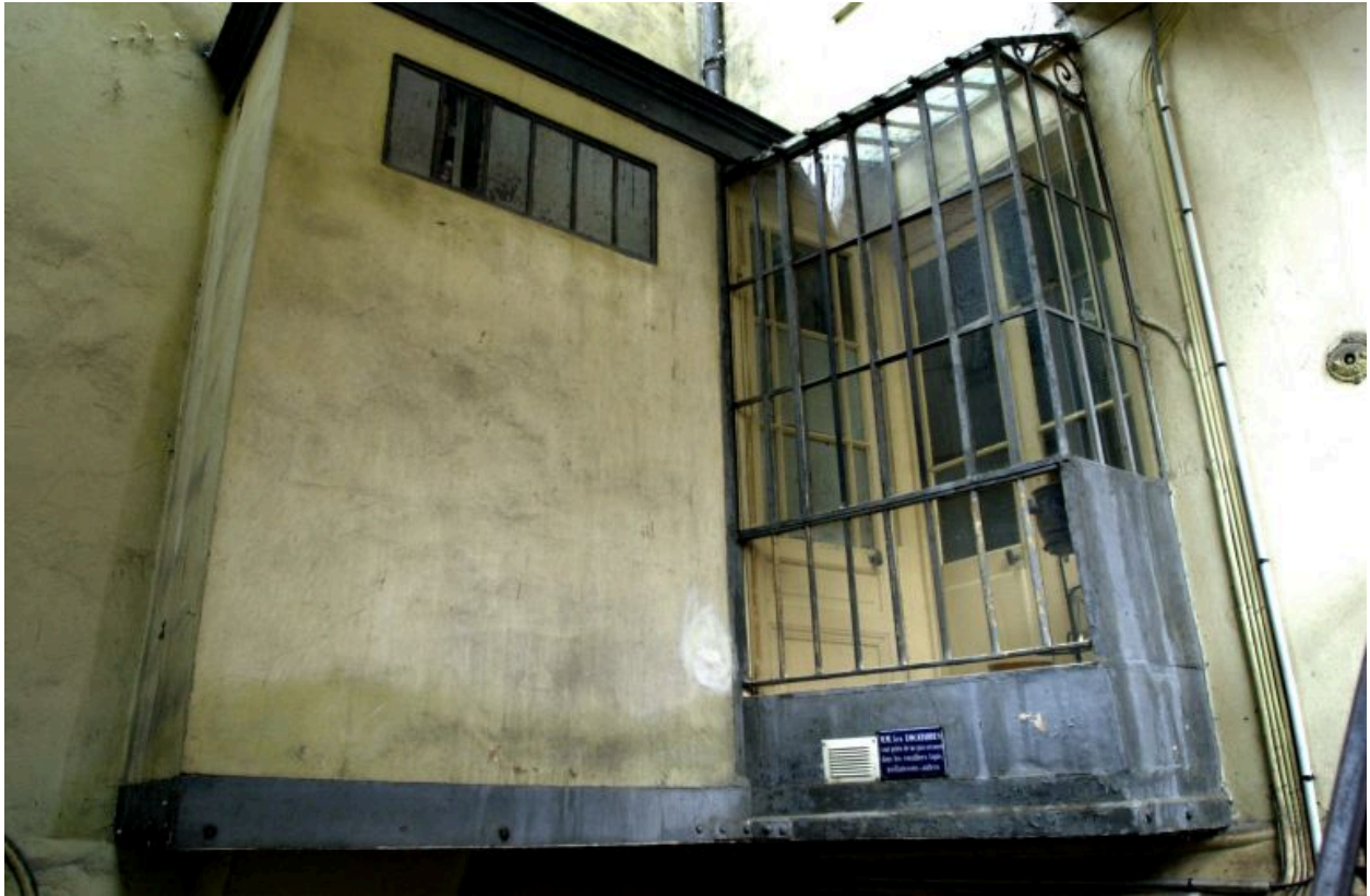
Vue des structures en surplomb contre l'élévation postérieure du corps de bâtiment sur rue
