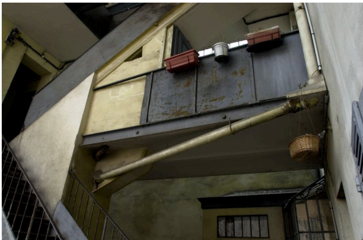
Détail des circulations supérieures
