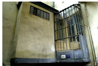
Vue des structures en surplomb contre l'élévation postérieure du corps de bâtiment sur rue Phot. Chantal Archer-Galéa IVR82_20016901212NUCA
