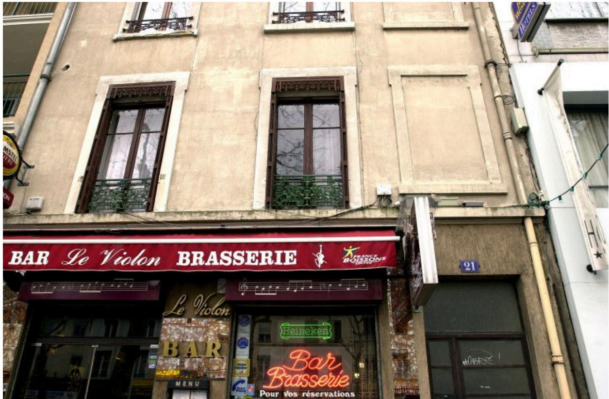
Détail des fenêtres sur rue
