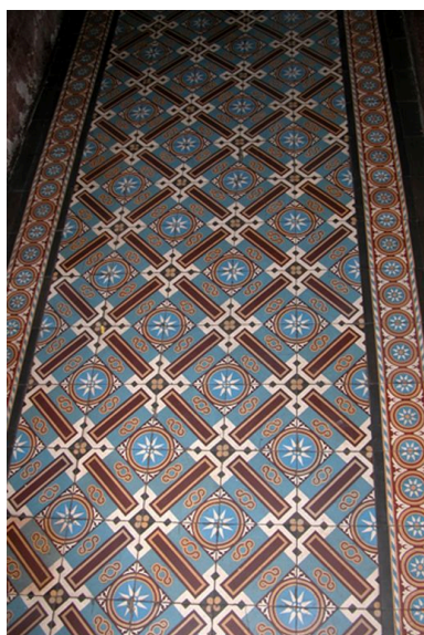
Carrelage du vestibule Phot. N. Giroud IVR82_20046904143NUCA
