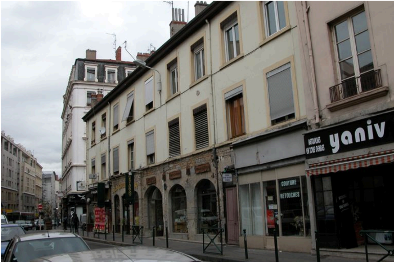
Elévation principale depuis le sud-est
