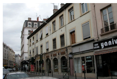
Elévation principale depuis le sud-est Phot. N. Giroud IVR82_20046904132NUCA
