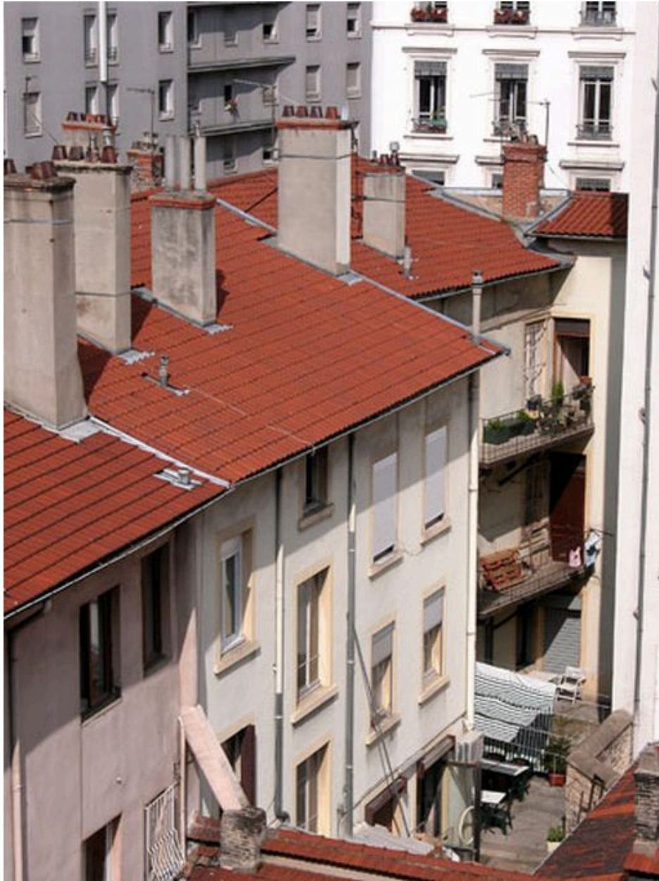
Elévation postérieure depuis un immeuble avenue Jean-Jaurès
