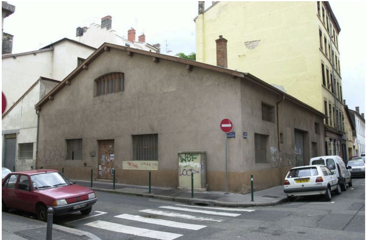
Vue générale depuis l'angle des rues Creuzet et Montesquieu
