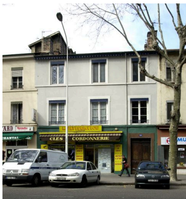
Élévation cours Charlemagne Phot. Maryannick Chalabi IVR82_20016901803NUCA
