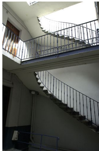
Le système de coursières et de passerelles de la 2e cour Phot. Maryannick Chalabi IVR82_20016901811NUCA
