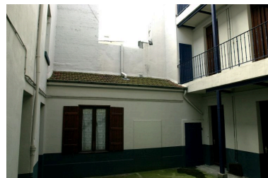
corps de bâtiment latéral de la 1ère cour Phot. Maryannick Chalabi IVR82_20016901807NUCA
