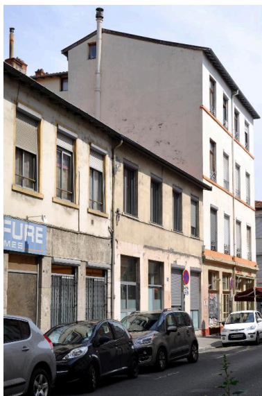
Vue d'ensemble depuis le sud, maison ou atelier en premier plan Phot. Magali Delavenne IVR84_20176901485NUCA
