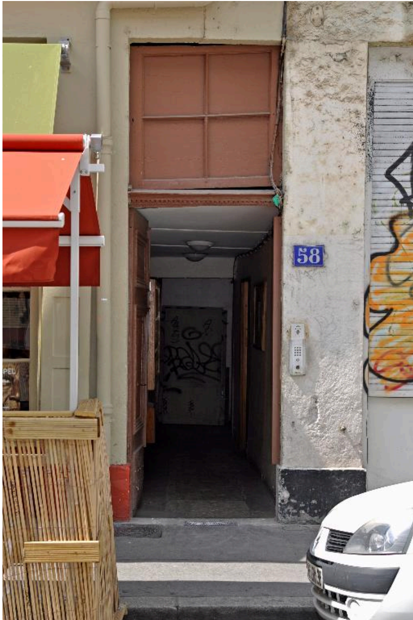
Elévation sur la rue Reinach, détail de la porte
