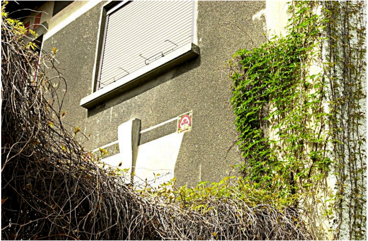
Façade principale, détail du décor
