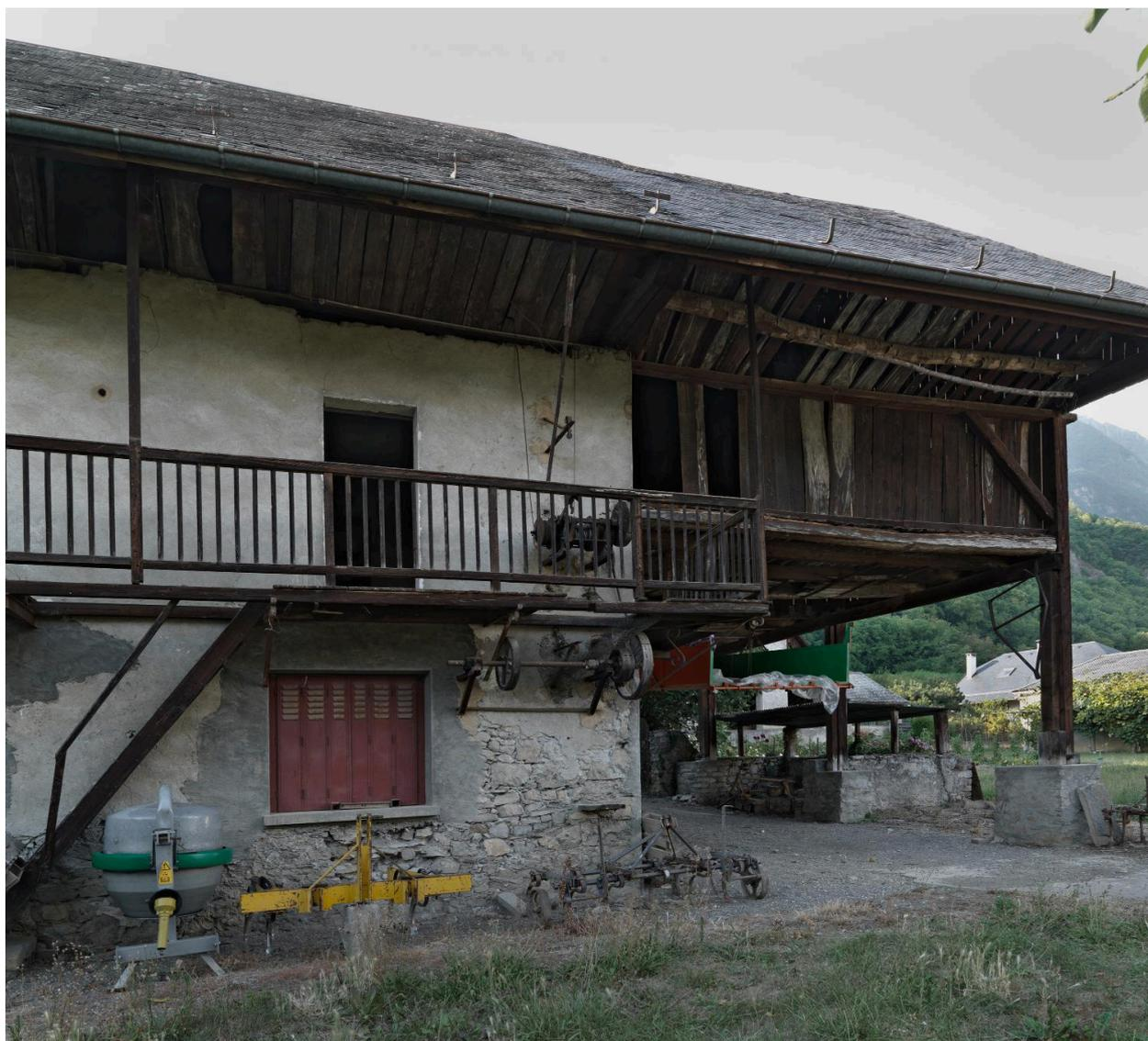
Ferme (2018 C2 371). Fenil ou séchoir en charpente en surplomb au-dessus d'une remise ouverte.
