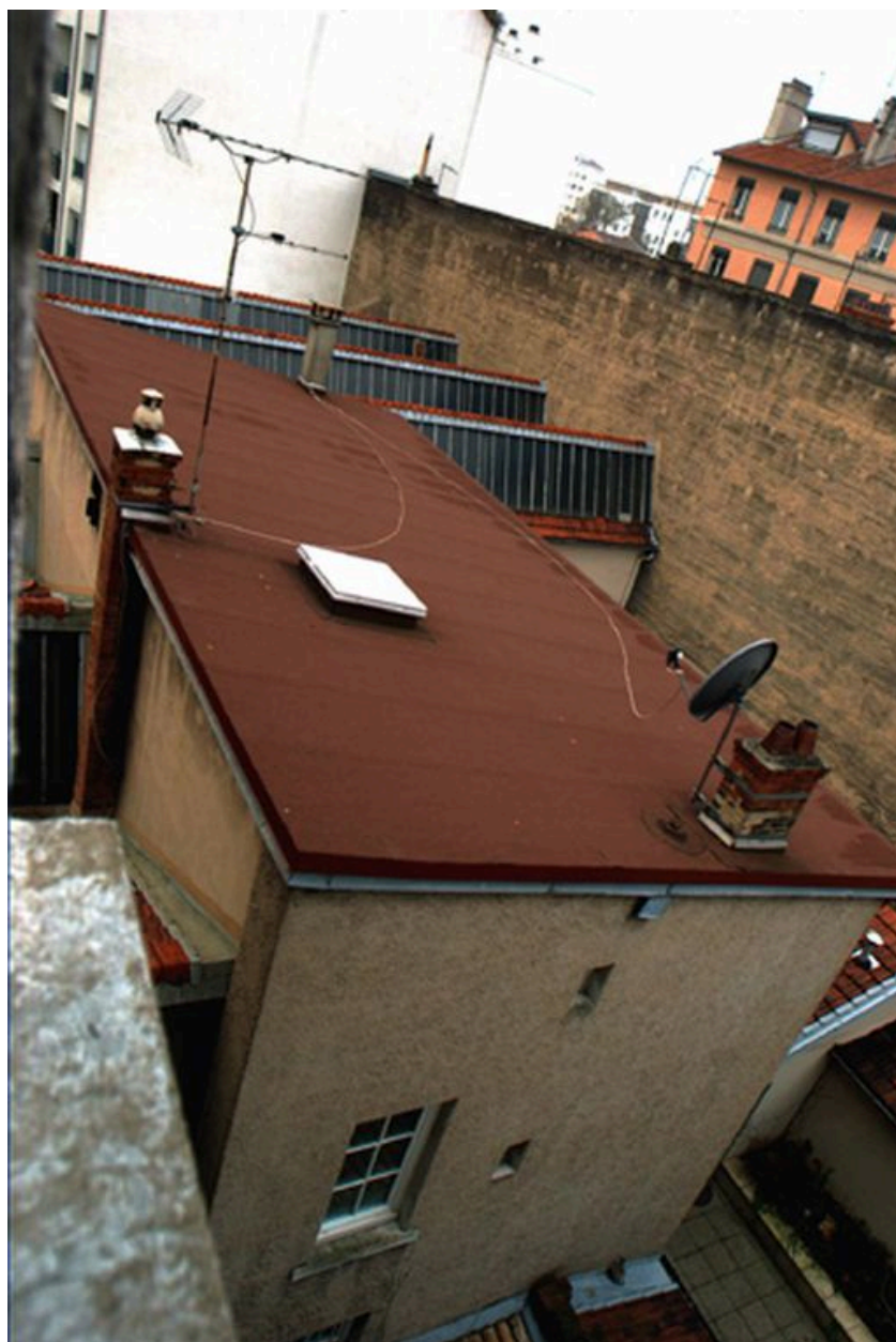
Vue du bâtiment construit à l'ouest de la cour
