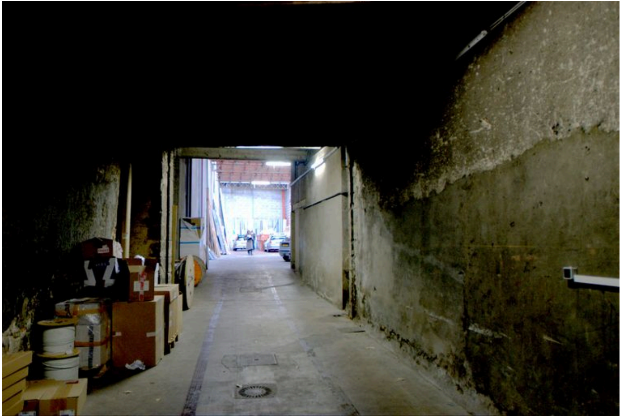
Passage couvert vers les entrepôts construits dans la cour
