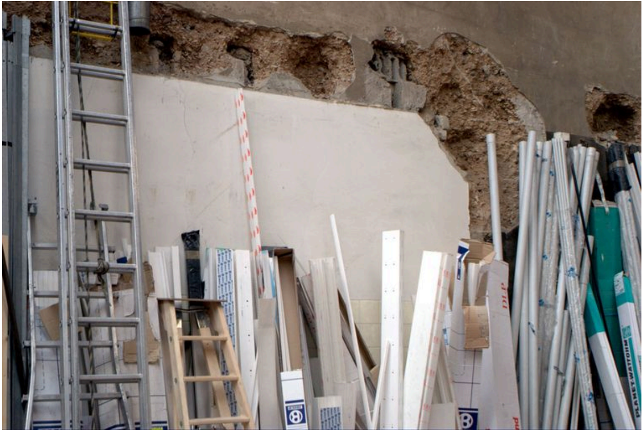
Entrepôts dans la cour, mur est, partie droite
