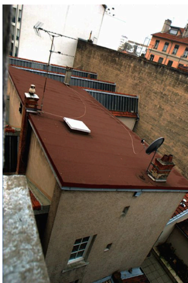
Vue du bâtiment construit à l'ouest de la cour Phot. Maryannick Chalabi IVR82_20086900602NUCA
