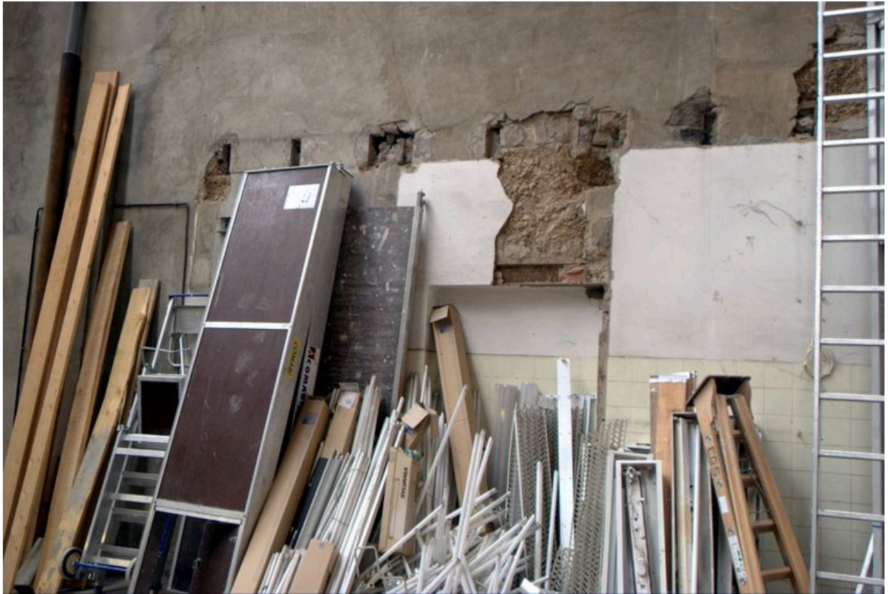
Entrepôts dans la cour, mur est, partie gauche
