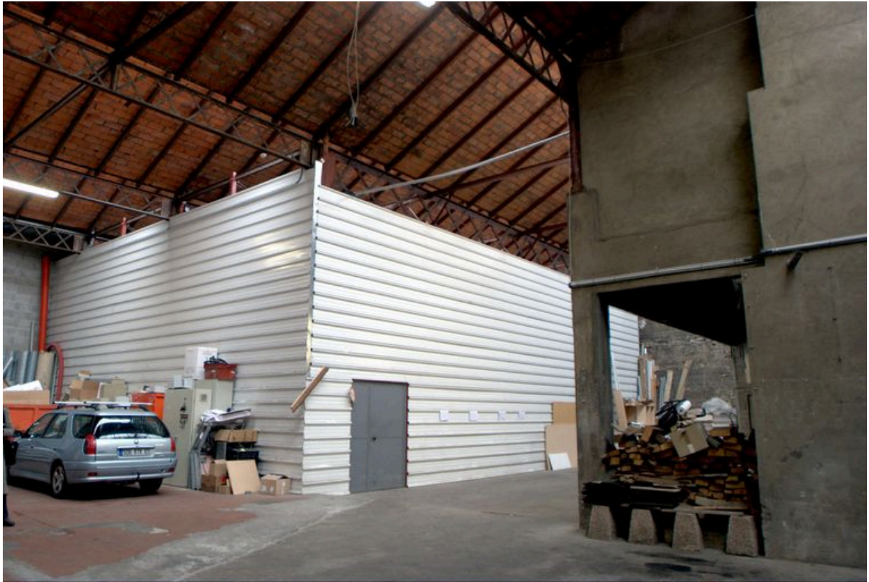
Entrepôts construits dans la cour
