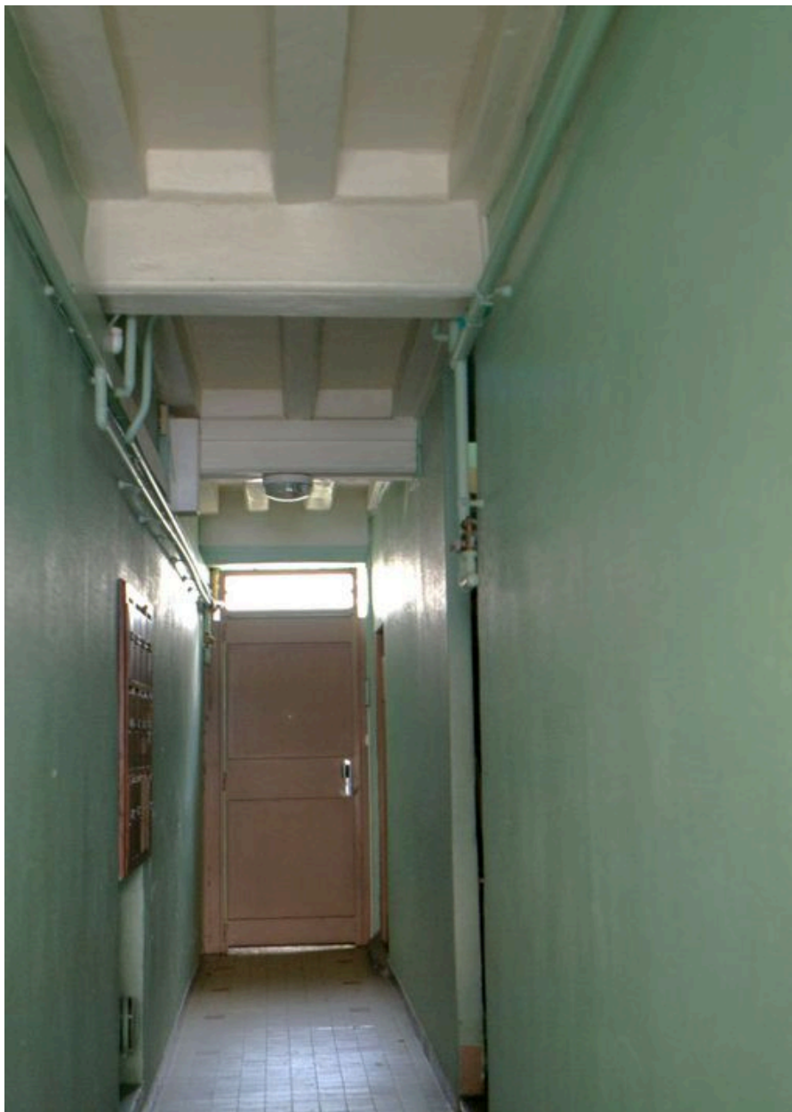
Couloir d'entrée depuis le fond
