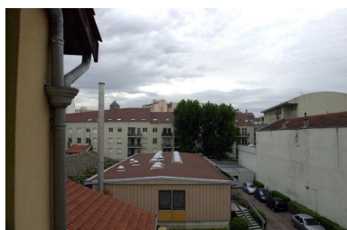
Elévation postérieure du corps de bâtiment rue Alphonse- Daudet, depuis le sud Phot. Maryannick Chalabi IVR82_20076902074NUCA
