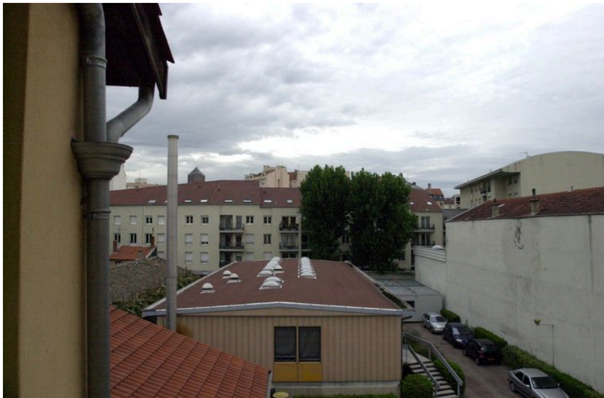
Elévation postérieure du corps de bâtiment rue Alphonse-Daudet, depuis le sud
