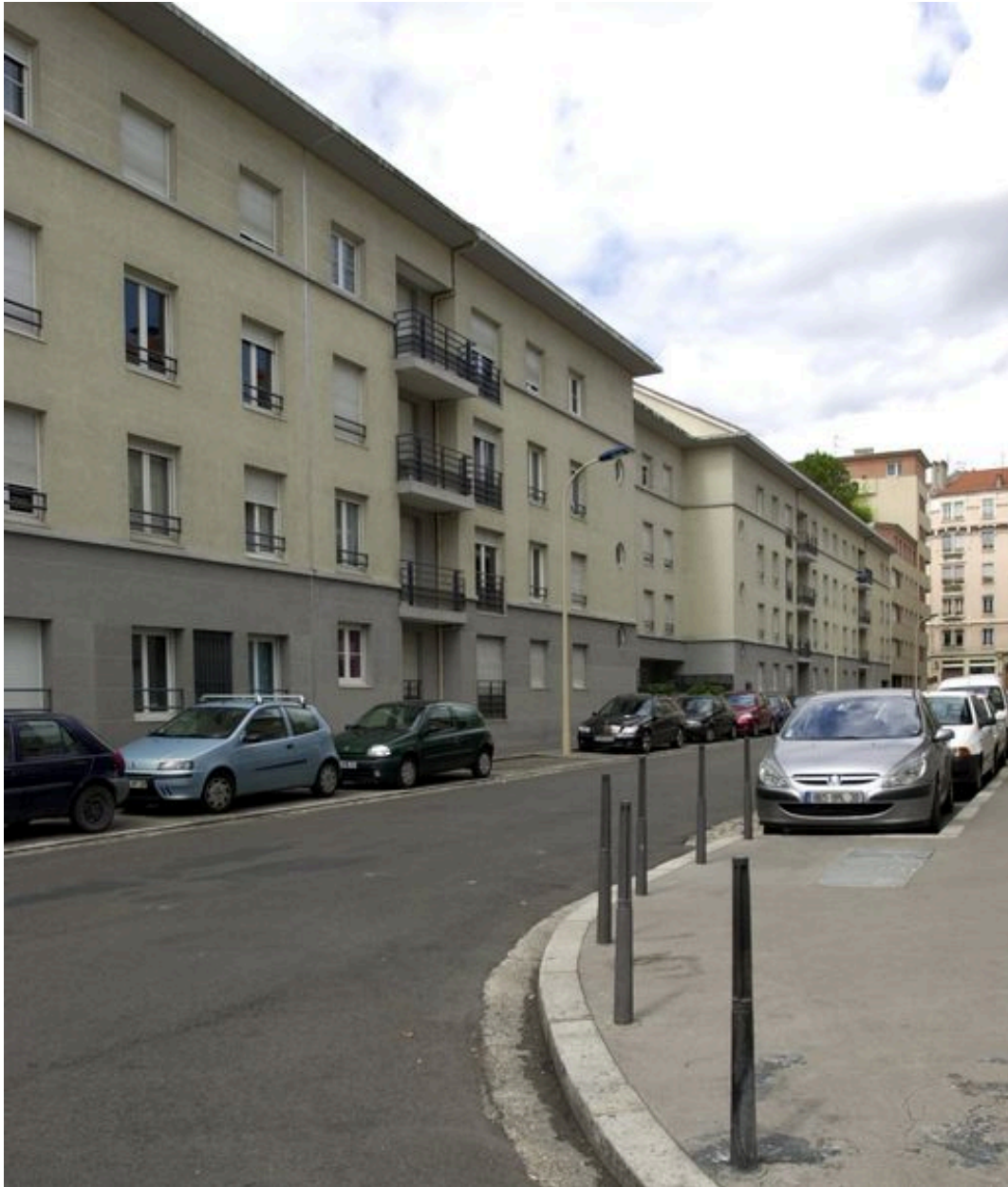
Elévation rue Alphonse-Daudet depuis l'est
