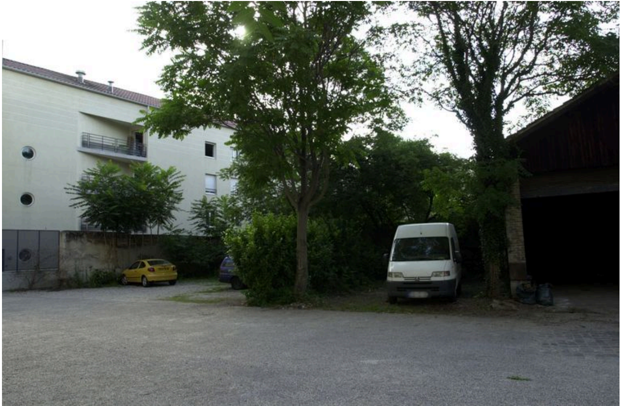
Elévation postérieure depuis la cour du 119 grande rue de la Guillotière
