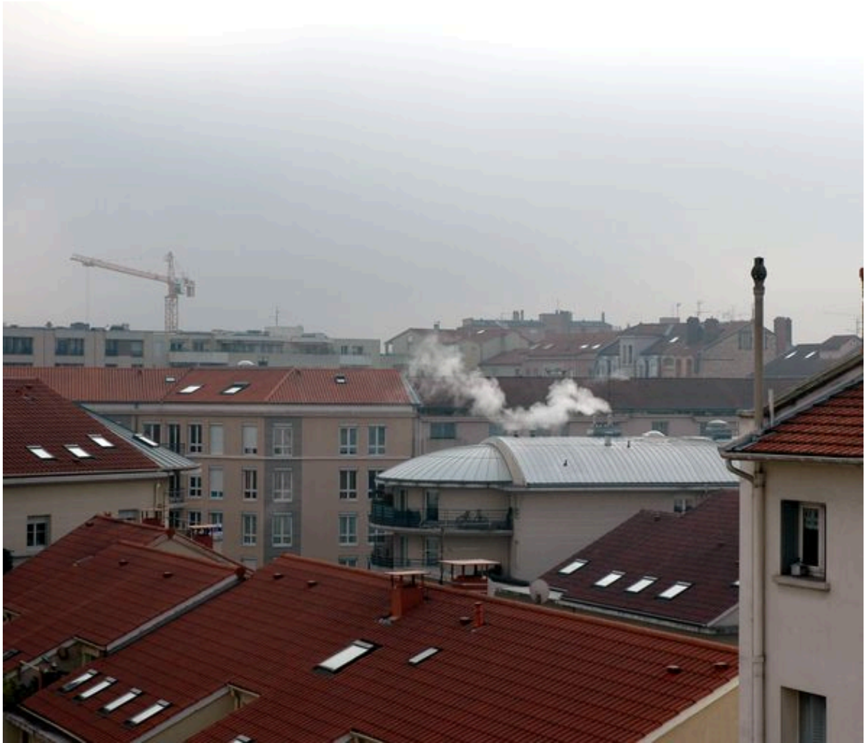
Détail des toits depuis le sud-ouest
