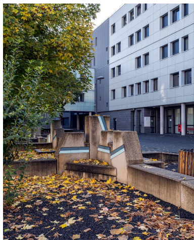
Vue d'ensemble depuis l'ouest Phot. Michel Pérès IVR84_20256302203NUCA
