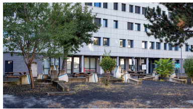
Vue générale Phot. Michel Pérès IVR84_20256302201NUCA
