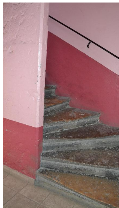
Départ de l'escalier Phot. Noémie Caillat IVR82_20156900135NUCA
