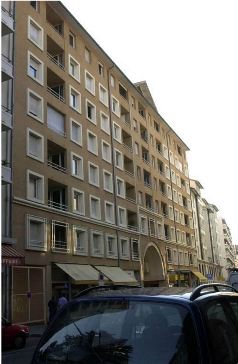
Elévation principale depuis le sud-ouest
