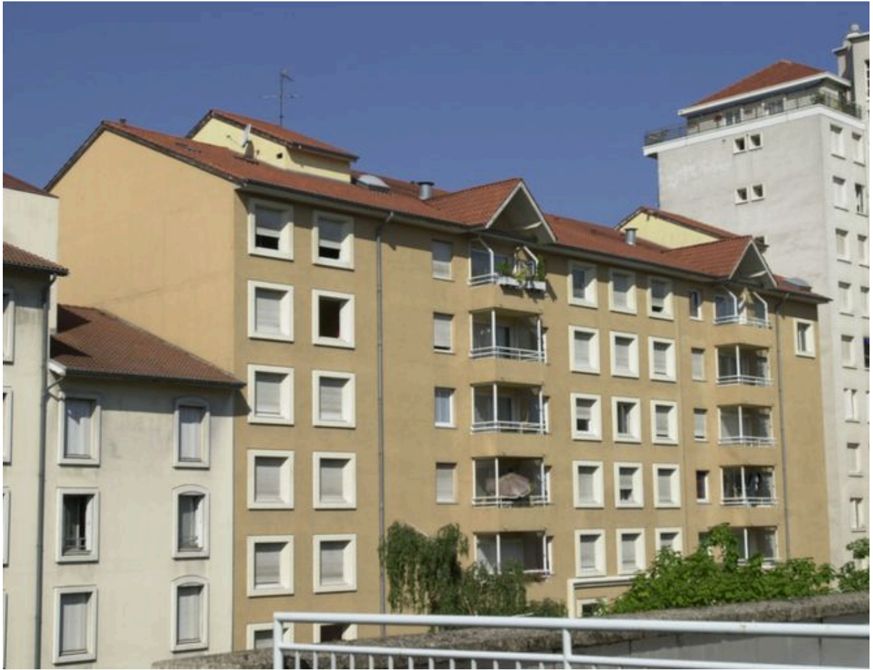
Vue d'ensemble de l'élévation postérieure
