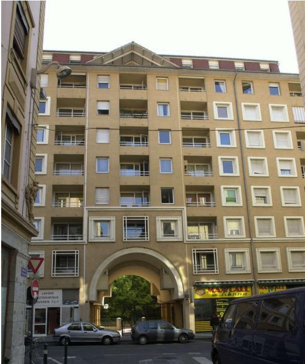
Travée centrale et passage couvert d'entrée
