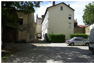
Vue générale depuis le nord Phot. Maryannick Chalabi IVR82_20106903652NUCA
