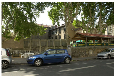
Elévation postérieure, vue depuis l'est Phot. Maryannick Chalabi IVR82_20106903659NUCA
