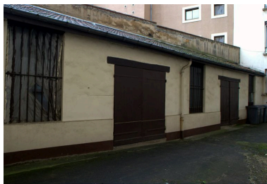
Vue d'ensemble des dépendances dans la cour Phot. Maryannick Chalabi IVR82_20086900782NUCA
