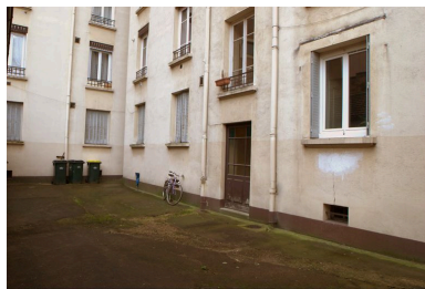
Vue d'ensemble de la cour Phot. Maryannick Chalabi IVR82_20086900781NUCA
