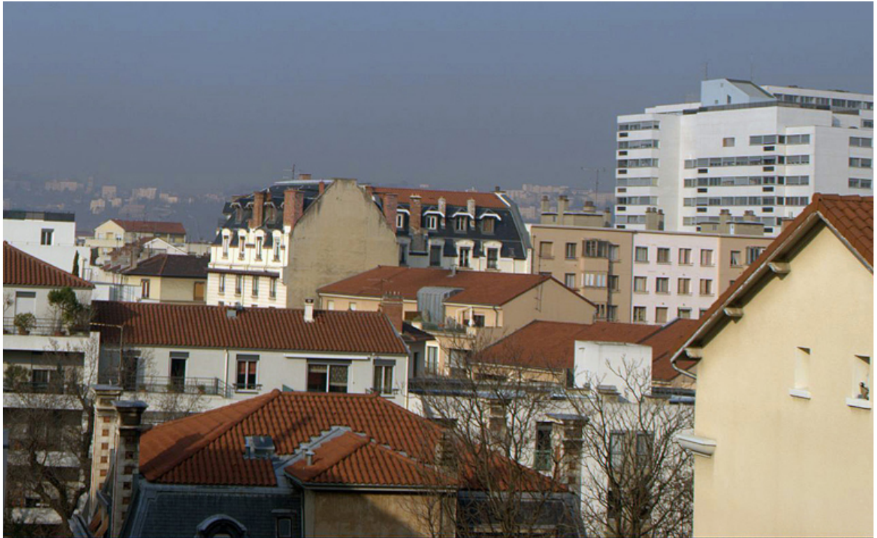
Vue d'ensemble des niveaux supérieurs, depuis l'est
