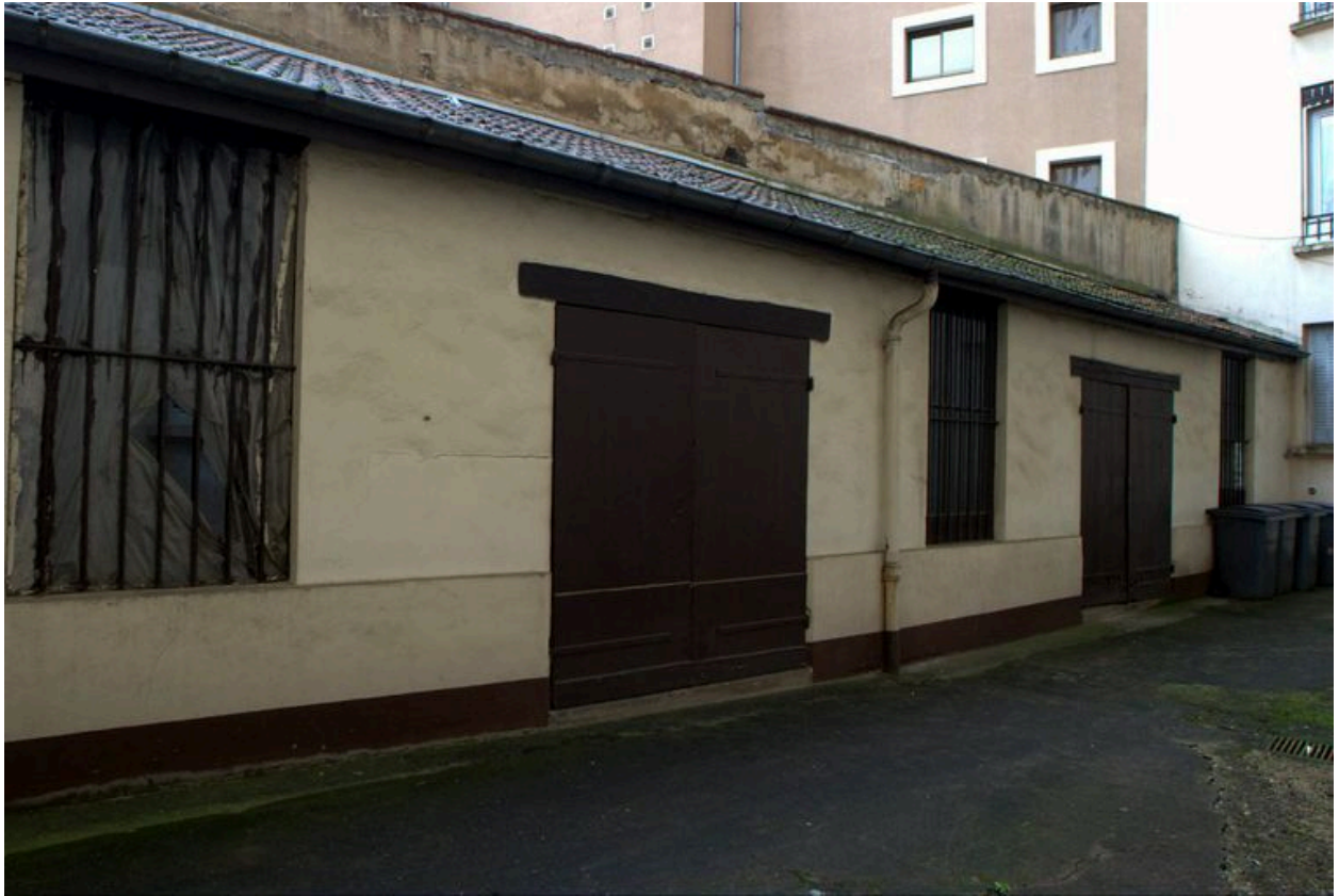
Vue d'ensemble des dépendances dans la cour
