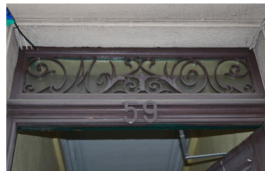
Imposte en ferronnerie, au monogramme "MO" des constrcteurs Marchetti et Orat Phot. Magali Delavenne IVR84_20166902275NUCA
