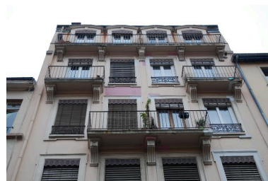
Vue des étages supérieurs, dispositif de balcons pyramidants Phot. Magali Delavenne IVR84_20166902273NUCA
