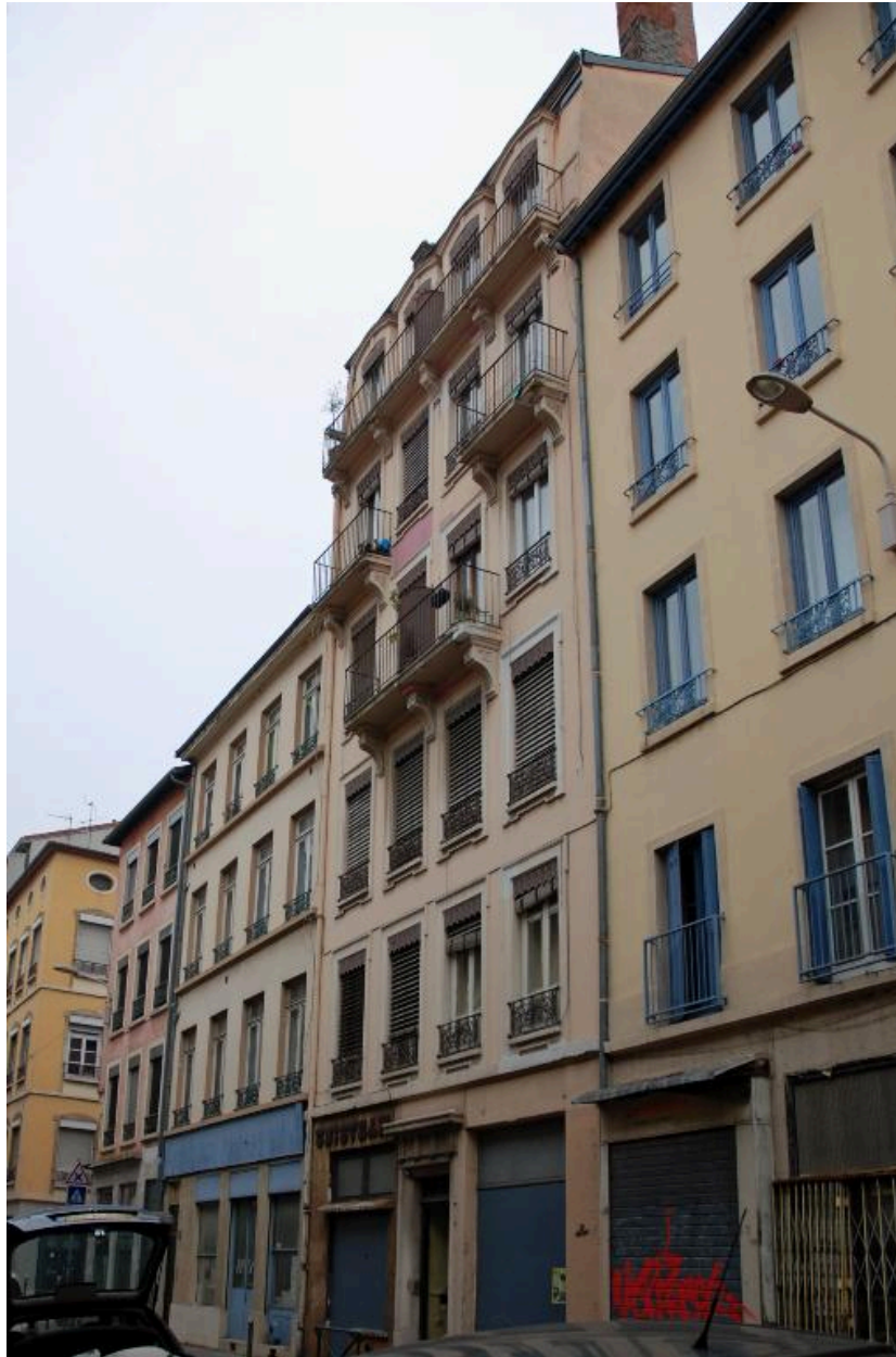
Elévation sur rue, vue d'ensemble
