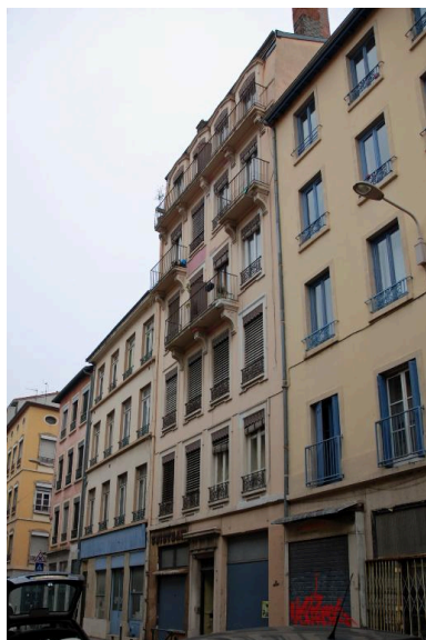
Elévation sur rue, vue d'ensemble Phot. Magali Delavenne IVR84_20166902271NUCA
