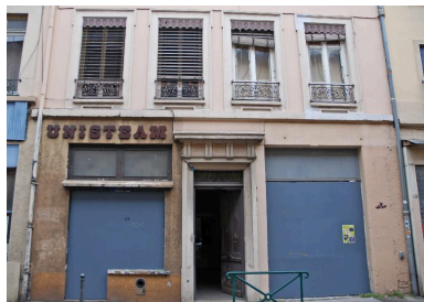
Vue du rez-de-chaussée, boutiques désaffectées Phot. Magali Delavenne IVR84_20166902272NUCA
