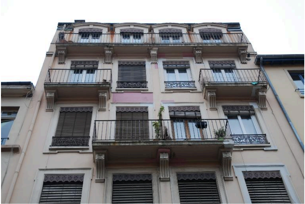
Vue des étages supérieurs, dispositif de balcons pyramidants
