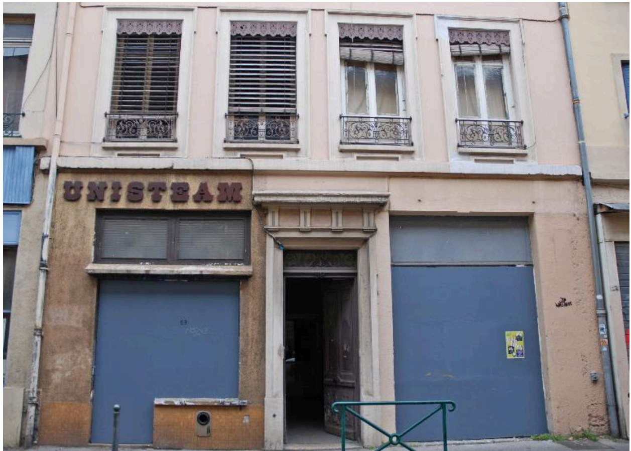
Vue du rez-de-chaussée, boutiques désaffectées
