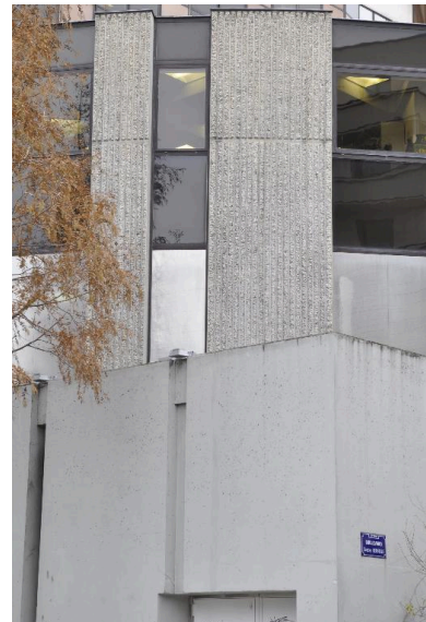
Détail des deux niveaux du socle en béton Phot. Magali Delavenne IVR82_20156902697NUCA
