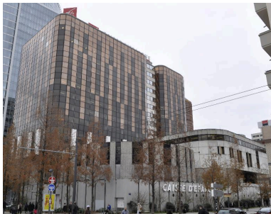
Vue générale depuis le nord-est Phot. Magali Delavenne IVR82_20156902715NUCA
