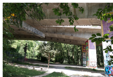
Viaduc de Cran, vue du dessous en rive gauche, côté amont Phot. Pascale Renard IVR84_20207403860NUCA
