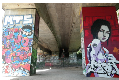
Viaduc de Cran, vue des piles et culée rive gauche Phot. Pascale Renard IVR84_20207403863NUCA
