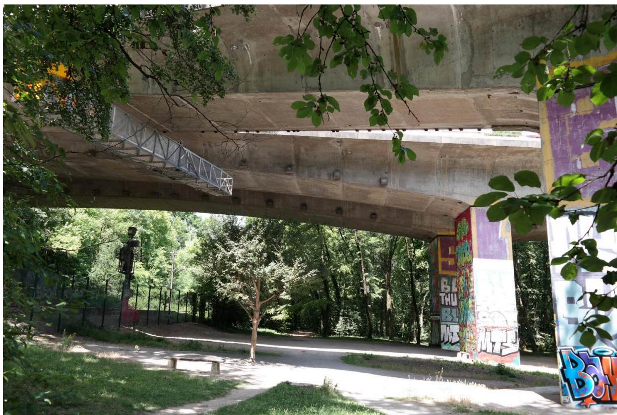
Viaduc de Cran, vue du dessous en rive gauche, côté amont
