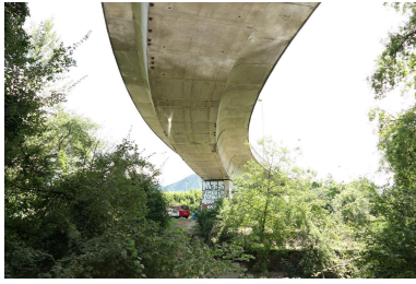
Viaduc de Cran, vue de la courbe de la bretelle de sortie Phot. Pascale Renard IVR84_20207403866NUCA
