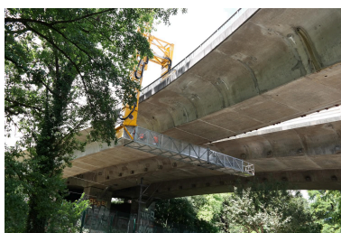
Viaduc de Cran, visite d'inspection Phot. Pascale Renard IVR84_20207403861NUCA
