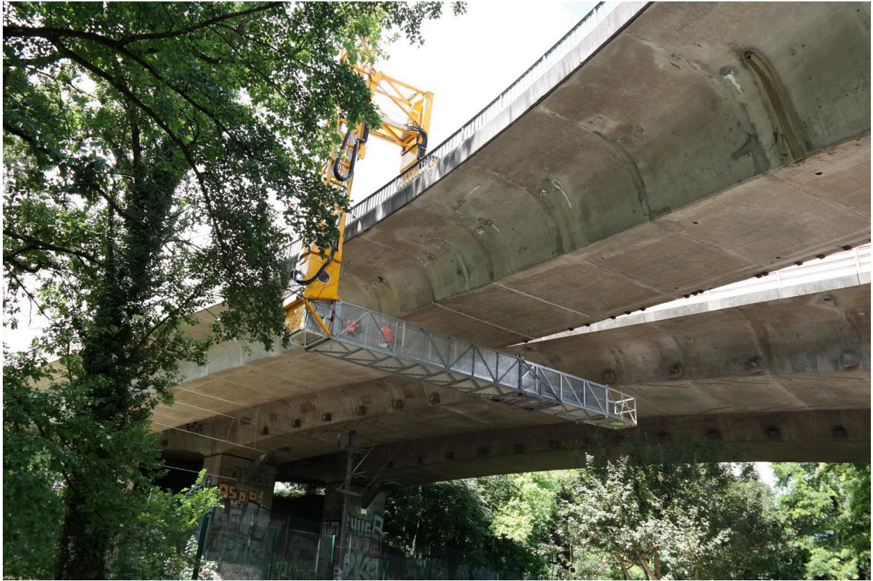
Viaduc de Cran, visite d'inspection
