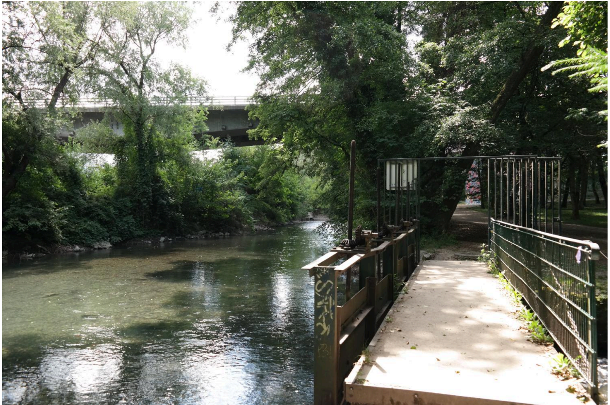
Viaduc de Cran, vue de la face aval
