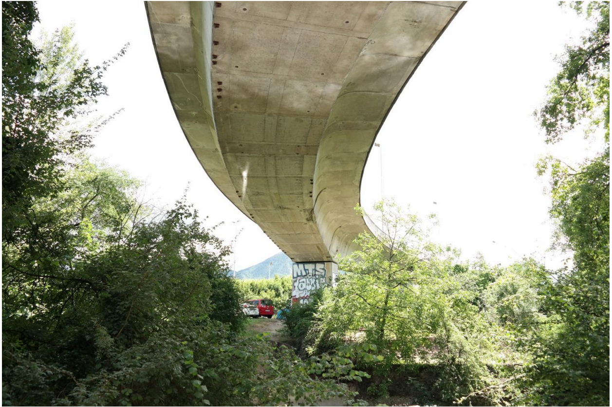
Viaduc de Cran, vue de la courbe de la bretelle de sortie
