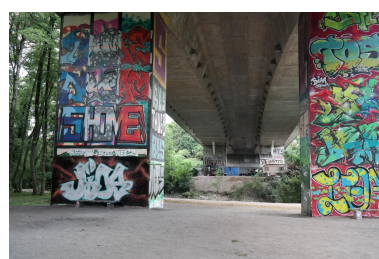
Viaduc de Cran, vue de la culée rive droite
