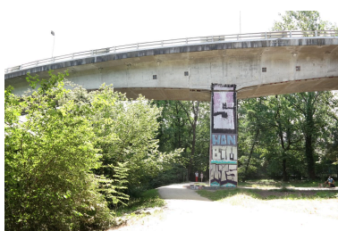
Viaduc de Cran, vue de la bretelle Phot. Pascale Renard
