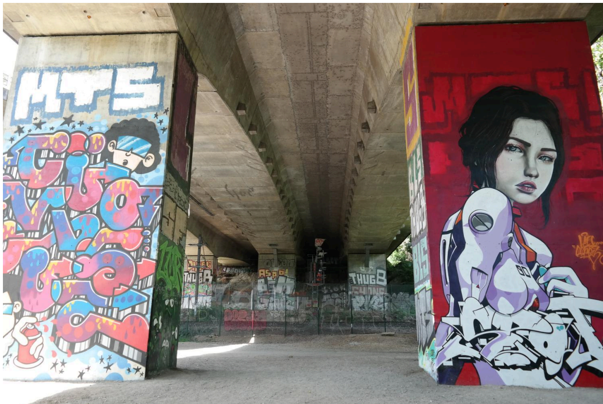
Viaduc de Cran, vue des piles et culée rive gauche
