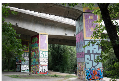
Viaduc de Cran, vue de la rive gauche en dessous Phot. Pascale Renard IVR84_20207403859NUCA
