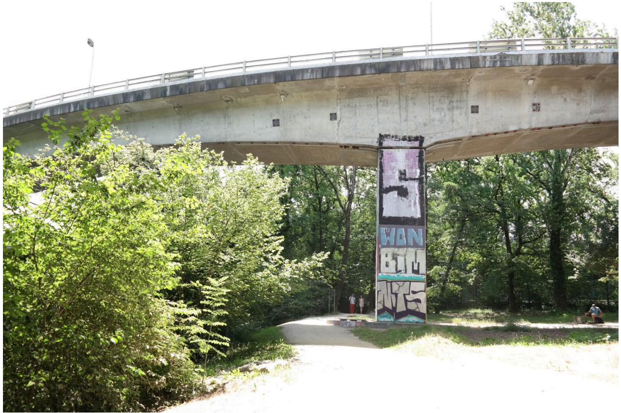
Viaduc de Cran, vue de la bretelle
