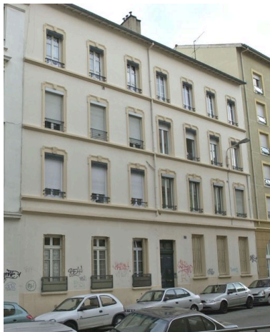
Façade sur la rue Béguin Phot. Maryannick Chalabi IVR82_20066901289NUCA
