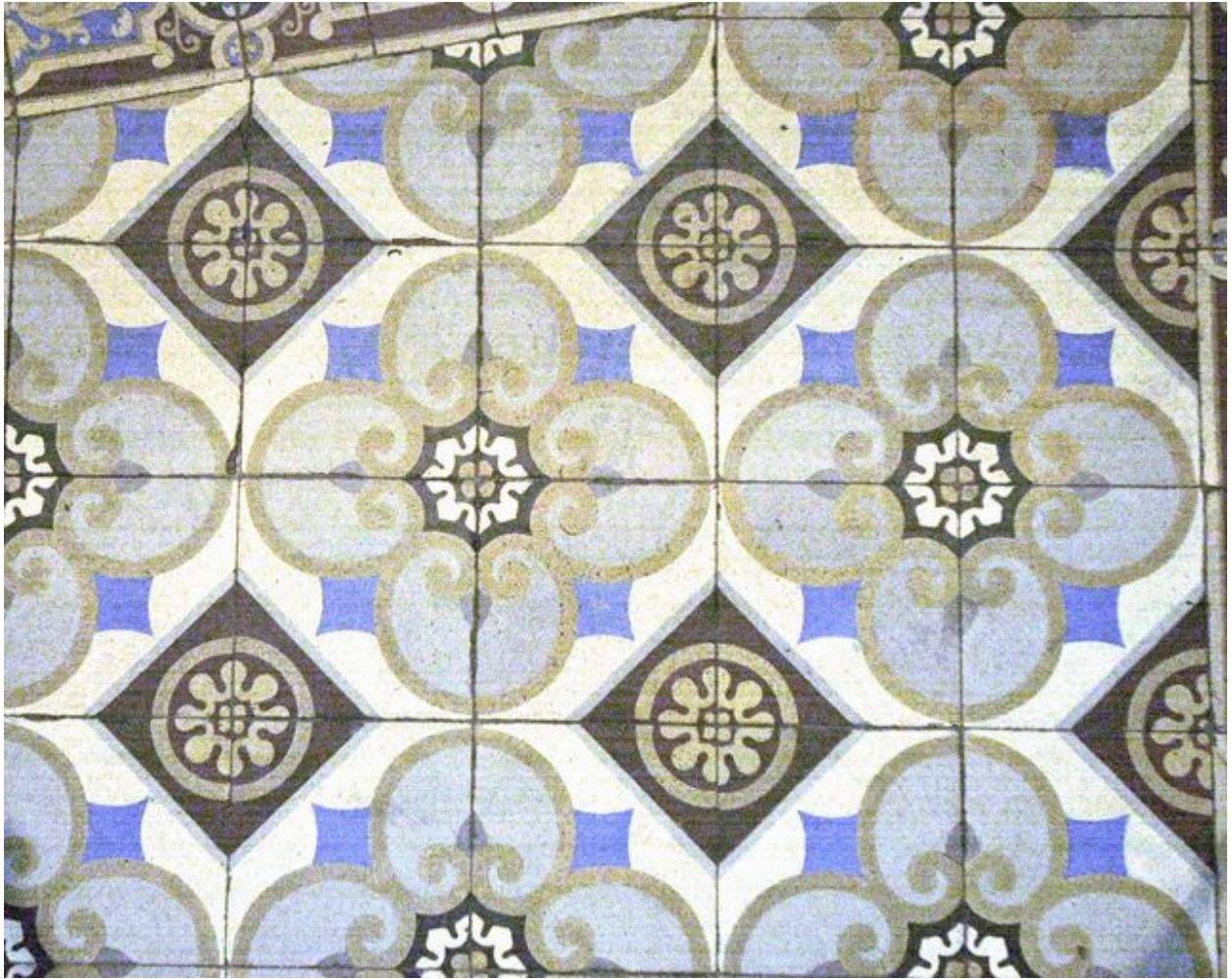
Motif du carrelage en ciment moulé du vestibule
