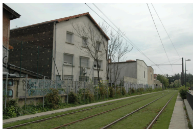
Vue ouest Phot. Nadine Halitim-Dubois IVR84_20186901431NUCA
