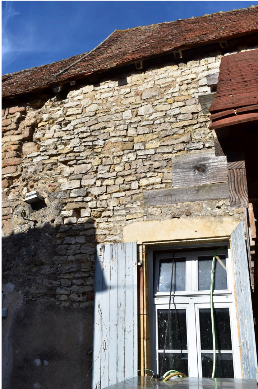
Détail du mur gouttereau méridional;
