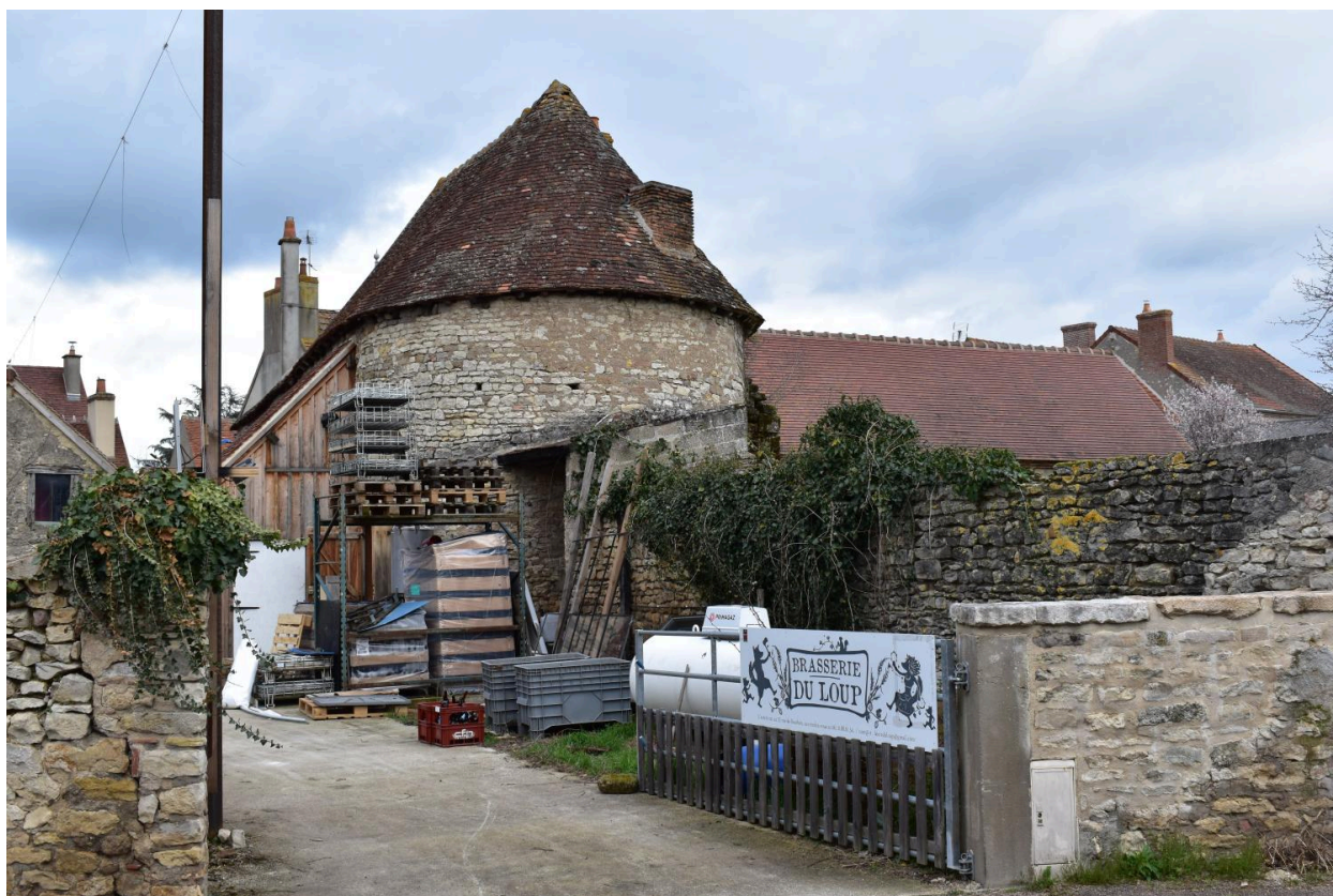
Vue générale des vestiges de l'abside au sud-est.
