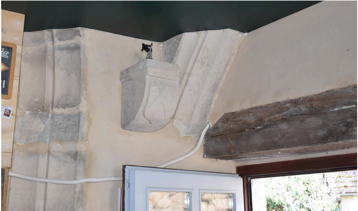
Détail du piédroit de l'arc doubleau de la nef, corbeau et début de l'arc d'accès à la chapelle Alarose détruite
