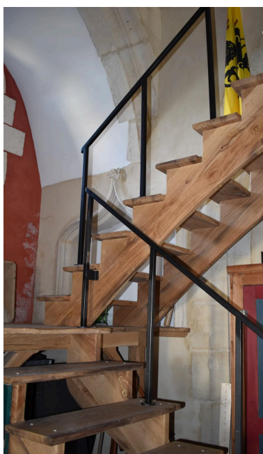
Entrée de la chapelle Normandeau. Phot. Maryse Durin-Tercelin IVR84_20250300208NUCA
