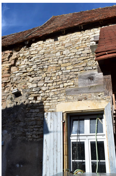
Détail du mur gouttereau méridional; Phot. Maryse Durin-Tercelin IVR84_20250300518NUCA
