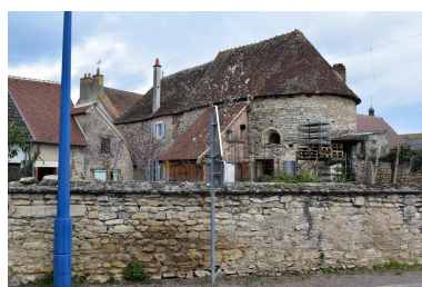
Vue générale du mur gouttereau sud et de l'abside au sud-est Phot. Maryse Durin-Tercelin IVR84_20250300204NUCA
