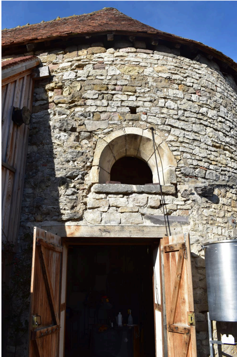
Vestige d'une baie en plein cintre de l'abside, au sud-est.
