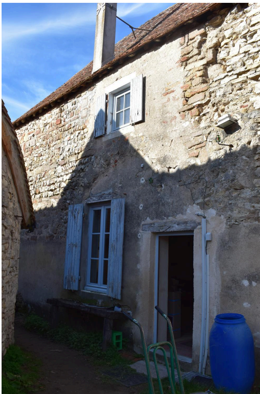
Détail du mur gouttereau méridional.
