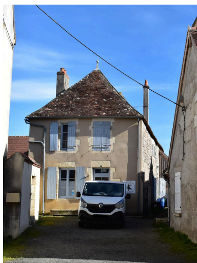
Façade occidentale transformée en pignon de maison couvert en croupe. Phot. Maryse Durin-Tercelin IVR84_20250300206NUCA
