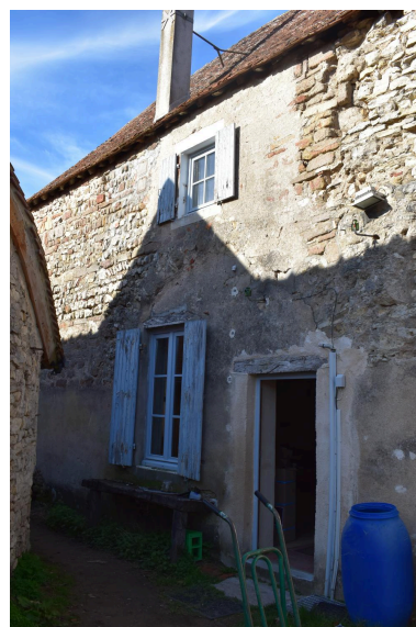
Détail du mur gouttereau méridional. Phot. Maryse Durin-Tercelin IVR84_20250300519NUCA
