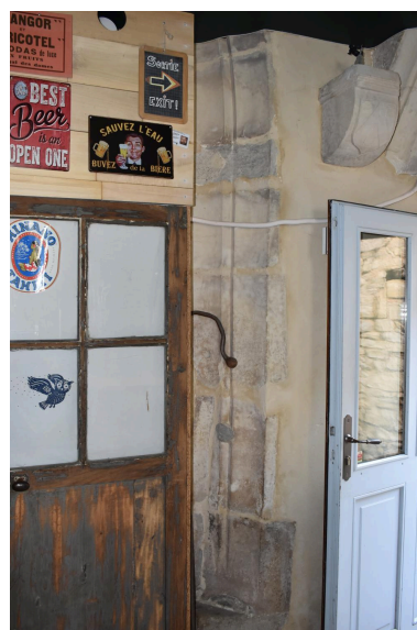
Piédroit de l'arc doubleau de la nef, corbeau et début de l'arc d'accès à la chapelle Alarose détruite. Phot. Maryse Durin-Tercelin IVR84_20250300512NUCA
