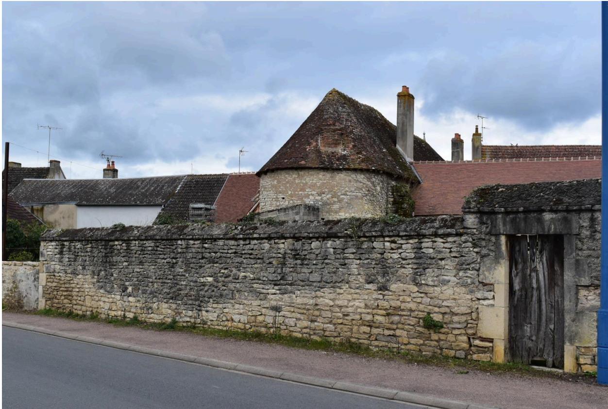
Vue générale de l'abside et du rempart au sud-est
