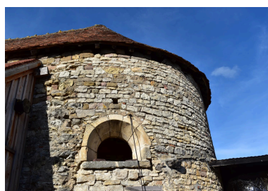
Détail du vestige d'une baie en plein cintre de l'abside, au sud-est. Phot. Maryse Durin-Tercelin IVR84_20250300516NUCA
