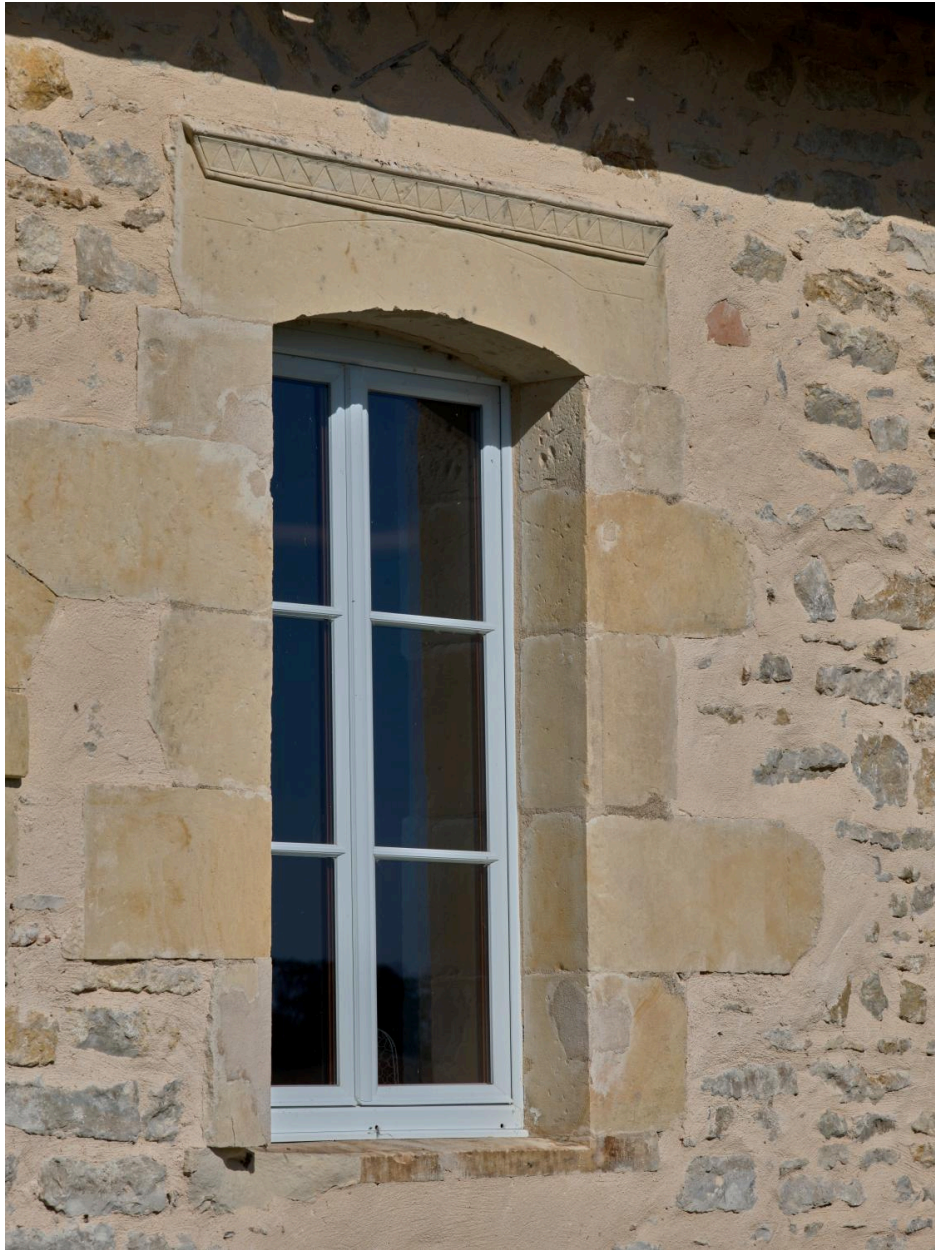
Détail d'une fenêtre au linteau sculpté et gravé, au sud du bâtiment méridional.
