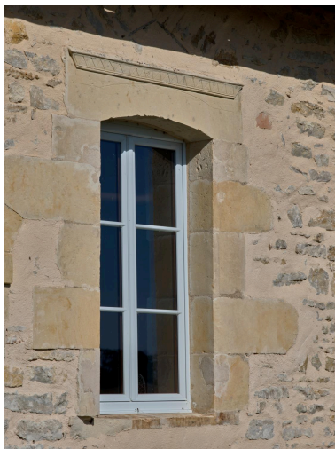
Détail d'une fenêtre au linteau sculpté et gravé, au sud du bâtiment méridional. Phot. Christian Parisey IVR84_20230300415NUC4A
