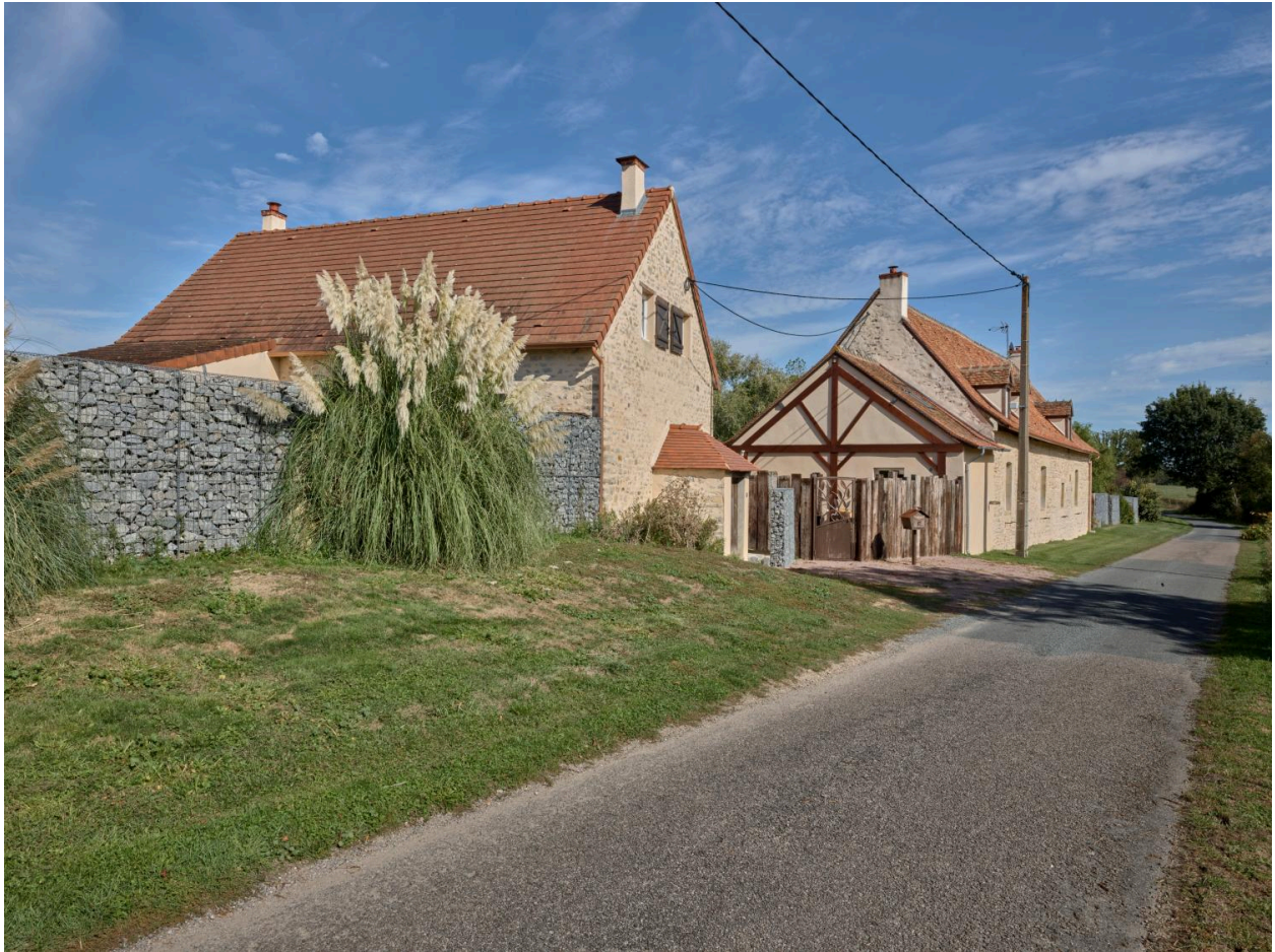
Vue du sud ouest.
