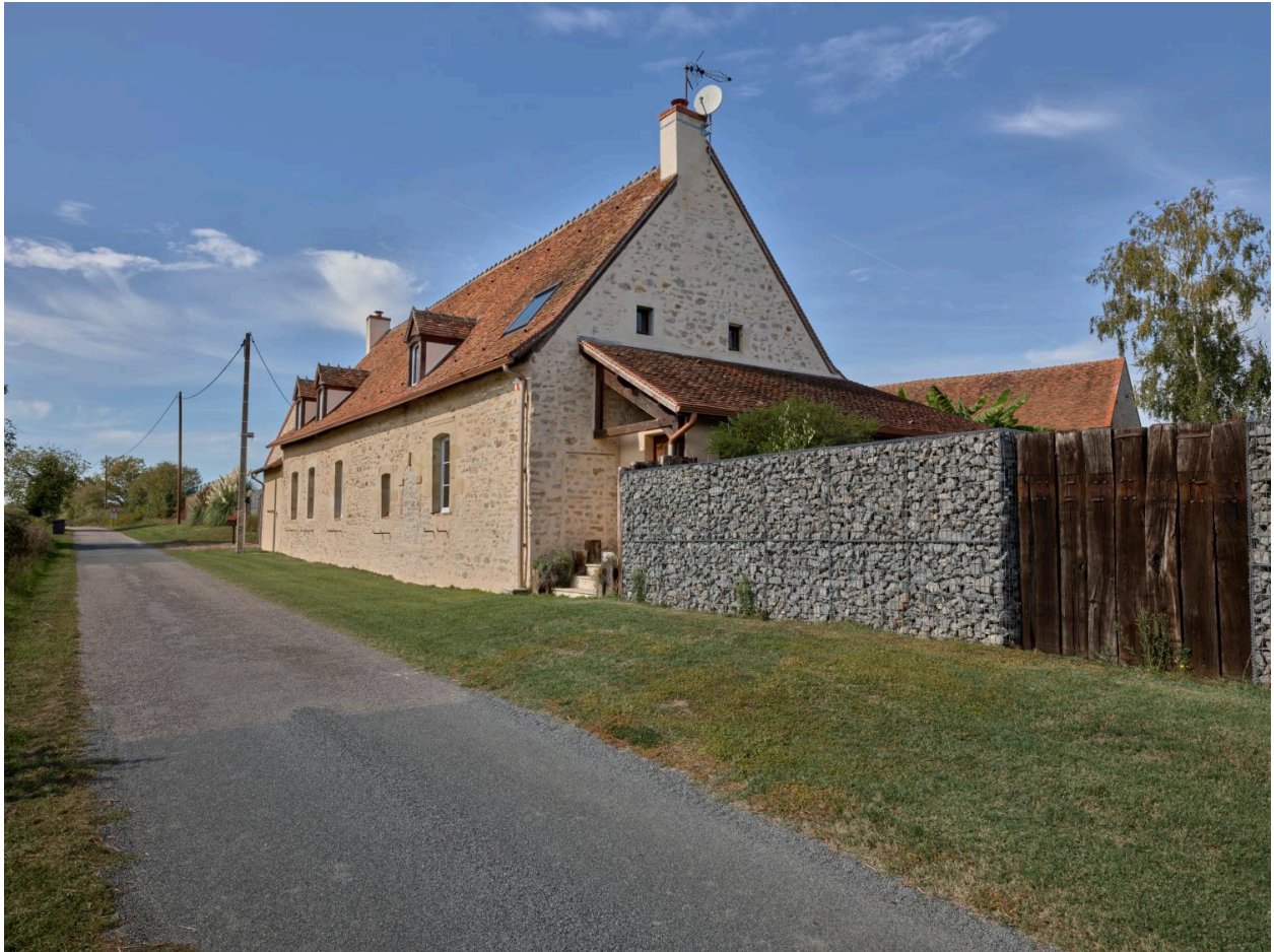
Vue côté sud du bâtiment méridional.
