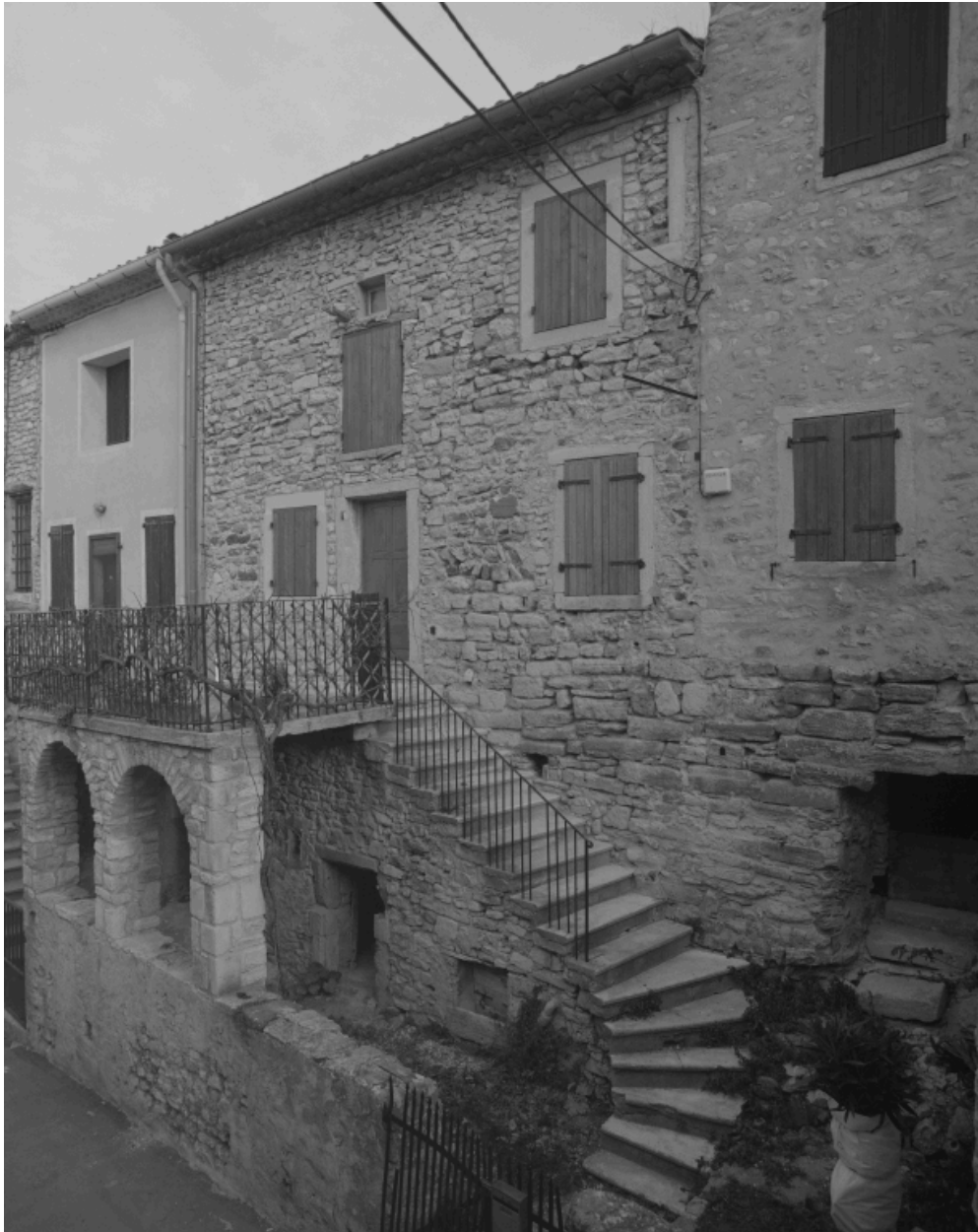
Le Pègue, Village. Maison (B3 650), Façade sur rue.
