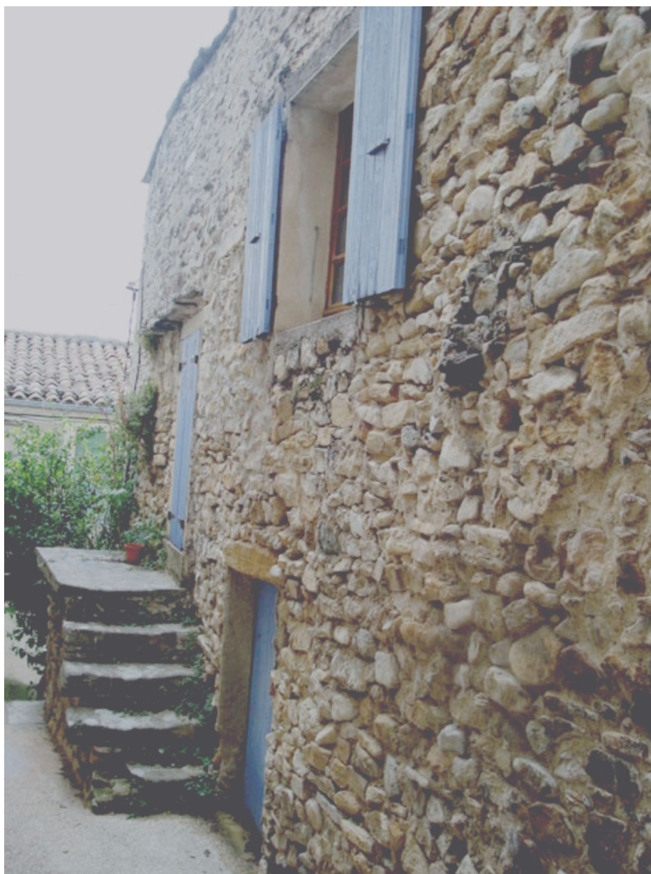
Le Pègue, rue Traversière. Maison (B3 1037), façade, vue partielle.
