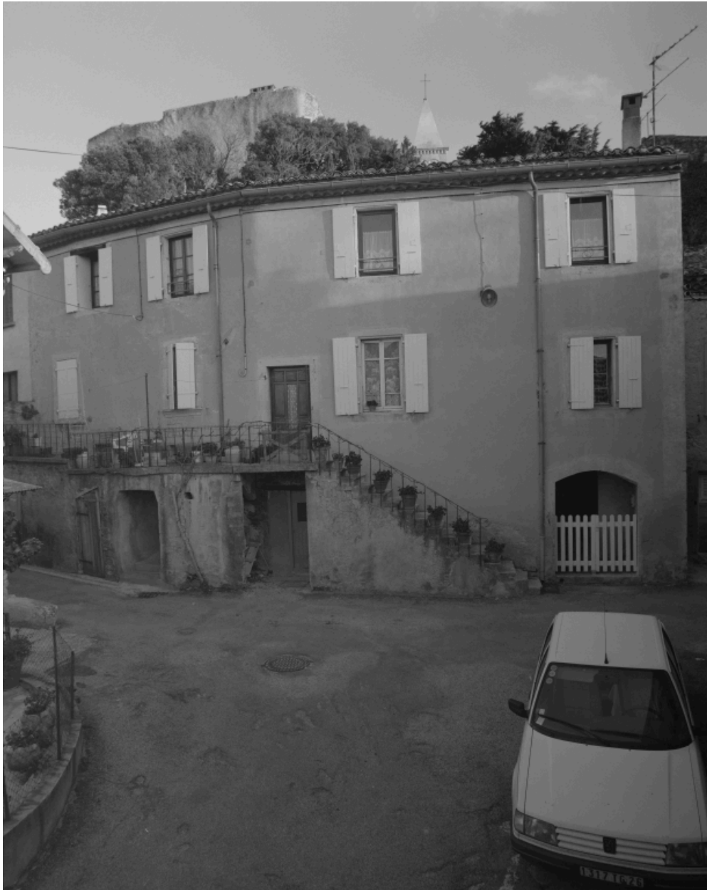
Le Pègue, rue de la Bourgade. Façades des maisons (B3 632, 632 bis).
