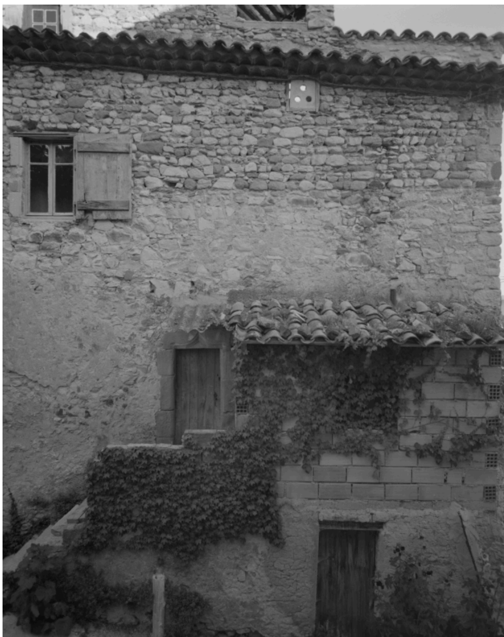
Rousset-les-Vignes, rue des Dauphins (RD 538) - rue du Valat. Maison (C1 108), élévation postérieure, détail.
