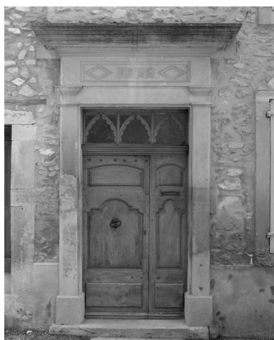
Rousset-les-Vignes, rue des Dauphins (RD 538). Maison (C1 131), façade, détail de la porte. Phot. Alain Franchella IVR82_19982600497X
