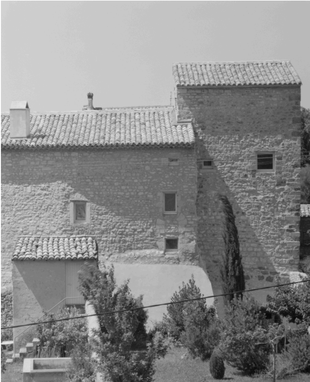
Rousset-les-Vignes, rue des Alrics. Maison (C1 14), vue partielle de l'élévation est.
