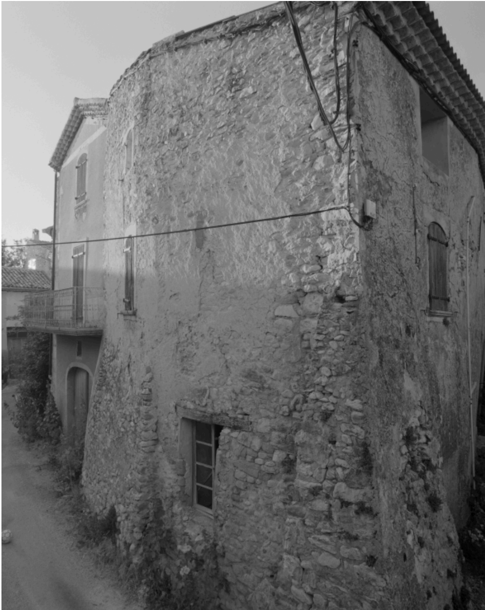
Rousset-les-Vignes, rue du Bourg. Maison (C1 150), vue de trois quarts.
