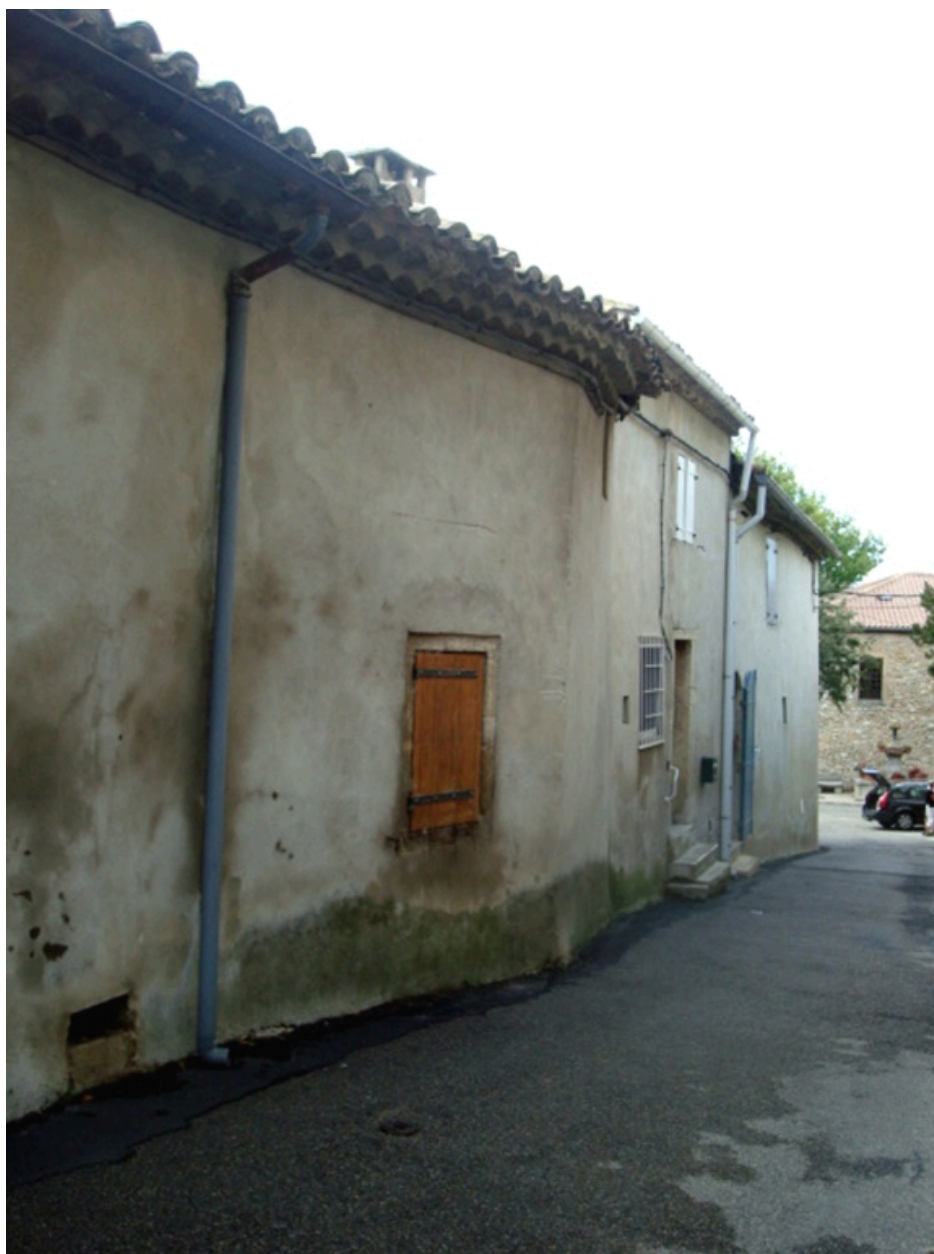
Le Pègue, Grand'rue. Maison (B3 648), élévation postérieure sur la rue haute.
