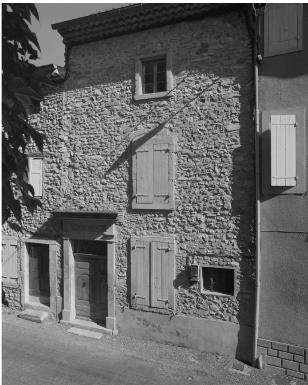
Rousset-les-Vignes, rue des Dauphins (RD 538). Maison (C1 131), façade.
