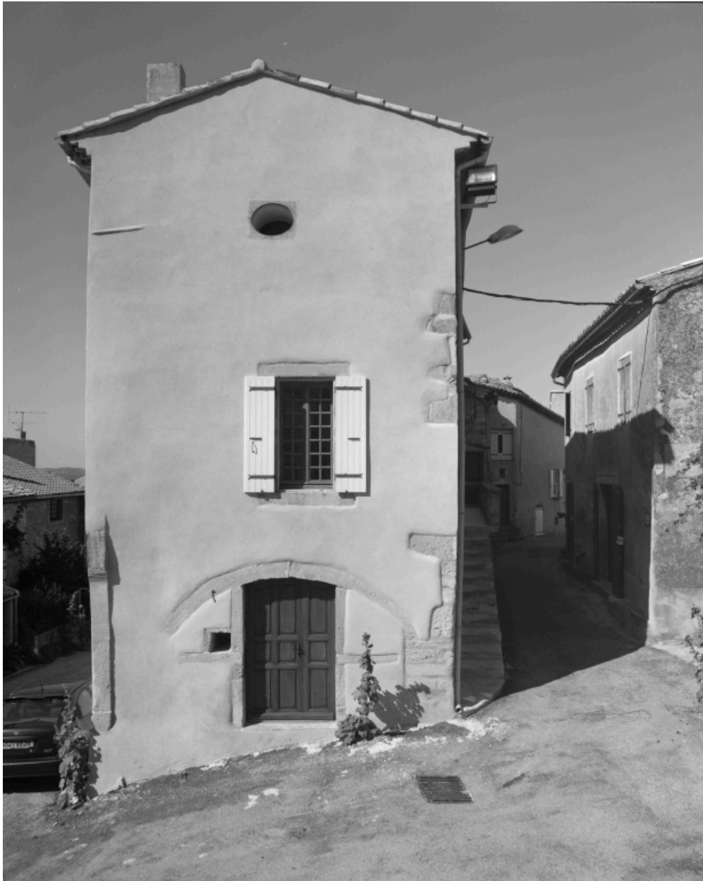
Rousset-les-Vignes, place du Prieuré. Maison (C1 62), mur pignon sur la place.
