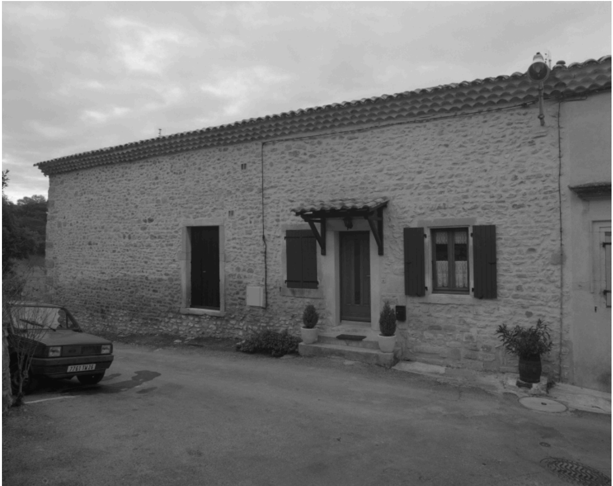
Le Pègue, Grand'rué. Maison (B3 676), élévation principale sur rue.
