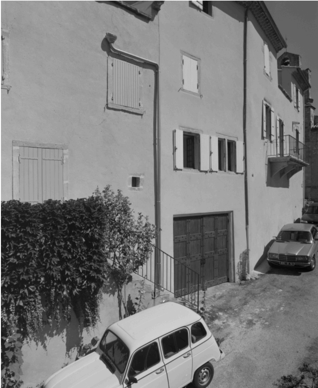
Rousset-les-Vignes, rue du Valat. Elévation partielle des maisons C1 62 et C1 1094.
