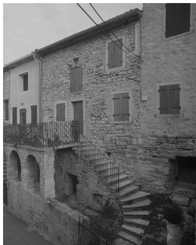
Le Pègue, Village. Maison (B3 650), Façade sur rue. Phot. Alain Franchella IVR82_19982600950X
