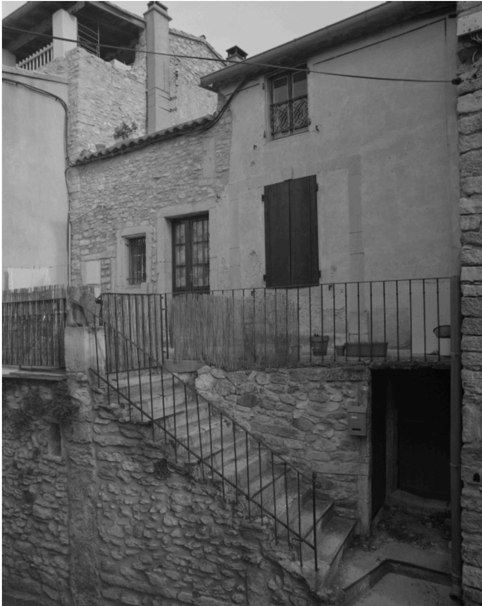
Le Pègue, Village. Maison (B3 664), vue partielle de l'élévation principale sur la rue haute.
