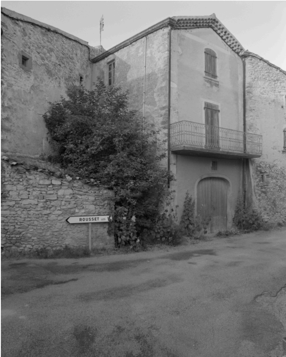
Rousset-les-Vignes, rue du Bourg. Maison (C 1145), élévation antérieure.
