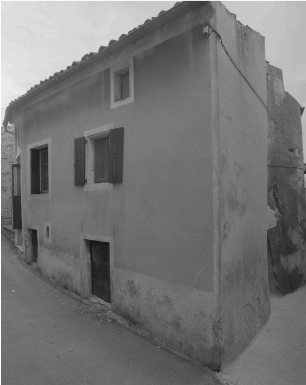
Le Pègue, Village. Maison (B3 670), façade sur la rue haute.
