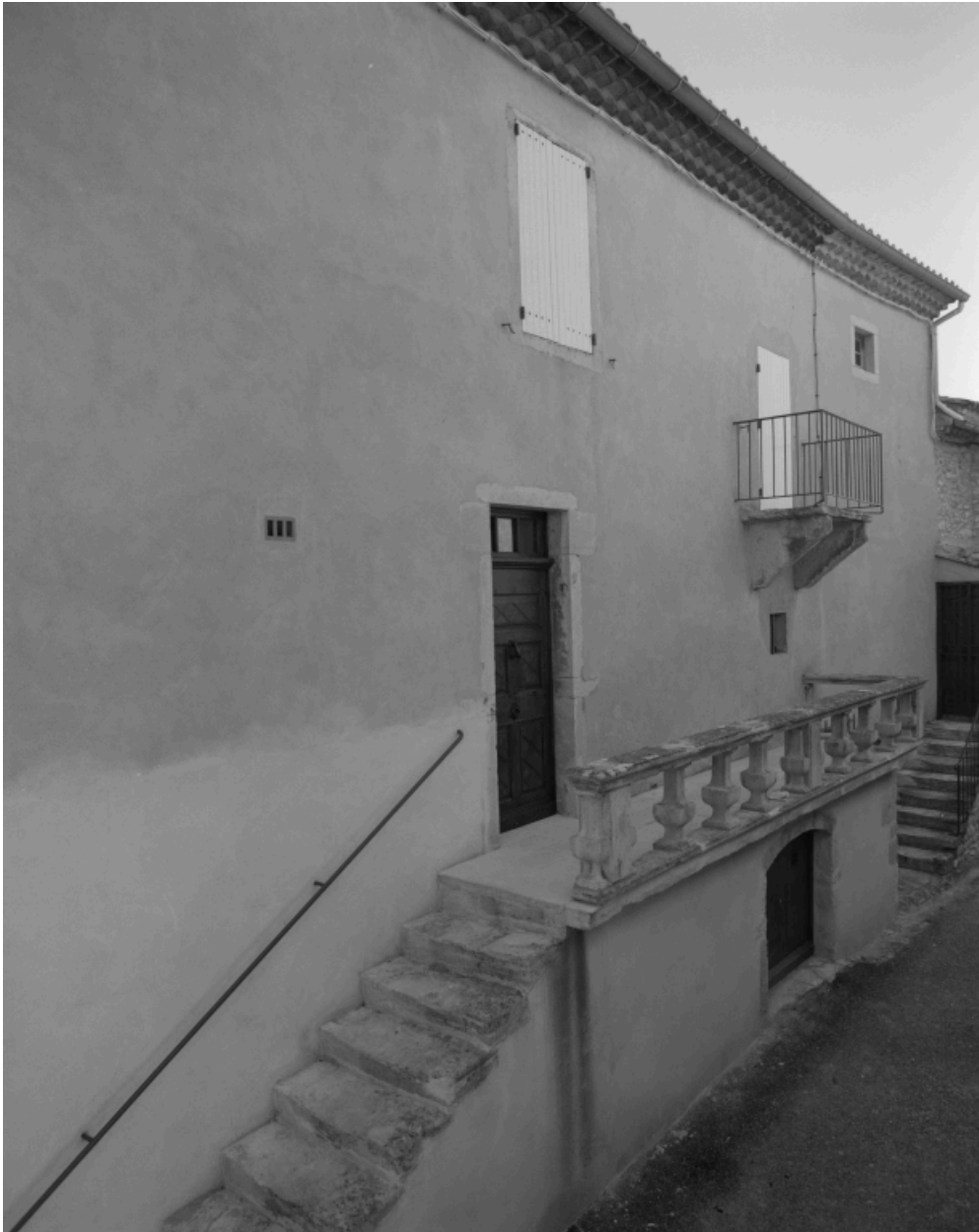
Rousset-les-Vignes, place du Prieuré. Maison (C1 62), élévation principale.
