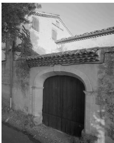
Rousset-les-Vignes, chemin de Champ raclé. Maison (C1 1096), le mur de clôture de la cour, fermée par un porche. Phot. Alain Franchella IVR82_19982600447X
