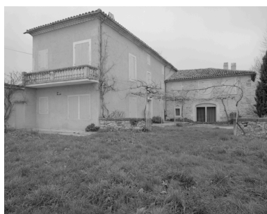
Rousset-les-Vignes, les Julianes. Maison (D 603), vue d'ensemble du côté du jardin. Phot. Alain Franchella IVR82_19982601092X
