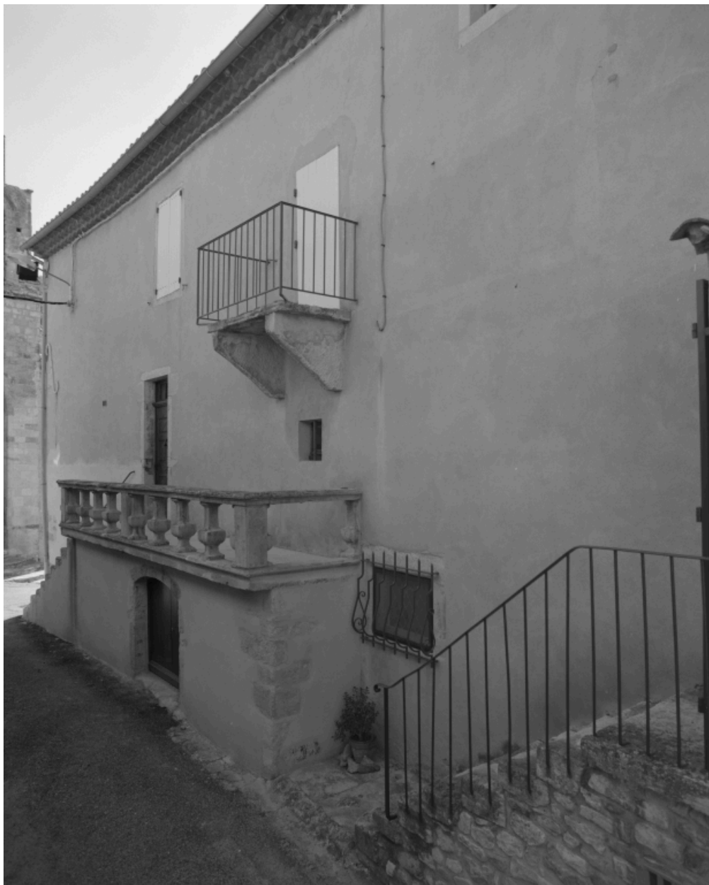
Rousset-les-Vignes, place du Prieuré. Maison (C1 62), élévation principale.
