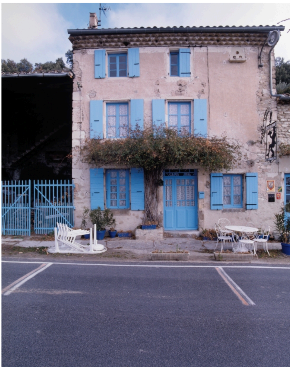
Rousset-les-Vignes, Charbonelon. Maison, façade sur la route.
