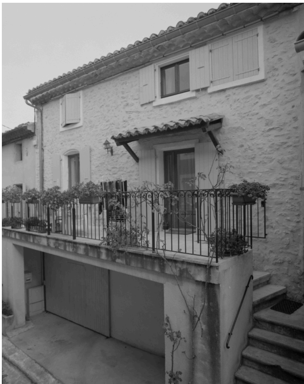
Le Pègue, Grand'rue. Maison (B3 649), élévation sur la Grand'rue.
