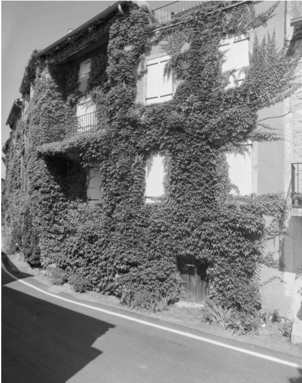
Rousset-les-Vignes, rue des Dauphins (RD 538). Maison (C1 121), façade.
