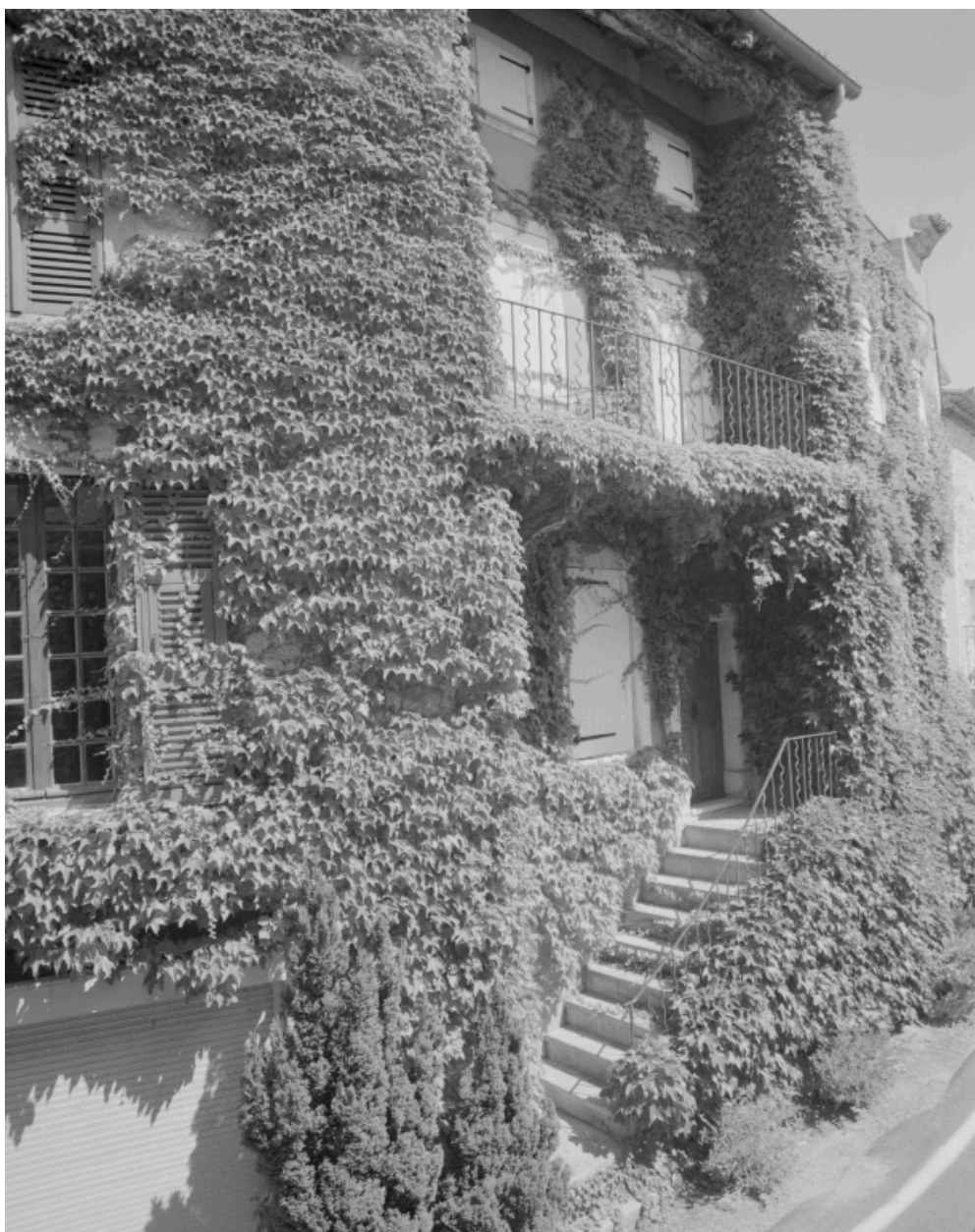
Rousset-les-Vignes, rue des Dauphins (RD 538). Maison (C1 121), façade, vue partielle
