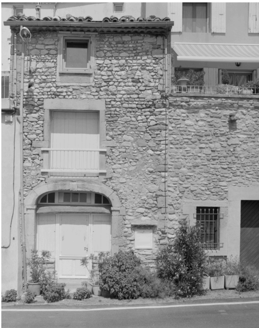
Rousset-les-Vignes, rue des Dauphins (RD 538). Maison (C1 124), façade.
