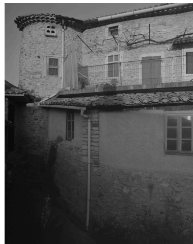
Le Pègue, montée de la Viale. Maison (B3 631), vue partielle de la maison attenante à la porte nord-ouest du castrum. Phot. Alain Franchella IVR82_19982600957X
