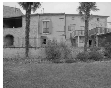
Rousset-les-Vignes, la Beaume. Maison et ferme (C3 756), vue partielle des bâtiments. Phot. Alain Franchella IVR82_19982601086X
