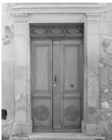
Rousset-les-Vignes, rue des Dauphins (RD 538). Maison (C1 133), détail de la porte. Phot. Alain Franchella IVR82_19982600496X
