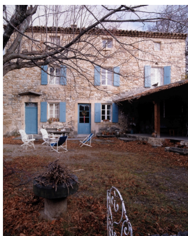
Rousset-les-Vignes, Champsauvel. Maison (C2 270), façade sur jardin, vue partielle. Phot. Alain Franchella IVR82_19982600993XA
