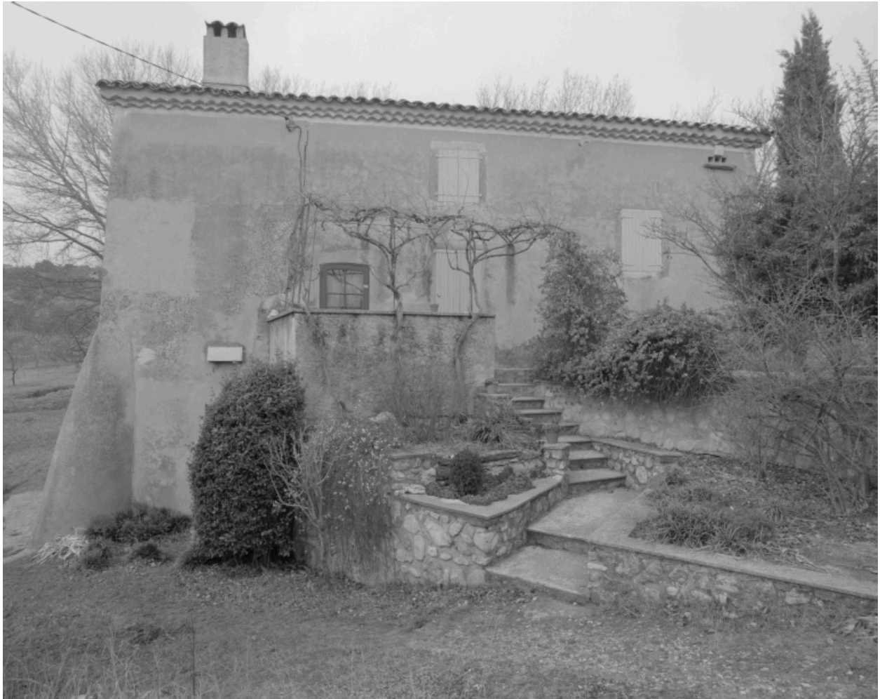
Rousset-les-Vignes, la Belle Vésine. Ferme (?), élévation principale.
