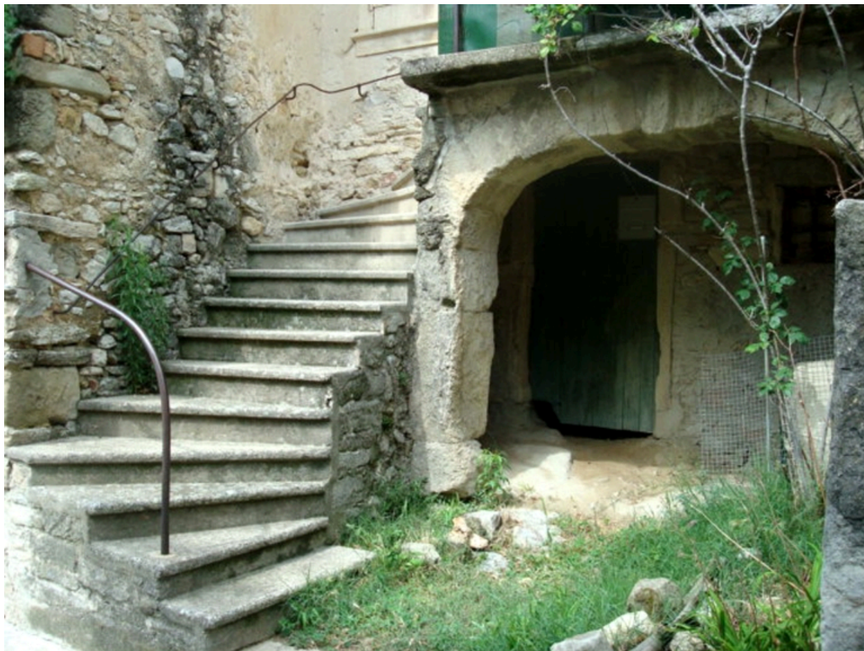
Le Pègue, Grand'rue. Maison (B3 660), détail de l'élévation, 1er niveau et escalier.
