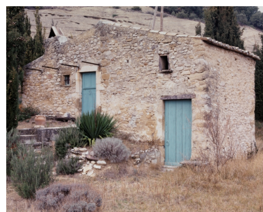
Rousset-les-Vignes, la Garenne (C3 917). Maison (ancien bâtiment agricole), vue d'ensemble. Phot. Alain Franchella IVR82_19982601091XA
