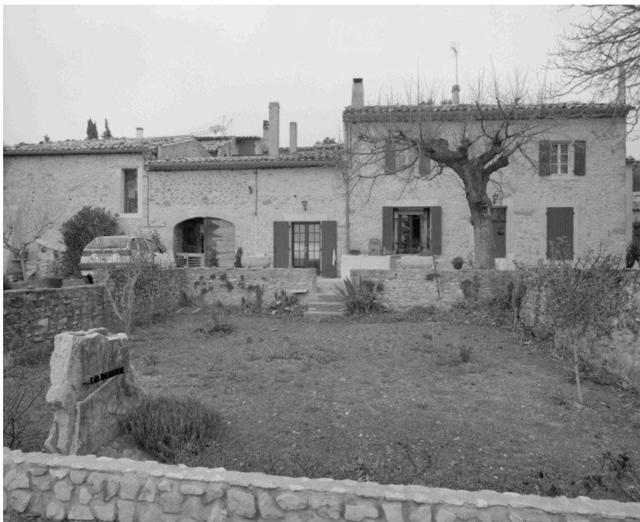
Rousset-les-Vignes, la Beaume. Maison et ferme (C3 999), vue d'ensemble.
