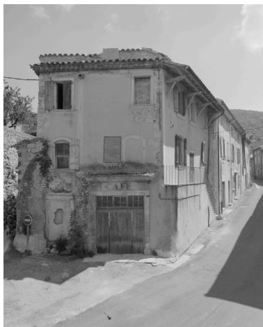
Rousset-les-Vignes, rue des Dauphins (RD 538) - rue du Valat. Maison (C1 108), élévation sur l'angle avec un ancien café.
