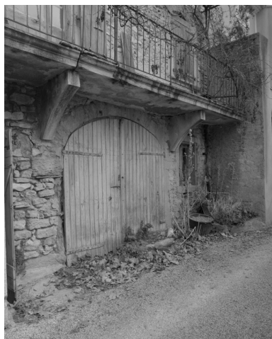
Le Pègue, Grand'rue. Maison (B3 685), portail de l'étage de soubassement sur la rue Basse. Phot. Alain Franchella IVR82_19982600928X
