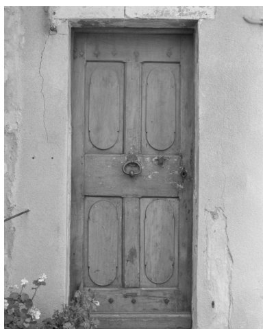
Rousset-les-Vignes, rue des Dauphins (ou RD 538). Maison (C1 112), détail de la porte. Phot. Alain Franchella IVR82_19982600457X
