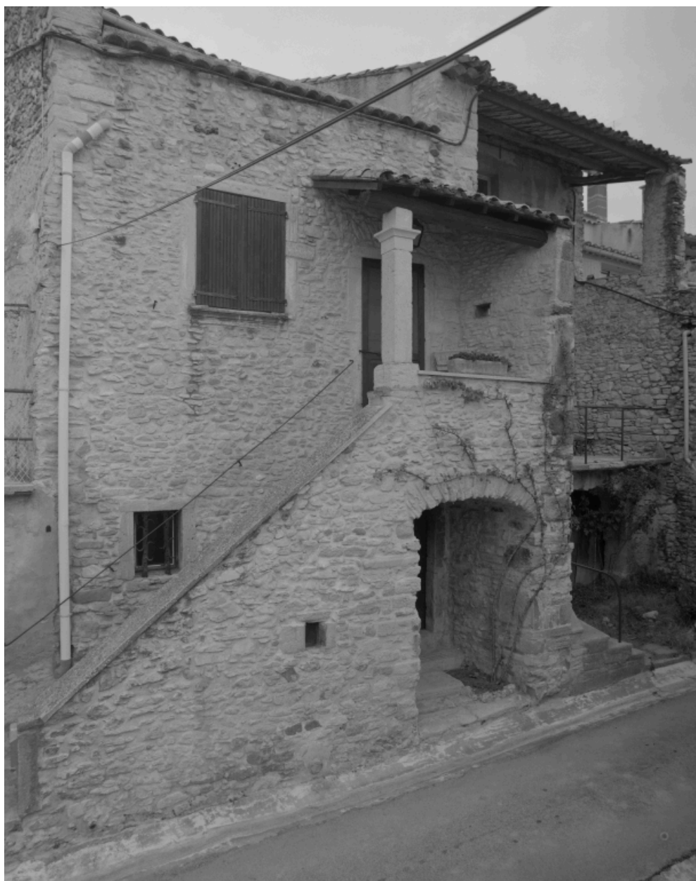
Le Pègue, Grand'rue. Maison (B3 659), vue d'ensemble de l'élévation.
