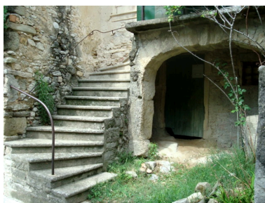
Le Pègue, Grand'ru. Maison (B3 660), détail de l'élévation, 1er niveau et escalier. Phot. Geneviève Jourdan IVR82_20112600069NUCA
