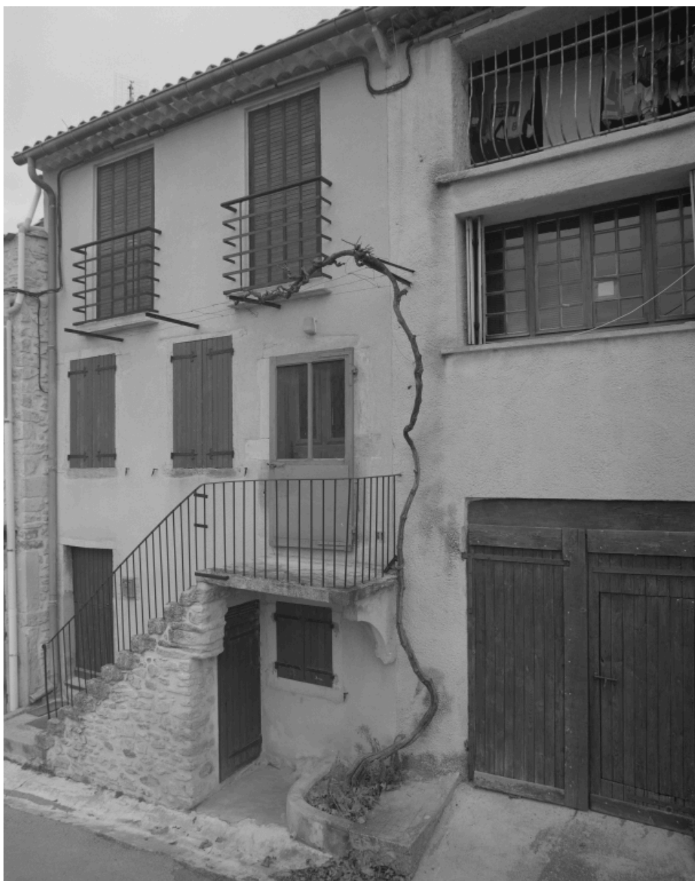
Le Pègue, Grand'rue. Maison (B3 672), façade.
