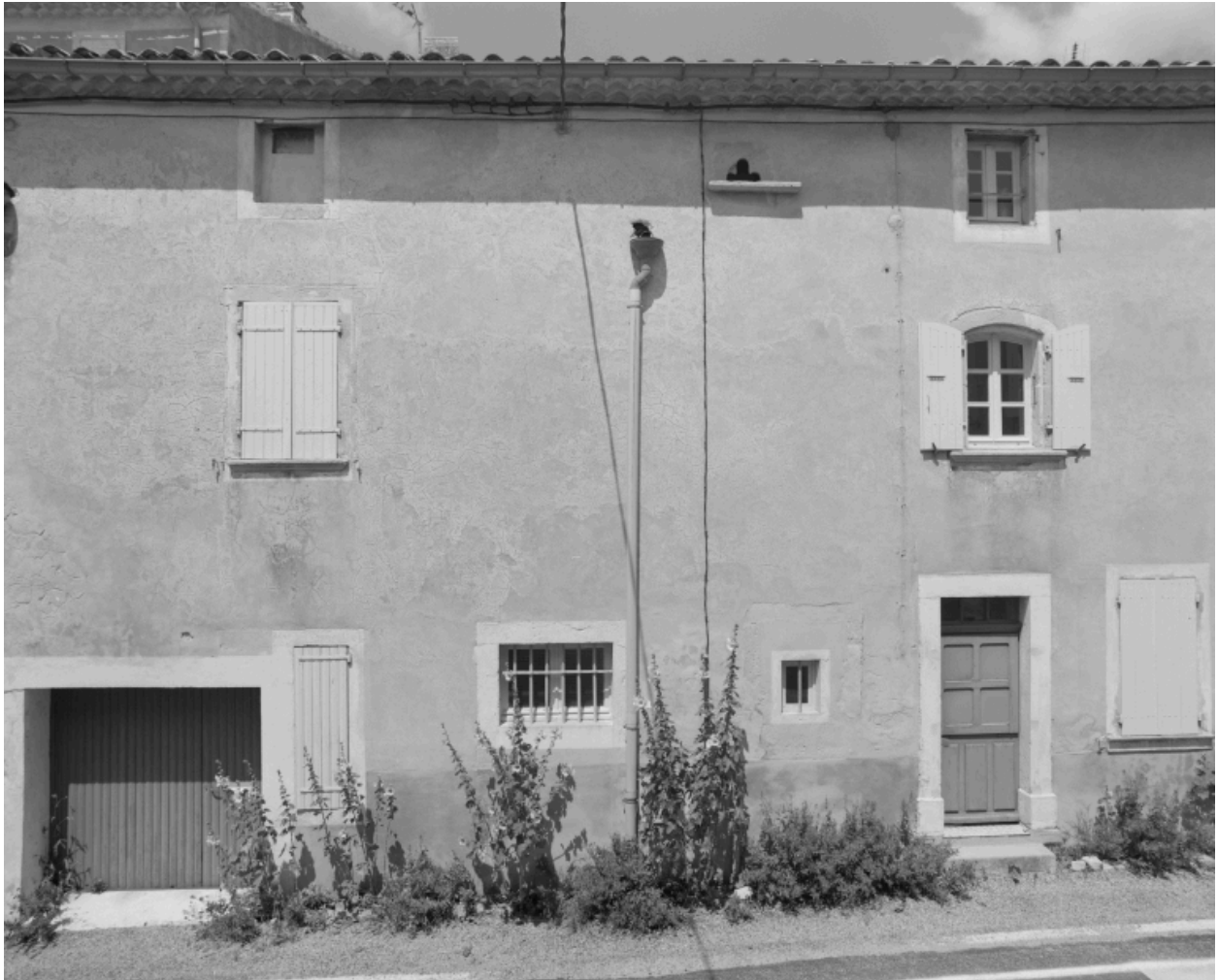
Rousset-les-Vignes, rue des Dauphins (RD 538). Maison (C1 27), façade.
