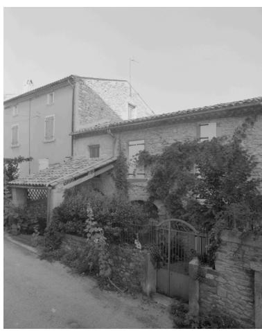
Rousset-les-Vignes, rue du Valat. Elévation postérieure de la maison C1 121 (rue des Dauphins). Phot. Alain Franchella
