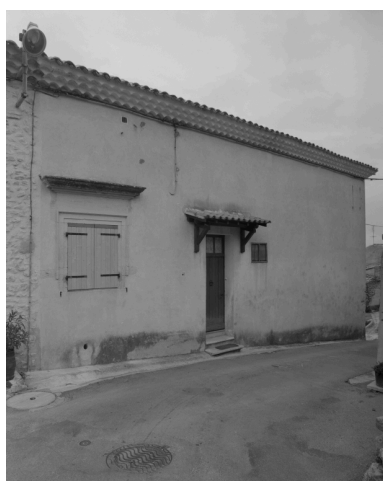
Le Pègue, Grand'ru. Maison (B3 677), élévation principale sur rue. Phot. Alain Franchella IVR82_19982600944X
