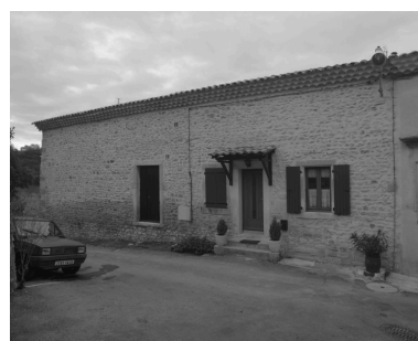
Le Pègue, Grand'ru. Maison (B3 676), élévation principale sur rue. Phot. Alain Franchella IVR82_19982600945X
