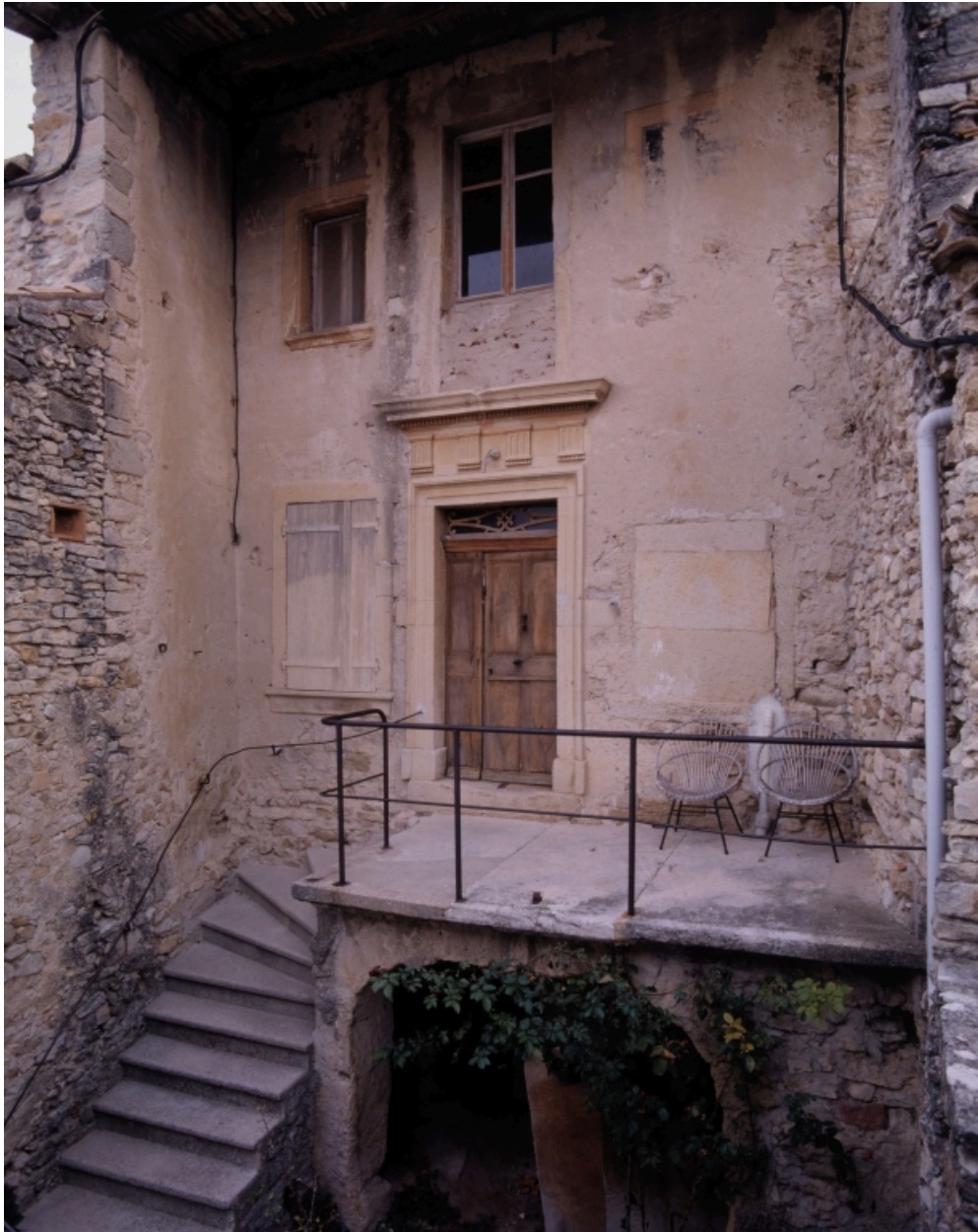
Le Pègue, Grand'rue. Maison (B 660). Vue de trois quarts de la façade.
