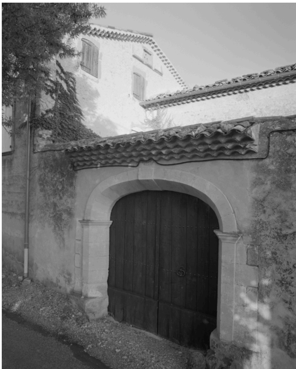
Rousset-les-Vignes, chemin de Champ raclé. Maison (C1 1096), le mur de clôture de la cour, fermée par un porche.
