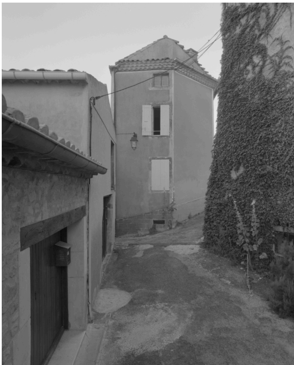
Rousset-les-Vignes, rue des Dauphins (RD 538). Maison (C1 139) élévation à pan coupé sur l'angle.
