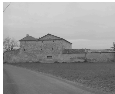
Le Pègue, Sainte-Anne. Elévation postérieure de la ferme (B1 179). Phot. Alain Franchella IVR82_19982600927X
