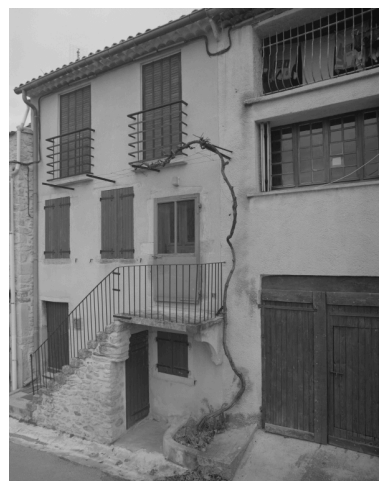
Le Pègue, Grand'ru. Maison (B3 659), élévation sur la rue haute. Phot. Alain Franchella IVR82_19982600946X
