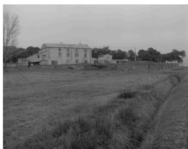
Rousset-les-Vignes, Plaine de Suzau. Ferme (D1 13), vue d'ensemble. Phot. Alain Franchella IVR82_19982600967X
