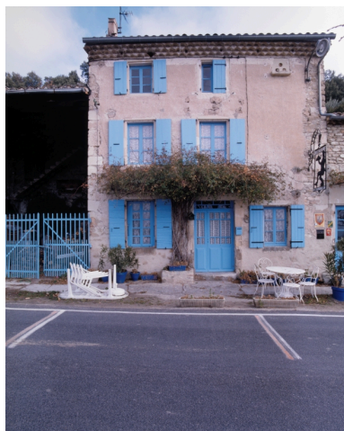
Rousset-les-Vignes, Charbonelon. Maison, façade sur la route.
