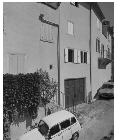
Rousset-les-Vignes, rue du Valat. Elévation partielle des maisons C1 62 et C1 1094. Phot. Alain Franchella IVR82_19982600485X
