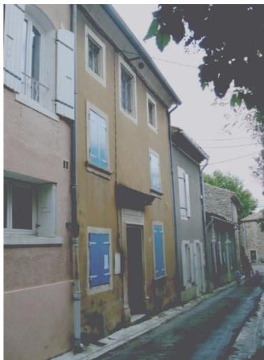
Le Pègue, Grand'rue. Maison (B3 685), façade sur la Grand'rue. Phot. Geneviève Jourdan IVR82_20112600063NUCA
