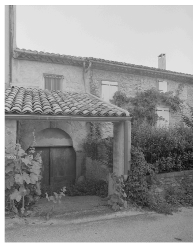
Rousset-les-Vignes, rue du Valat. Elévation postérieure de la maison C1 123 (rue des Dauphins). Phot. Alain Franchella
