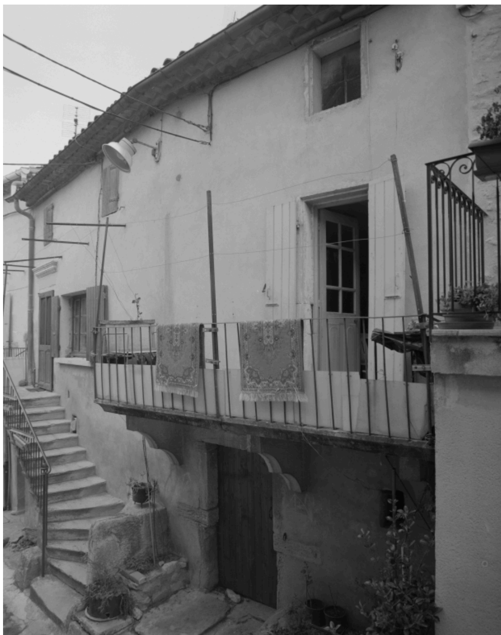
Le Pègue, Grand'rue. Maison (B3 648), élévation sur la Grand'rue.
