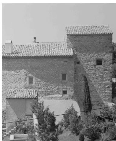
Rousset-les-Vignes, rue des Alics. Maison (C1 14), vue partielle de l'élévation est. Phot. Alain Franchella IVR82_19982600460X
