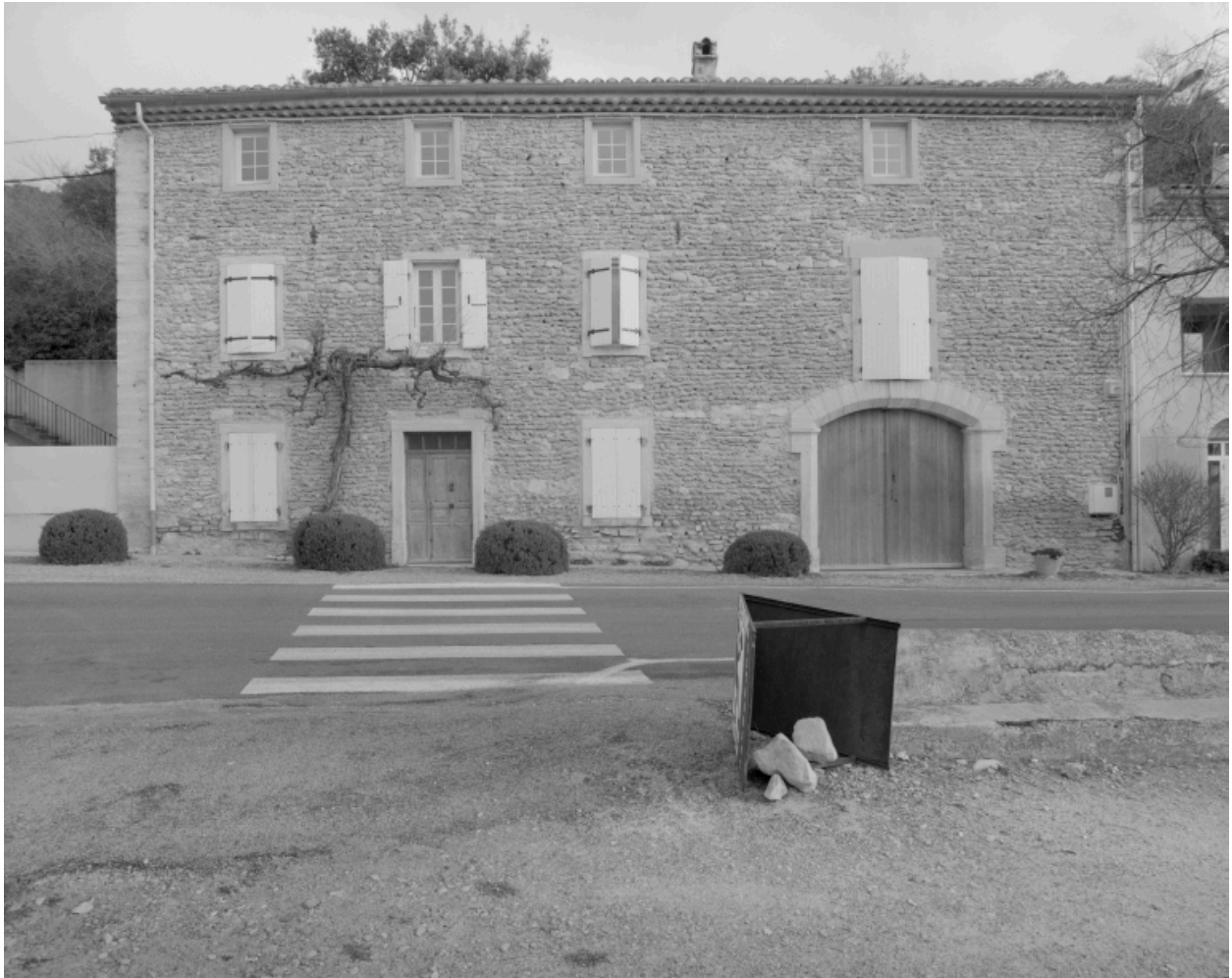
Rousset-les-Vignes, Charbonelon. Maison (B2 312), vue d'ensemble de la façade.
