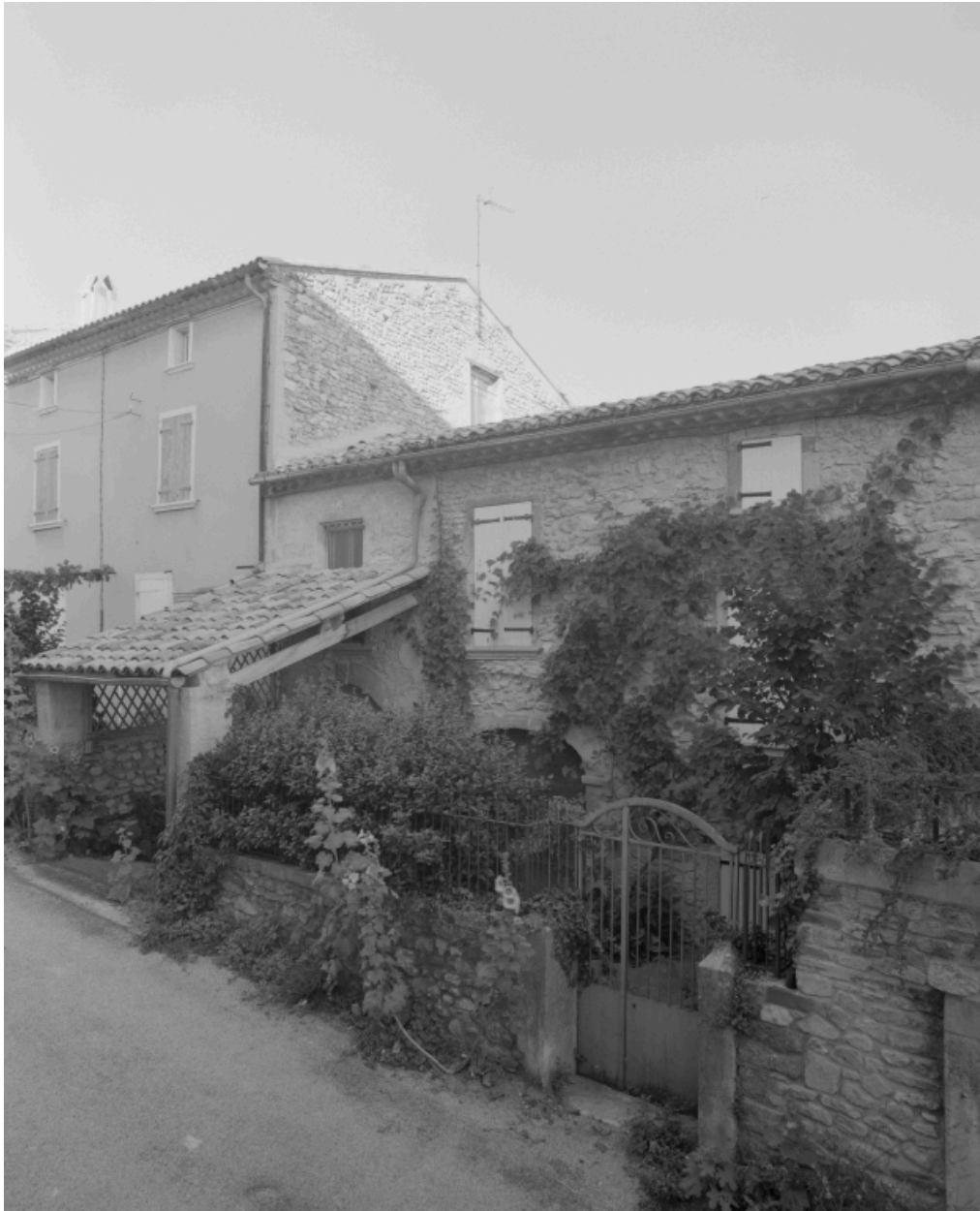
Rousset-les-Vignes, rue du Valat. Elévation postérieure de la maison C1 121 (rue des Dauphins).
