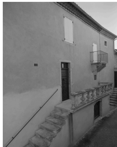
Rousset-les-Vignes, place du Prieuré. Maison (C1 62), élévation principale. Phot. Alain Franchella IVR82_19982600482X
