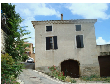
Le Pègue, Grand'ru. Maison (B3 677), élévation latérale dans la pente de la Grand'ru ; porte cochère datée 1831. Phot. Geneviève Jourdan IVR82_20112600070NUCA
