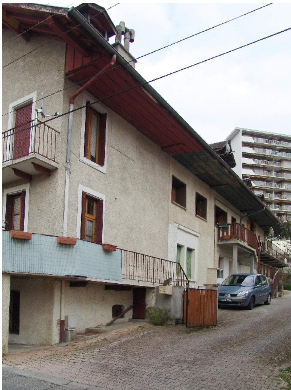
Façade antérieure vue depuis la rue
