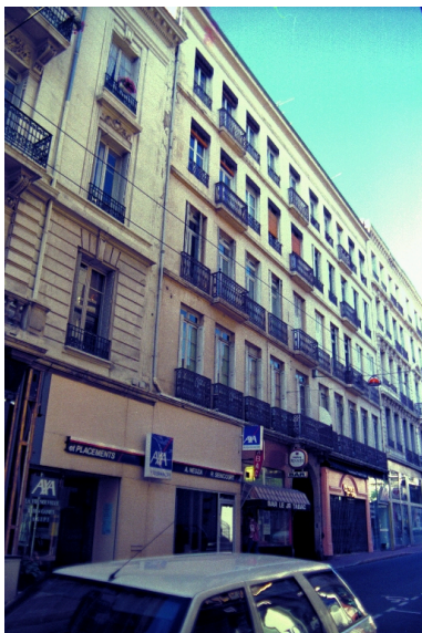
Façade principale Phot. Cendrine Sanquer IVR82_19974202083ZE
