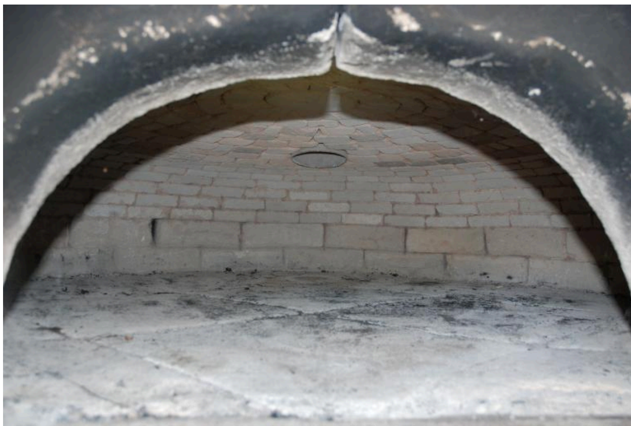
Vue intérieure de la voûte du four.
