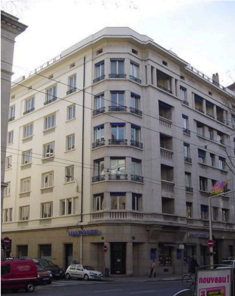
Vue générale de l'élévation
