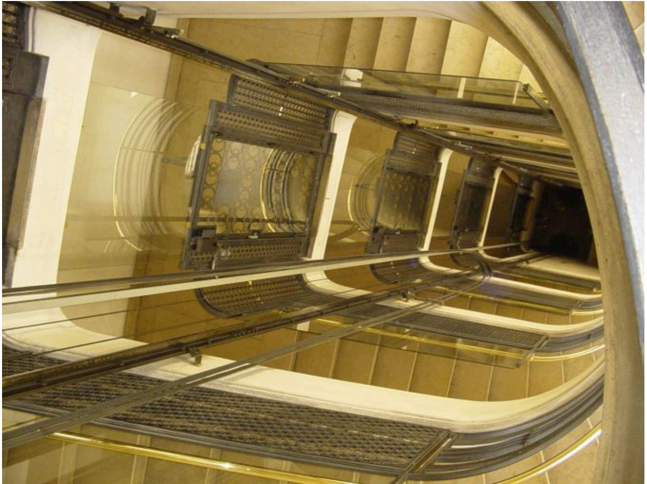
Cage d'escalier en surplomb
