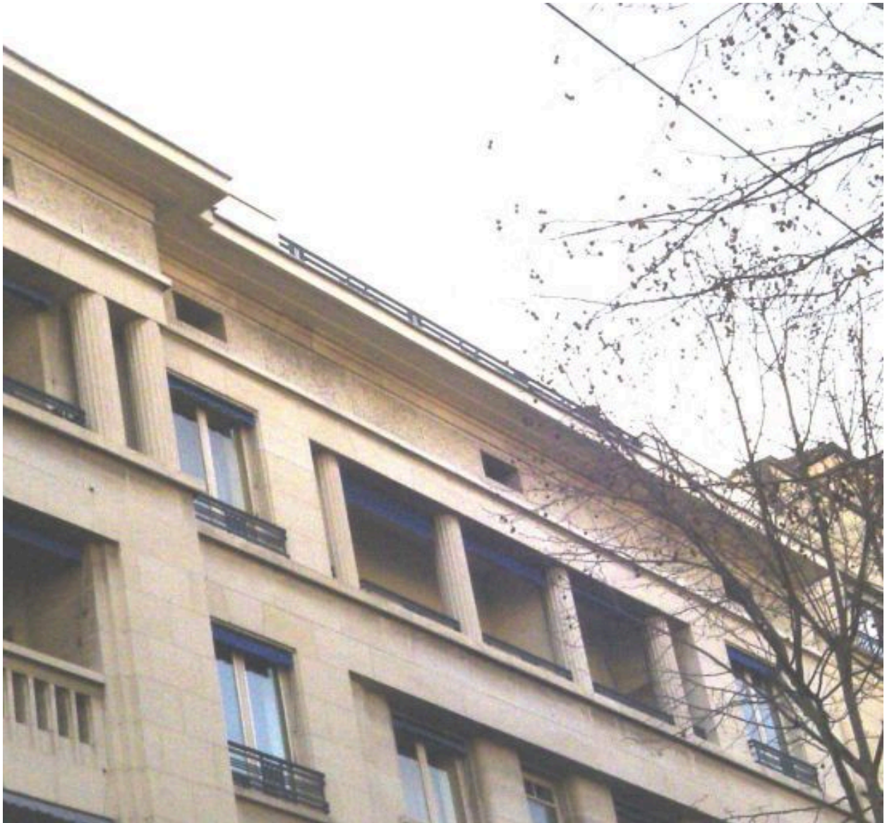
Vue de la loggia et du toit-terrasse
