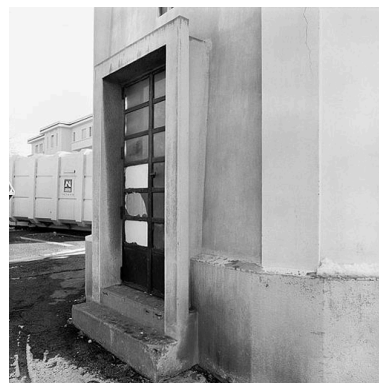
Le château d'eau : détail de la porte Phot. Didier Gourbin IVR82_20046902019X
