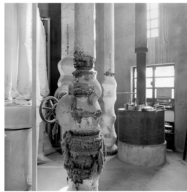
Le château d'eau : vue intérieure, détail des colonnes Phot. Didier Gourbin IVR82_20046902024X
