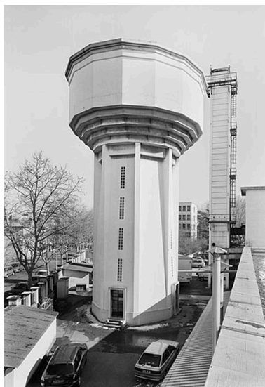
Le château d'eau : vue générale extérieure Phot. Didier Gourbin IVR82_20046902018P
