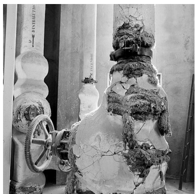
Le château d'eau : vue intérieure, détail des colonnes Phot. Didier Gourbin IVR82_20046902025X
