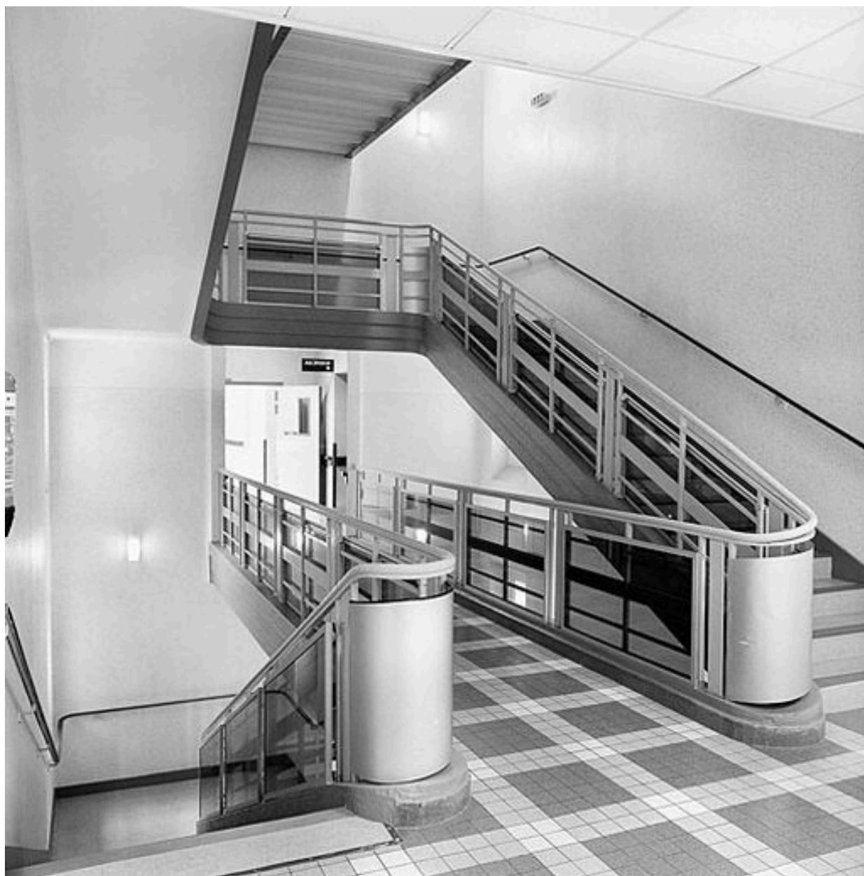
Bâtiment principal : l'escalier
