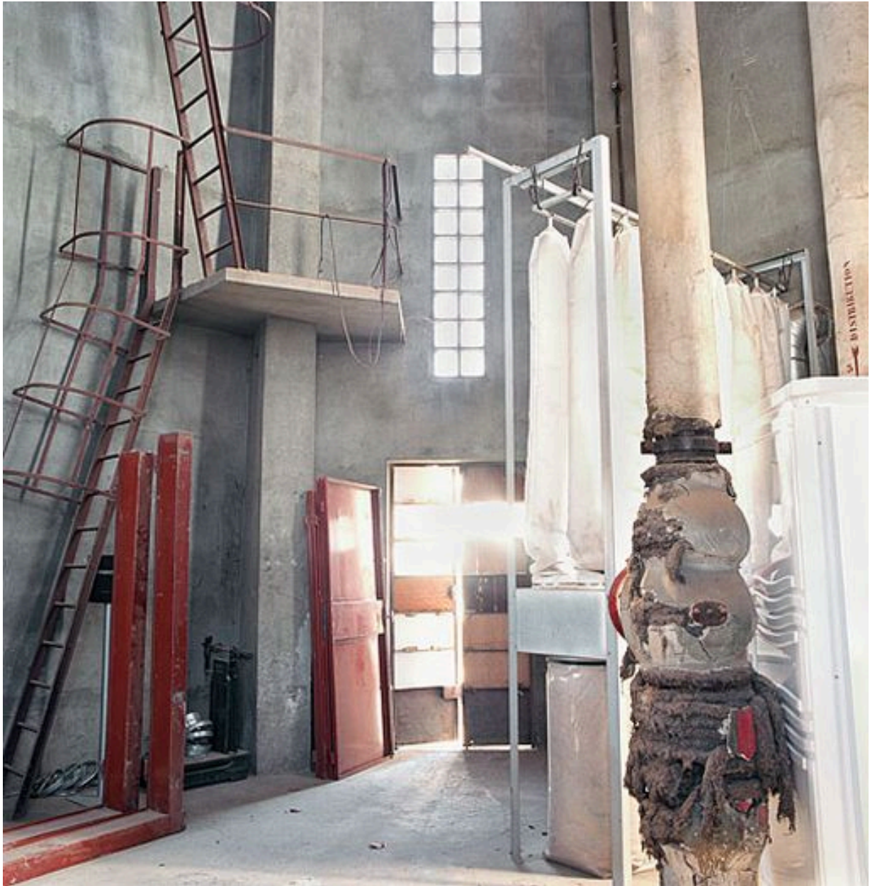
Le château d'eau : vue intérieure, partie inférieure
