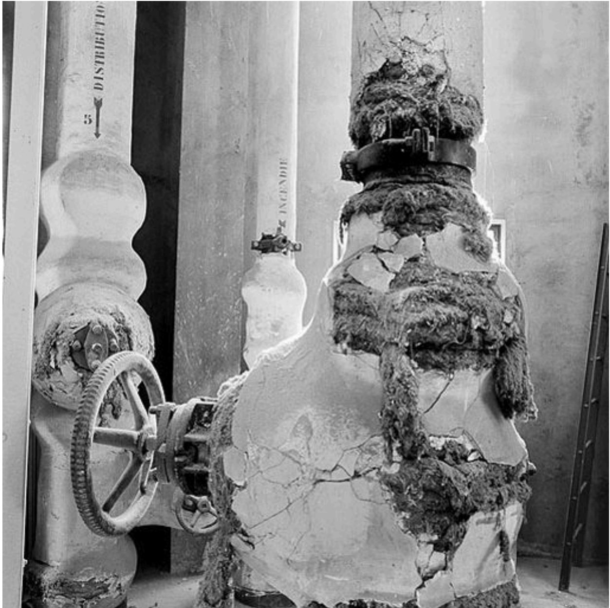
Le château d'eau : vue intérieure, détail des colonnes
