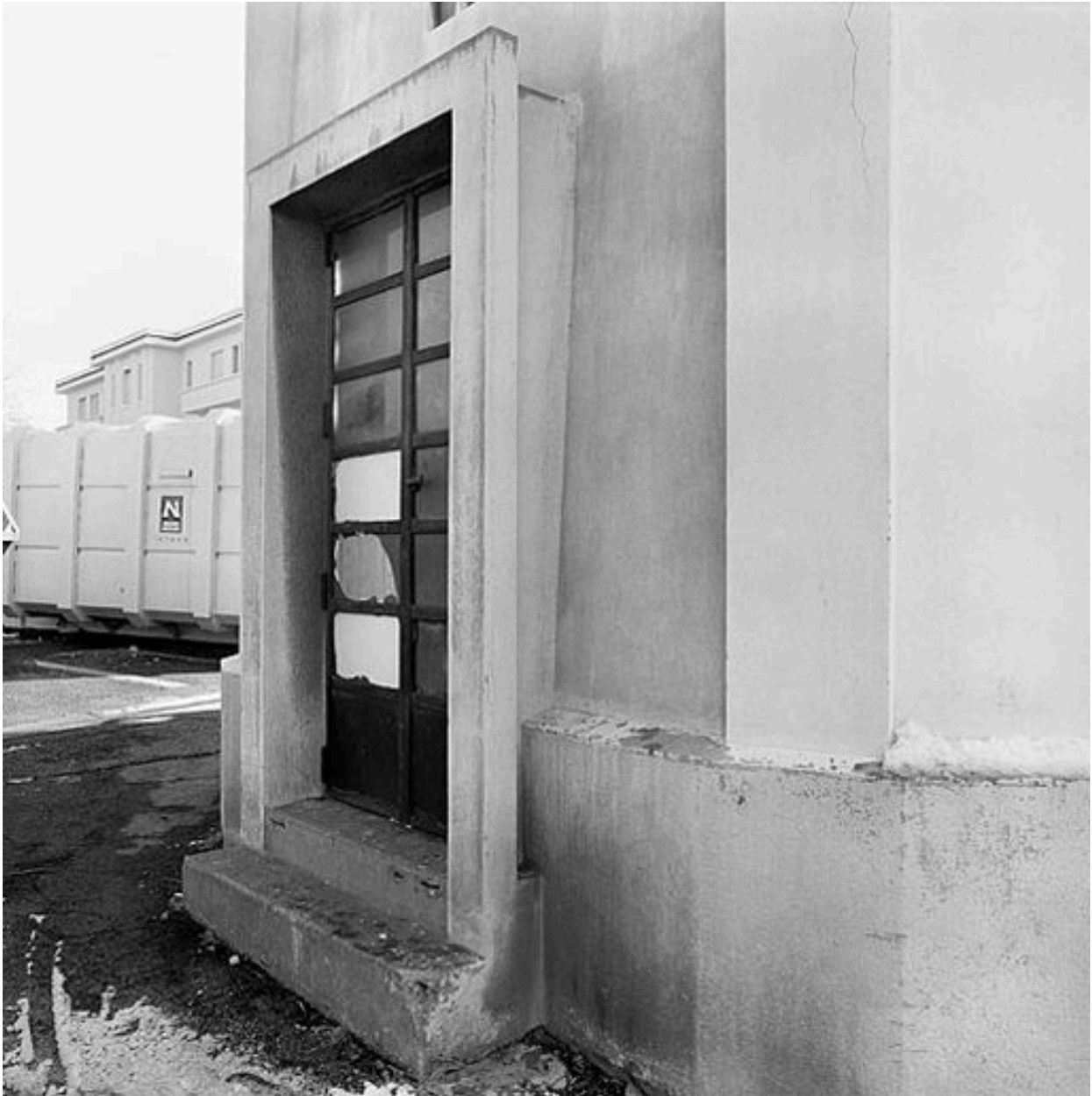
Le château d'eau : détail de la porte
