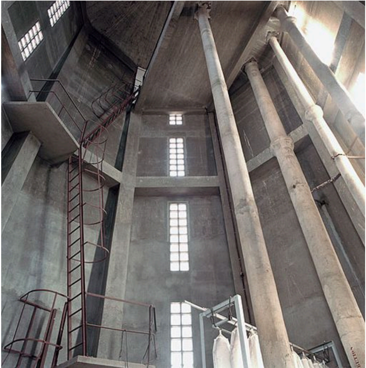
Le château d'eau : vue intérieure, partie supérieure
