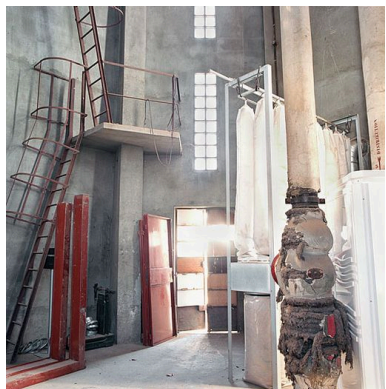
Le château d'eau : vue intérieure, partie inférieure Phot. Didier Gourbin IVR82_20046902020XE
