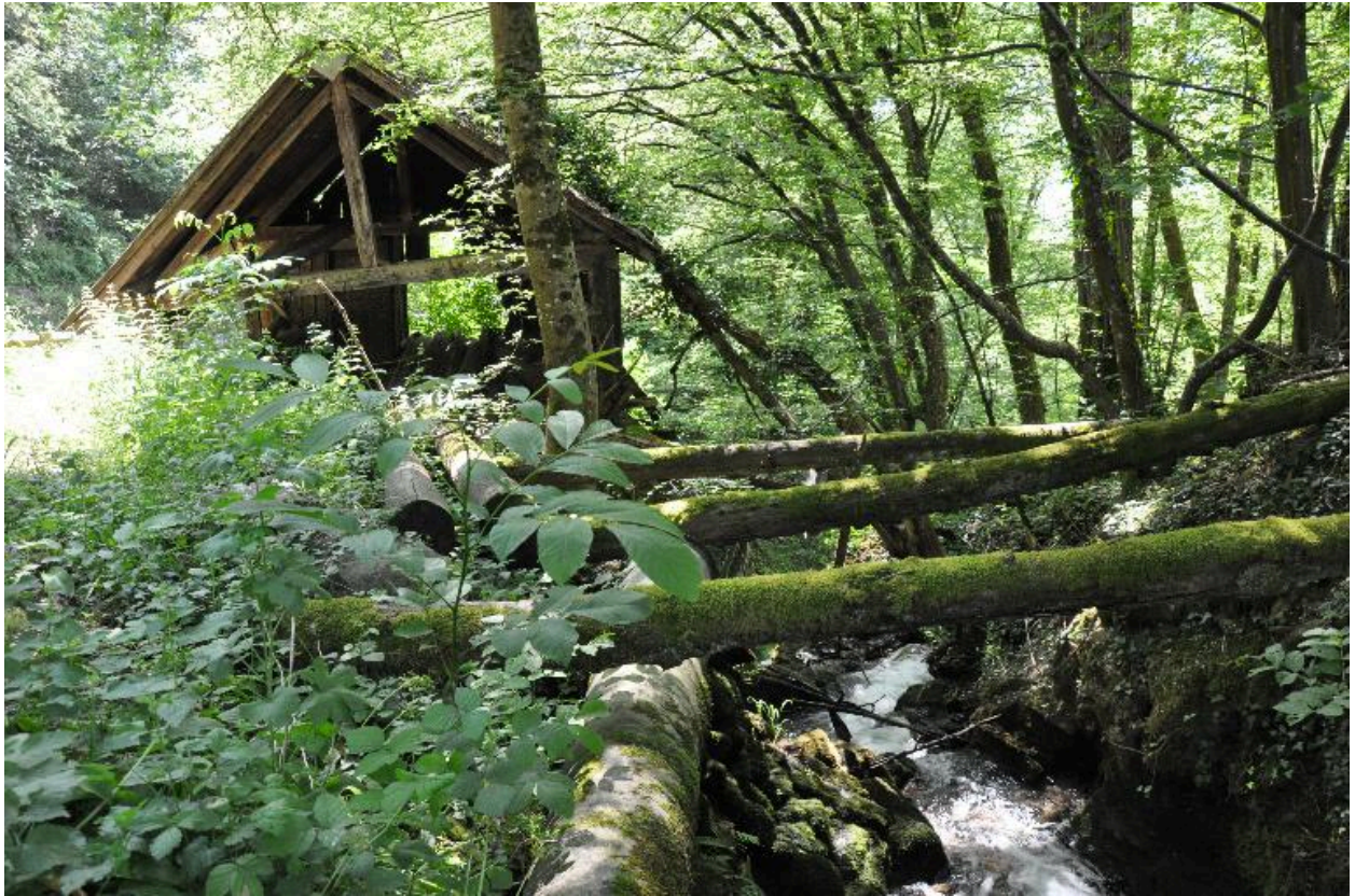
Vue de la scierie avec la conduite d'amenée au premier plan.
