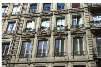
Façade, travées de gauche, 3e et 4e niveaux Phot. Bernard Ducouret IVR82_20046905808NUCA
