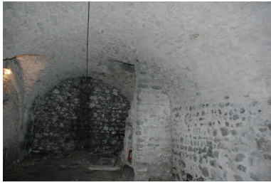
Cave en berceau plein-cintre avec vestige d'escalier montant directement dans la cuisine . Phot. Simone Hartmann-Nussbaum IVR82_20104200714NUCA
