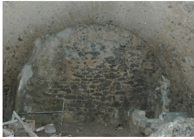
Cave en berceau en plein-cintre. Phot. Simone Hartmann-Nussbaum IVR82_20104200715NUCA
