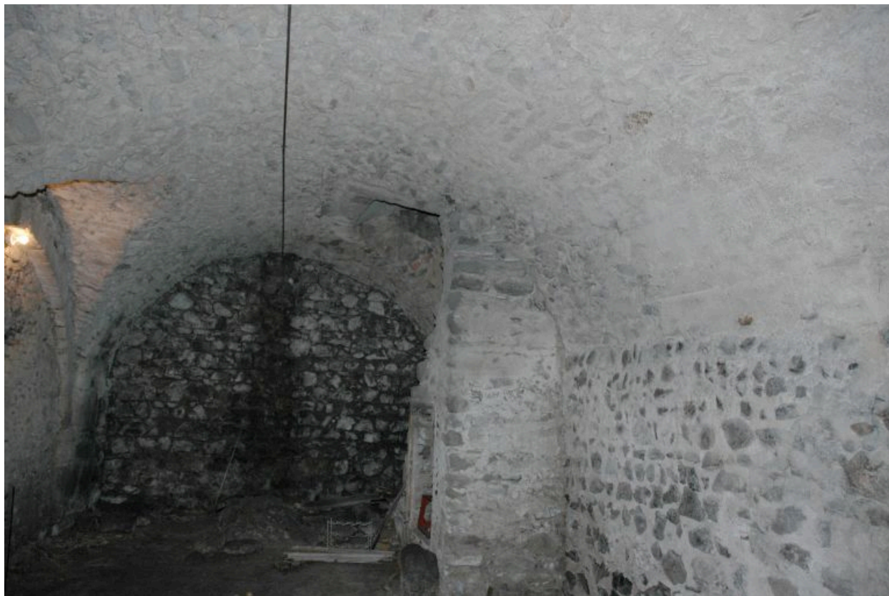
Cave en berceau plein-cintre avec vestige d'escalier montant directement dans la cuisine .
