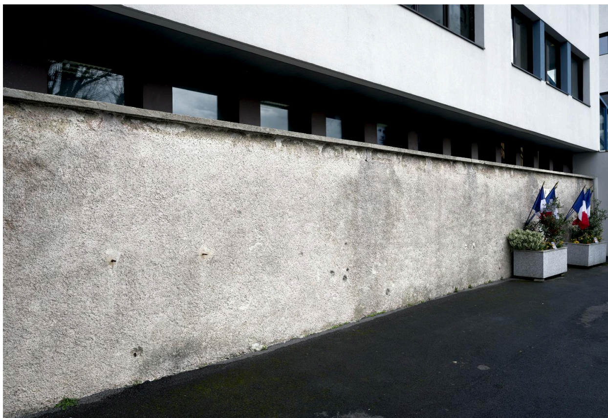
Mur dit "des fusillés", vue générale
