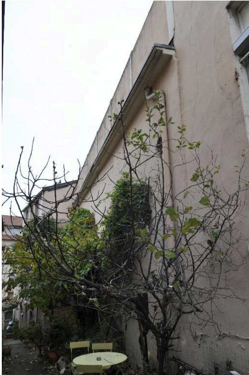
Vue de la façade postérieure, sur l'impasse Beauregard
