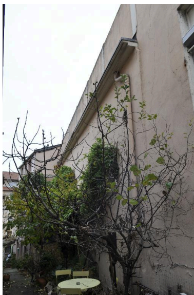
Vue de la façade postérieure, sur l'impasse Beauregard Phot. Magali Delavenne IVR82_20156902714NUCA
