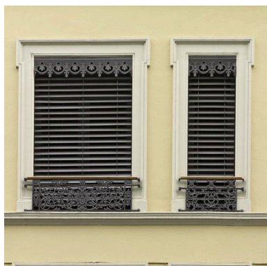
Elévation quai Saint-Antoine : détail de baies Phot. Eric Dessert IVR82_20076902477NUCA
