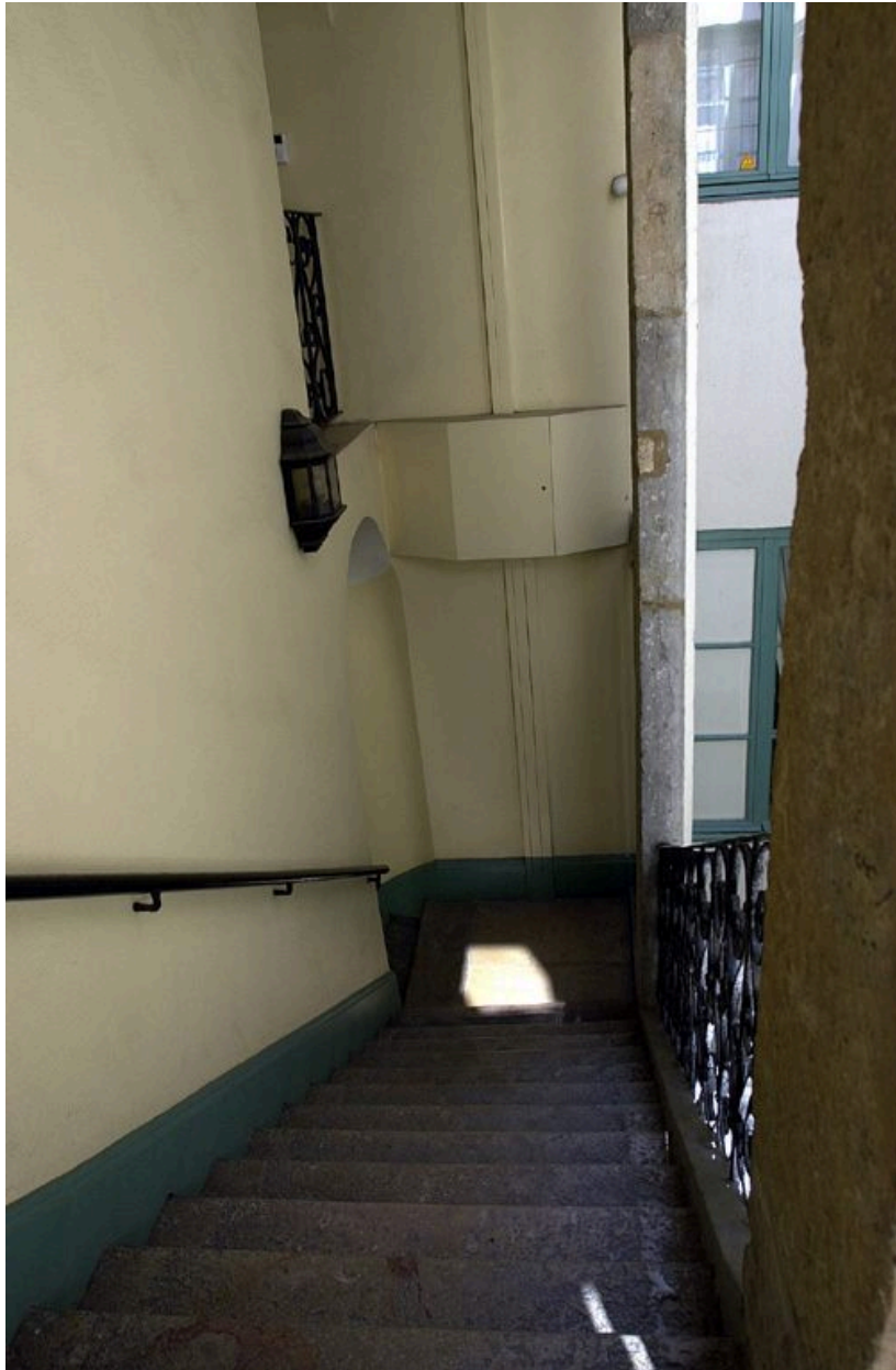
L'escalier : à gauche, le mur-noyau
