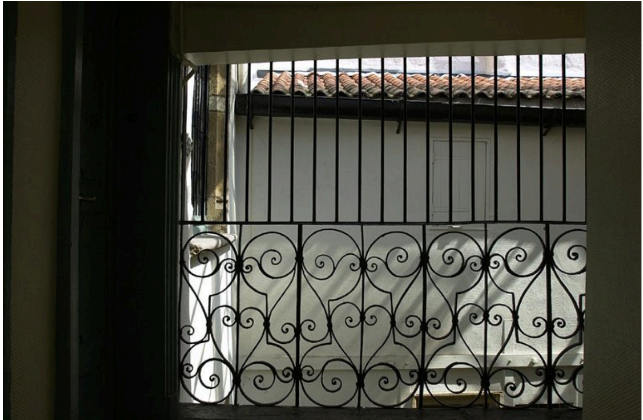
L'escalier : détail de garde-corps
