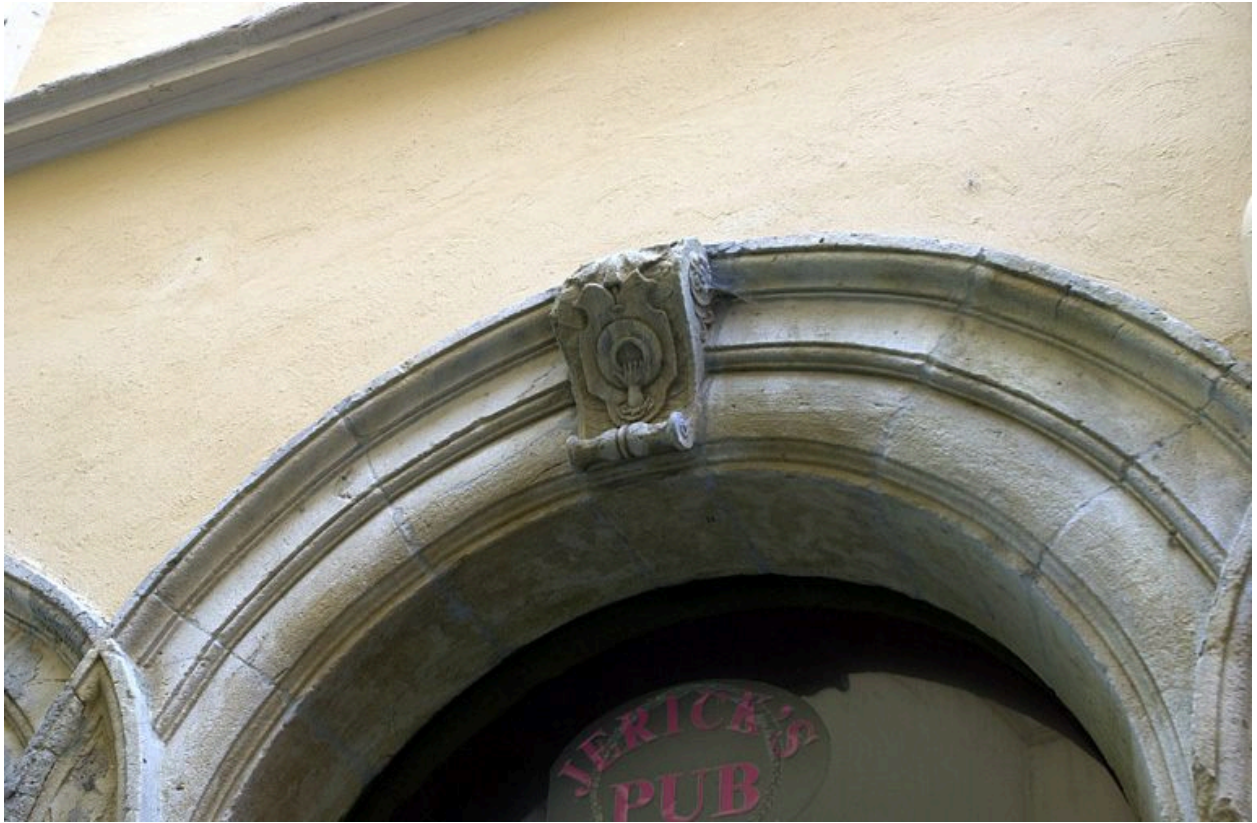
Elévation rue de la Monnaie, rez-de-chaussée : agrafe de l'arcade centrale
