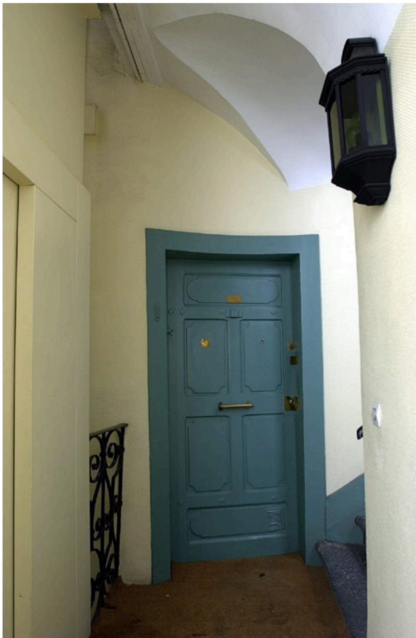
L'escalier : palier des étages inférieurs
