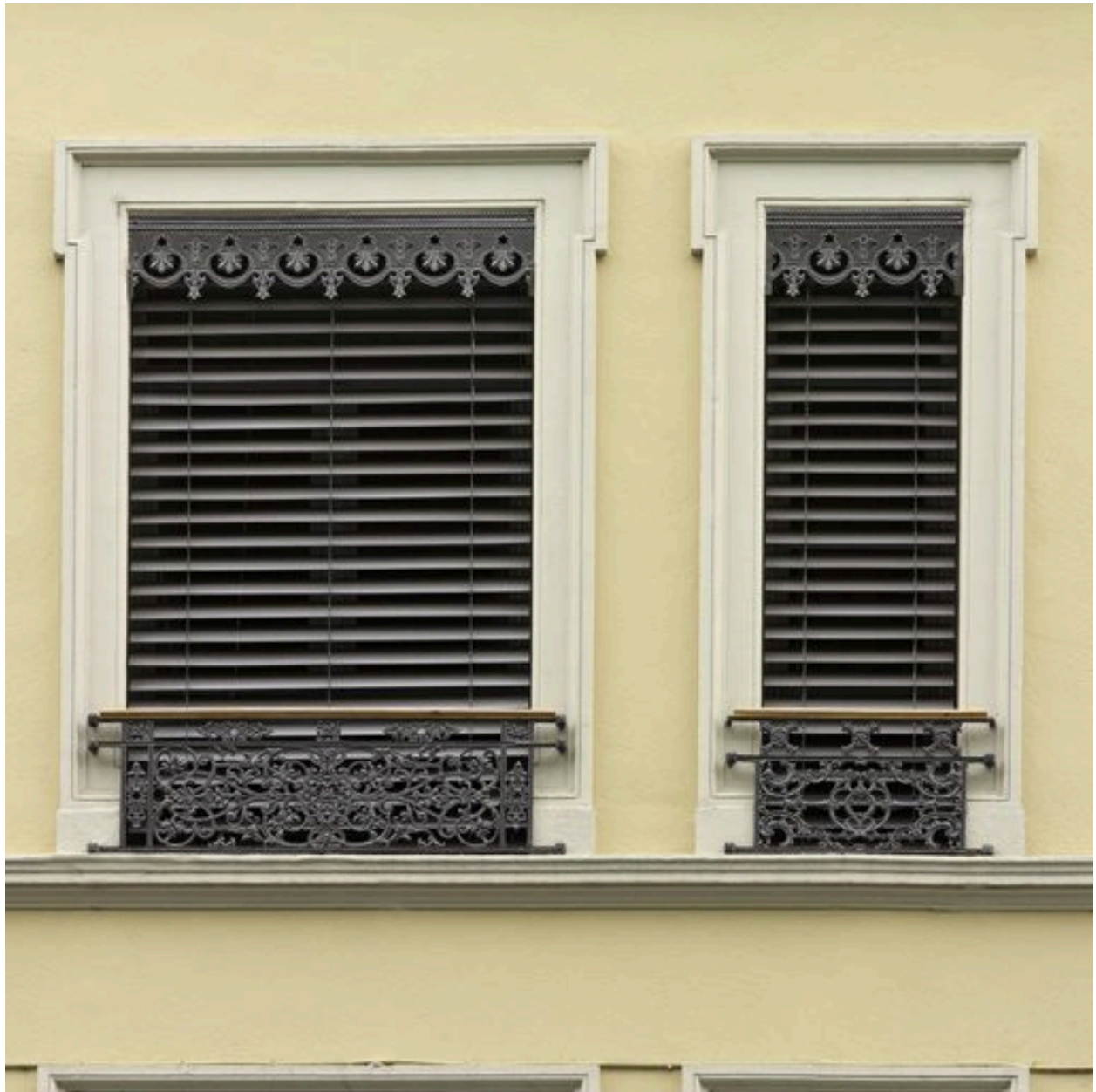
Elévation quai Saint-Antoine : détail de baies
