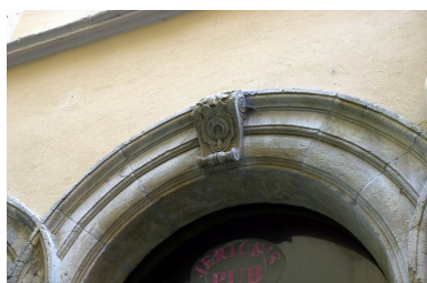
Elévation rue de la Monnaie, rez-de-chaussée : agrafe de l'arcade centrale Phot. Véronique Belle IVR82_20076901141NUCA
