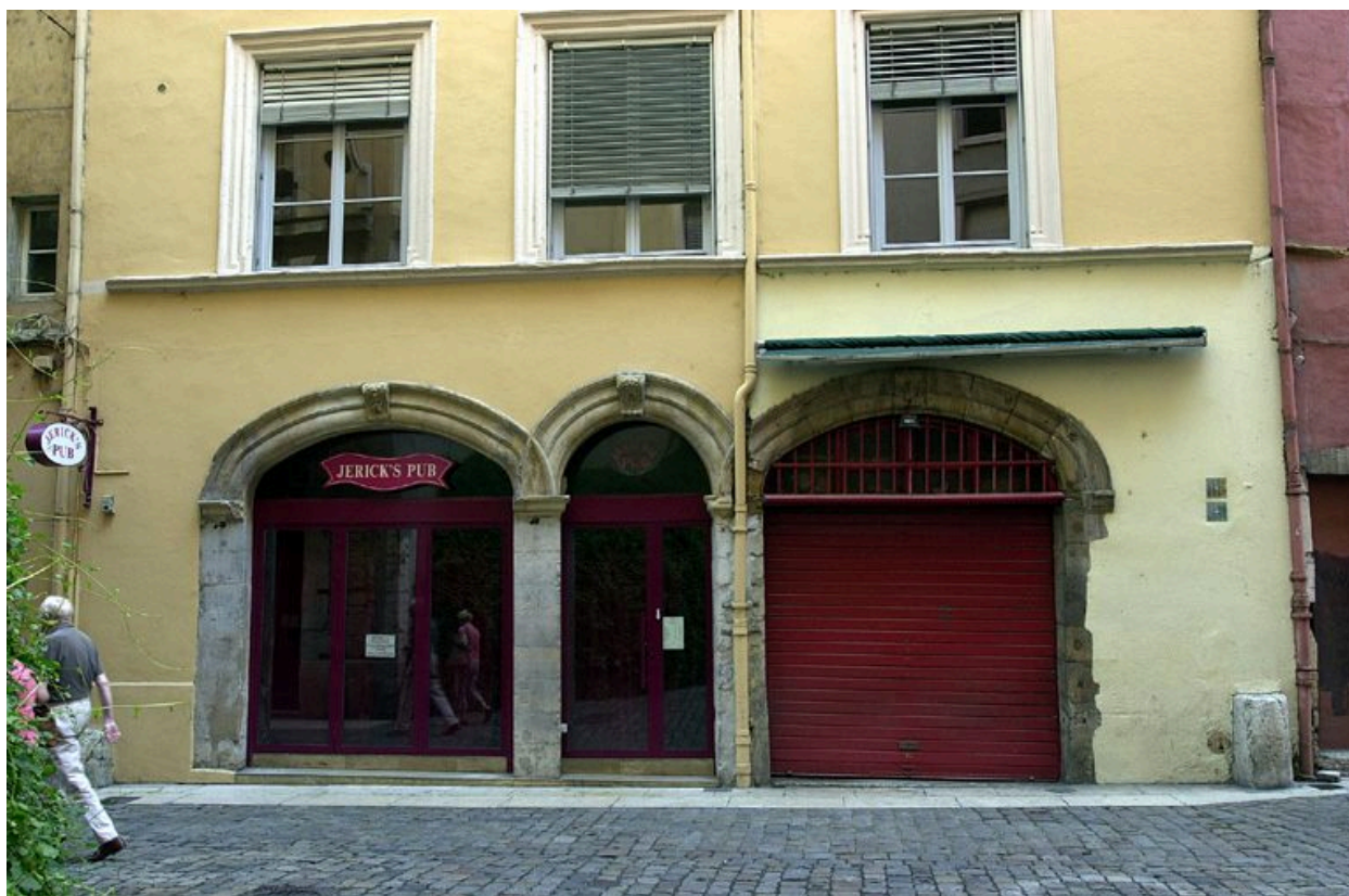
Elévation rue de la Monnaie : le rez-de-chaussée
