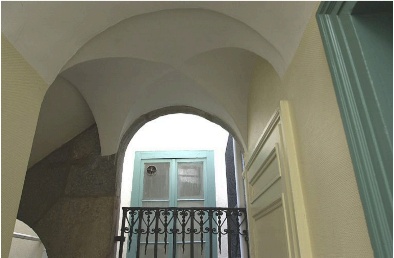
L'escalier : voûte d'arêtes
