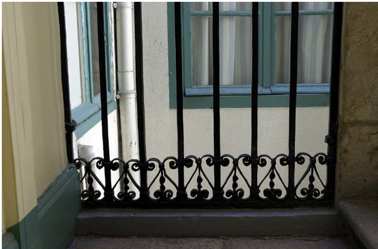
L'escalier : détail de garde-corps
