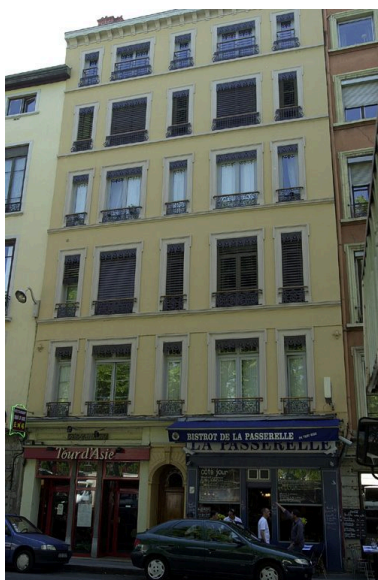
Elévation quai Saint-Antoine Phot. Véronique Belle IVR82_20076901155NUCA
