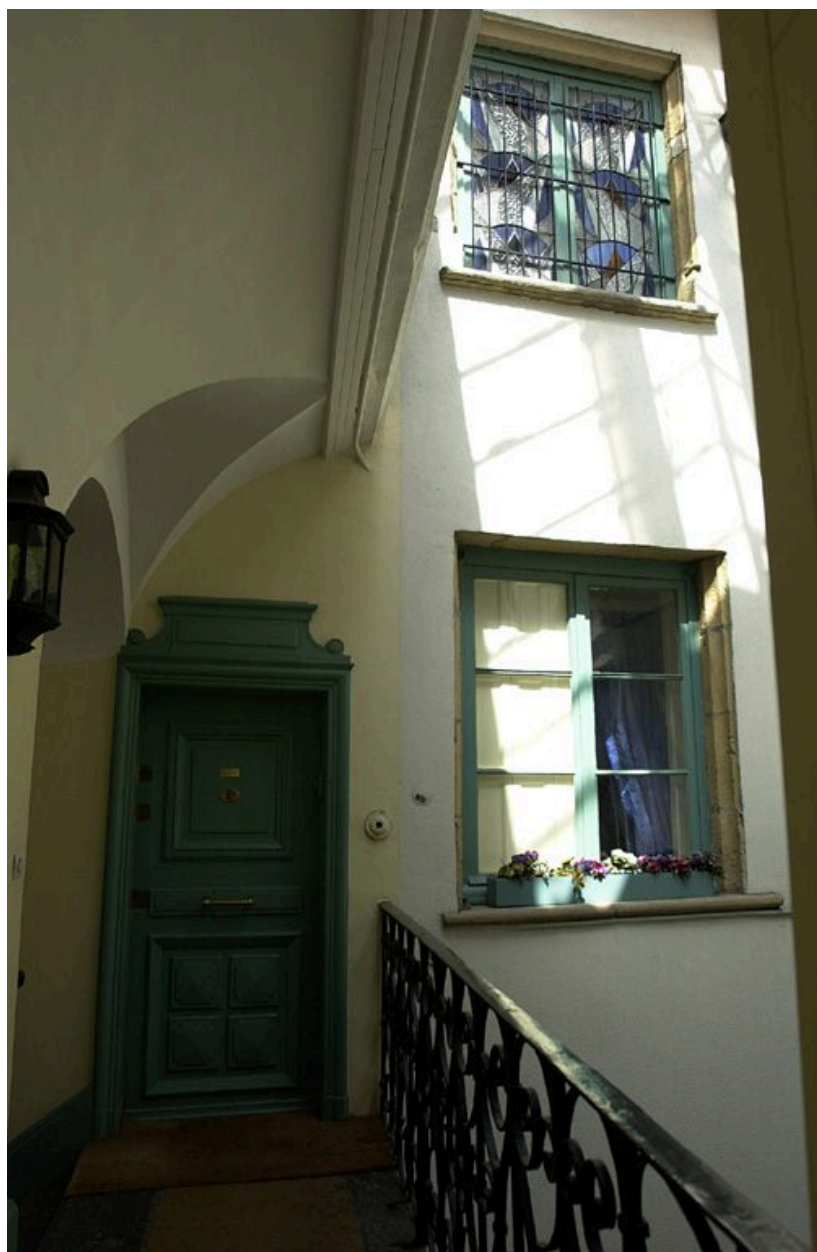
L'escalier : palier des étages supérieurs et fenêtre sur cour ornée d'un vitrail
