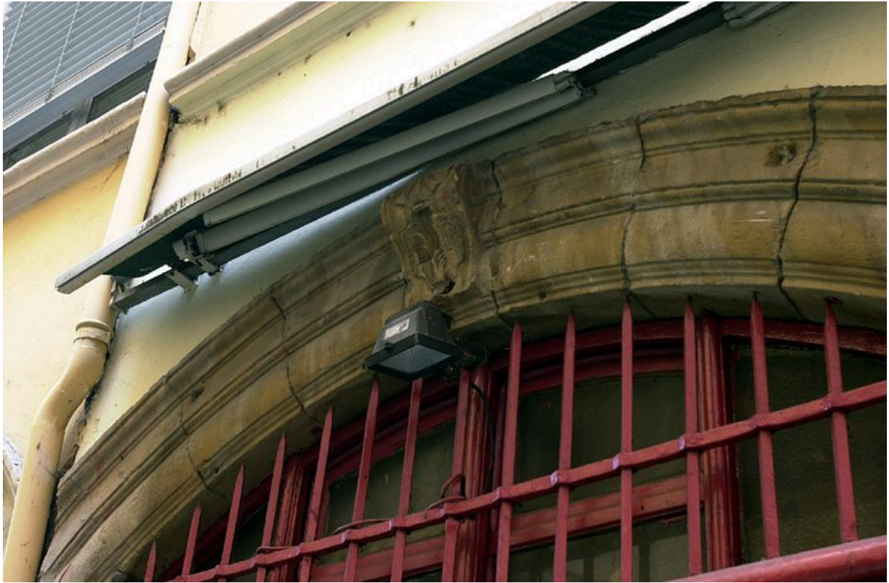
Elévation rue de la Monnaie, rez-de-chaussée : agrafe de l'arcade de droite
