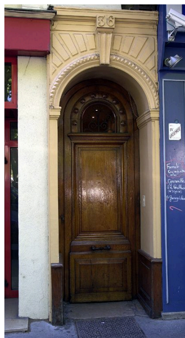
Elévation sur le quai : la porte Phot. Véronique Belle IVR82_20076901156NUCA
