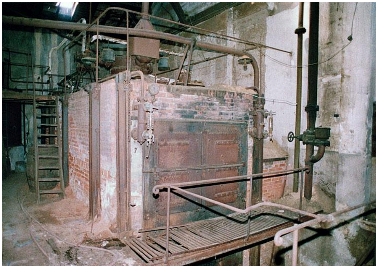
Chaudière de la machine à vapeur
