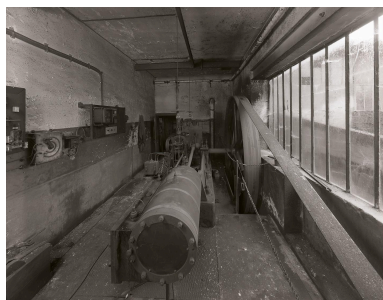
Vue d'ensemble de la machine à vapeur Phot. Eric Dessert IVR82_20046906353V
