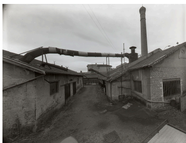
Vue d'ensemble du site Phot. Eric Dessert IVR82_20046906354V
