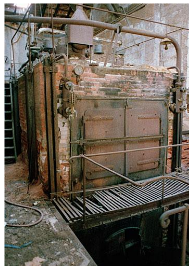
détail chaudière partie haute Phot. Nadine Halitim-Dubois IVR82_20046902787ZE
