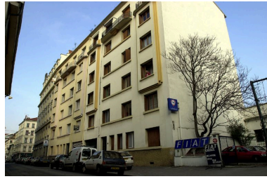
Vue d'ensemble depuis l'est Phot. Laurent Lascoux IVR82_20026904667NUCA
