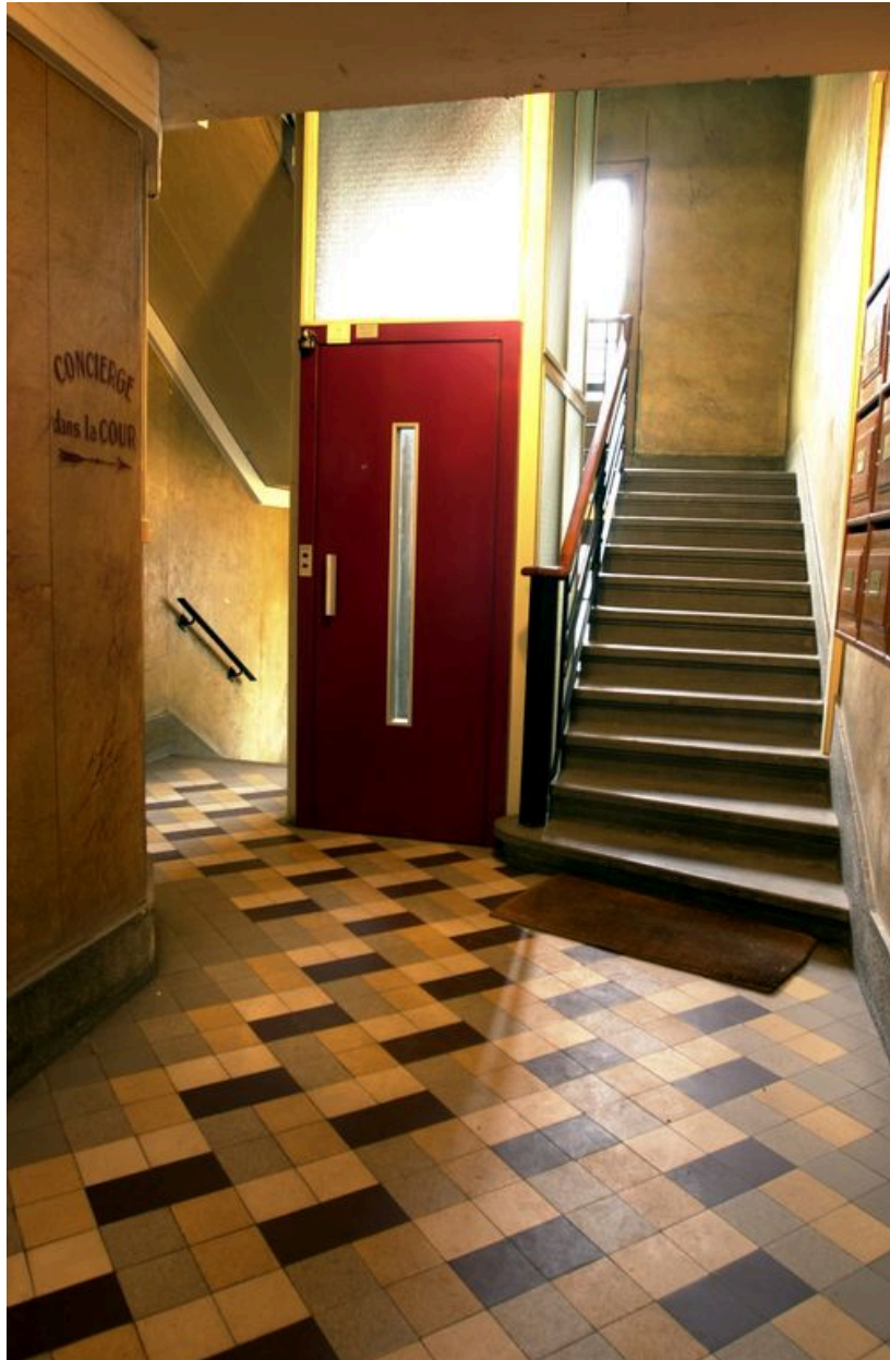
Vue du vestibule, de l'ascenseur et de l'escalier
