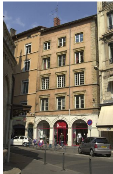
Vue générale de la façade sur la rue de la Fromagerie Phot. Bernard Ducouret IVR82_20046900352NUCA
