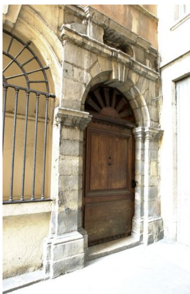
Façade principale, porte Phot. Bernard Ducouret IVR82_20046900354NUCA
