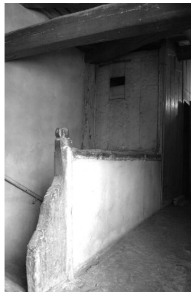
Escalier, palier du dernier étage Phot. Bernard Ducouret IVR82_20046900358NUC
