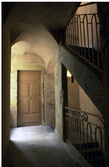
Escalier, palier du 3e étage Phot. A. Rémond IVR82_20046900357NUCA
