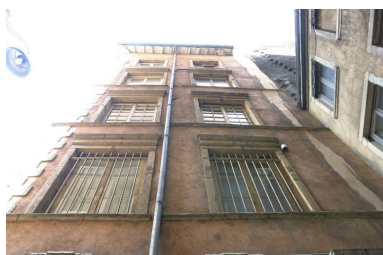
Façade principale sur la cour commune Phot. Bernard Ducouret IVR82_20046900353NUCA
