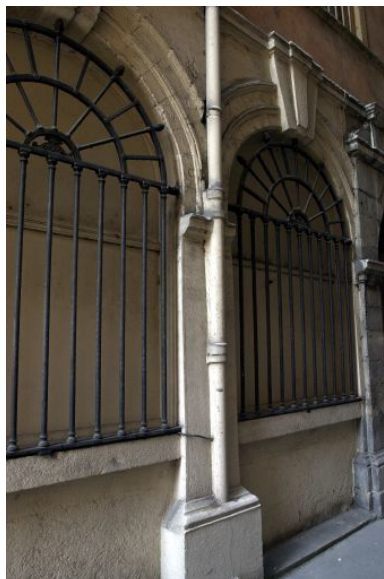
Façade principale, anciennes ouvertures de boutique Phot. Bernard Ducouret IVR82_20046900356NUCA
