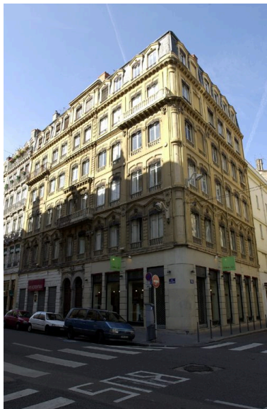
Vue d'ensemble sur la rue du Président-Edouard-Herriot et la rue Tupin Phot. Bernard Ducouret IVR82_20046905300NUCA
