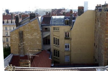
Elévations postérieures depuis la cage d'escalier de l'immeuble sis 23 rue de Brest Phot. Bernard Ducouret IVR82_20046905301NUCA
