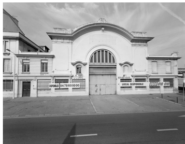
Vue est façade atelier de fabrication Phot. Martial Couderette IVR82_20016900677V
