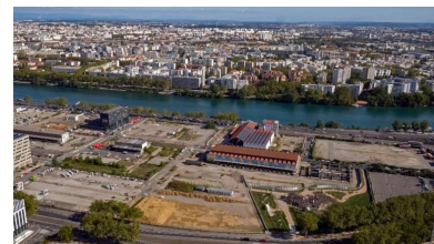
Vue d'ensemble ouest des établissement Paul Dulac et Nas reconverti en H7 Vurpas (drône) Phot. Michel Pérès IVR84_20196900604NUCA
