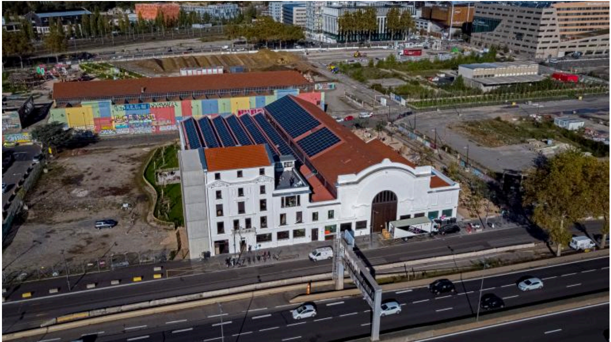
Vue d'ensemble est de la reconversion du site en 2019 (drône)
