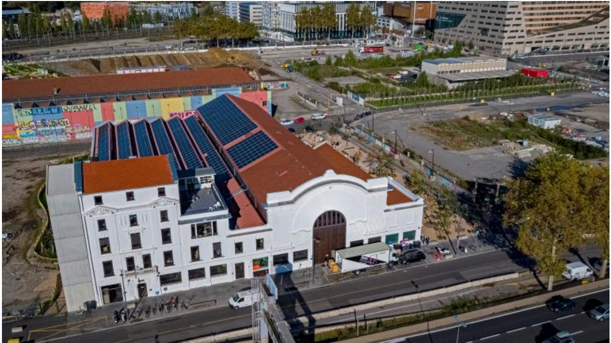
Vue d'ensemble de la reconversion du site par le cabinet Vurpas architecture (drône).
