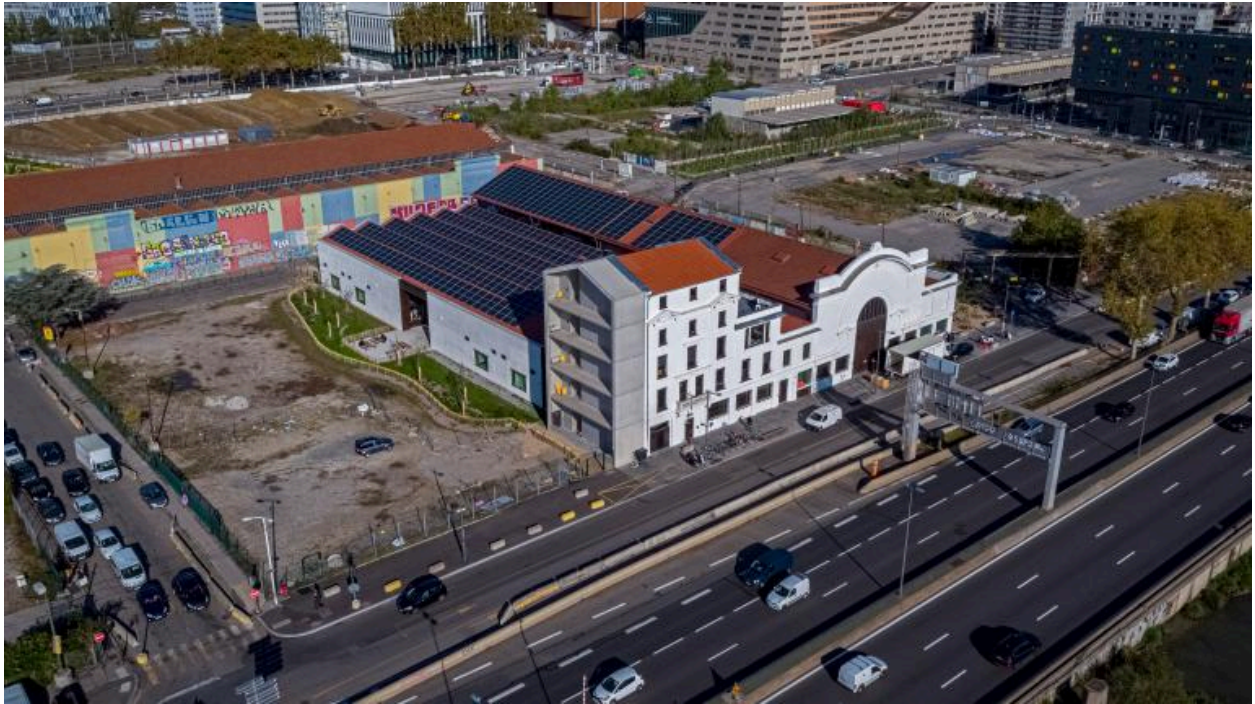
Vue d'ensemble en 2019 du site reconverti "H 7" (drône).
