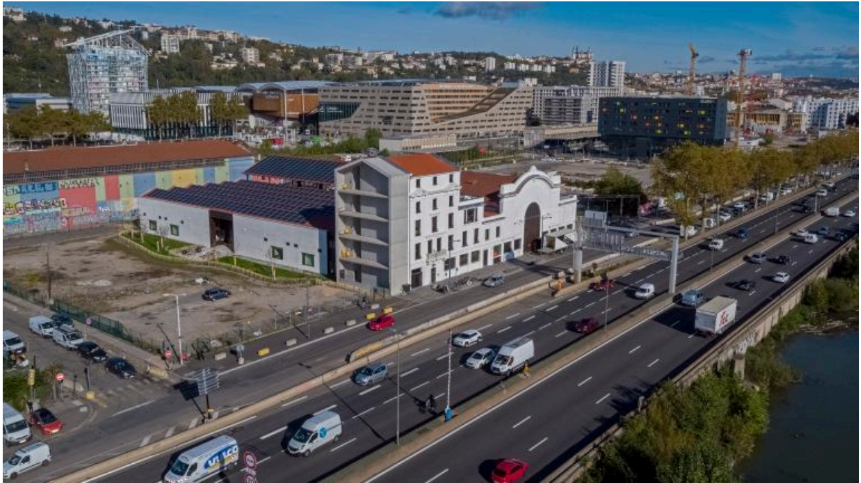
Vue d'ensemble de la reconversion extension sud du bâtiment (pignon) (drône).
