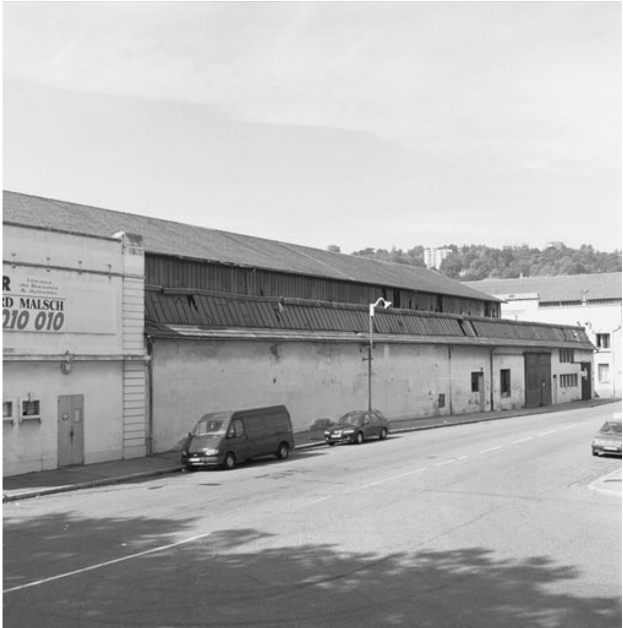
Vue nord-est de l'atelier
