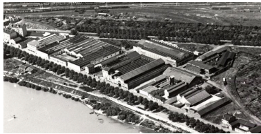
Vue aérienne depuis le nord-est, vers 1955 Repro. Jacques Gastineau IVR82_20036900334NUC
