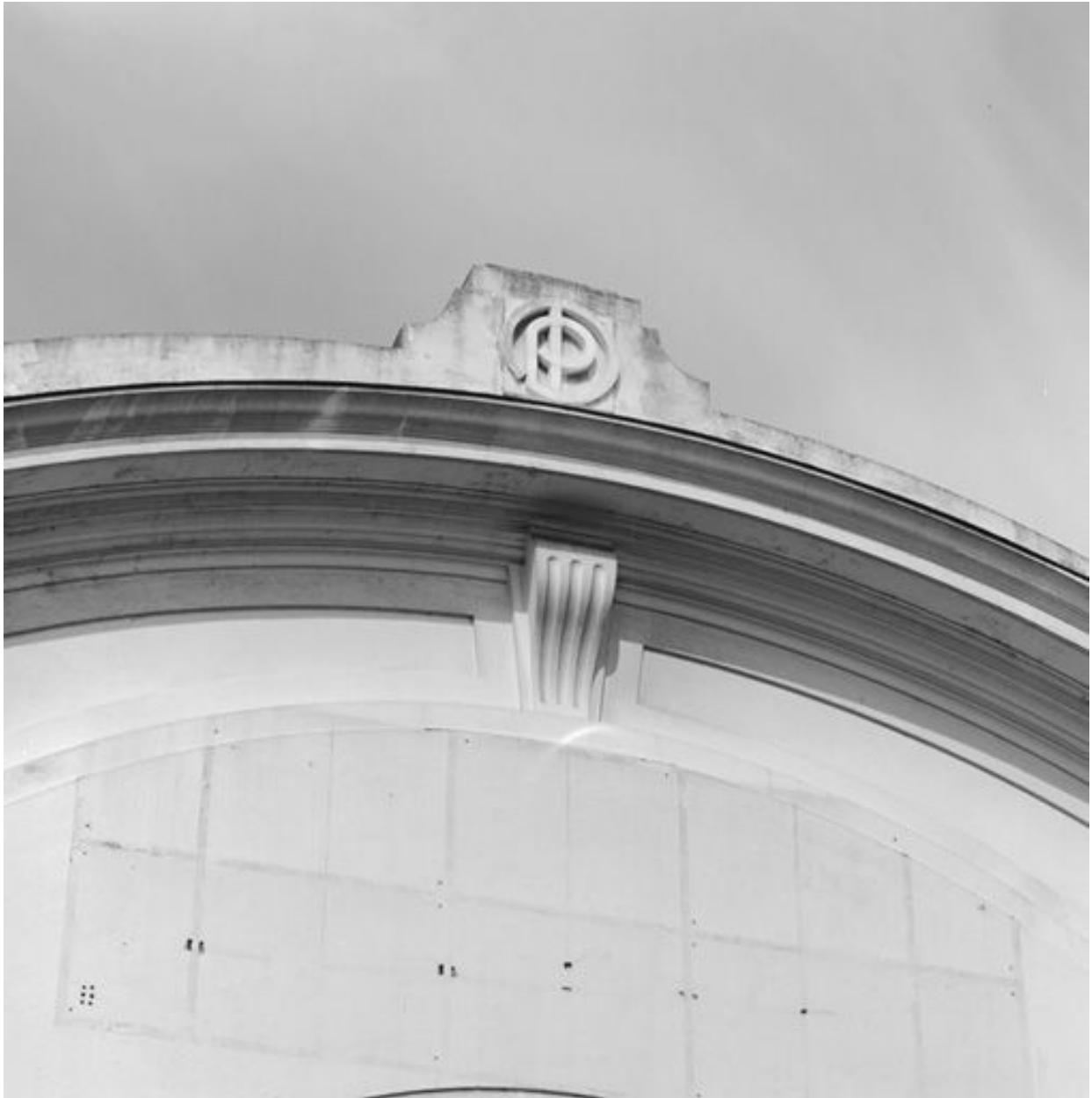
Détail chiffre PDC en médaillon de la façade de l'usine
