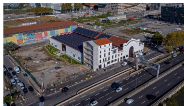
Vue d'ensemble sud-est après reconversion en 2019 (drône) Phot. Michel Pérès IVR84_20196900718NUCA
