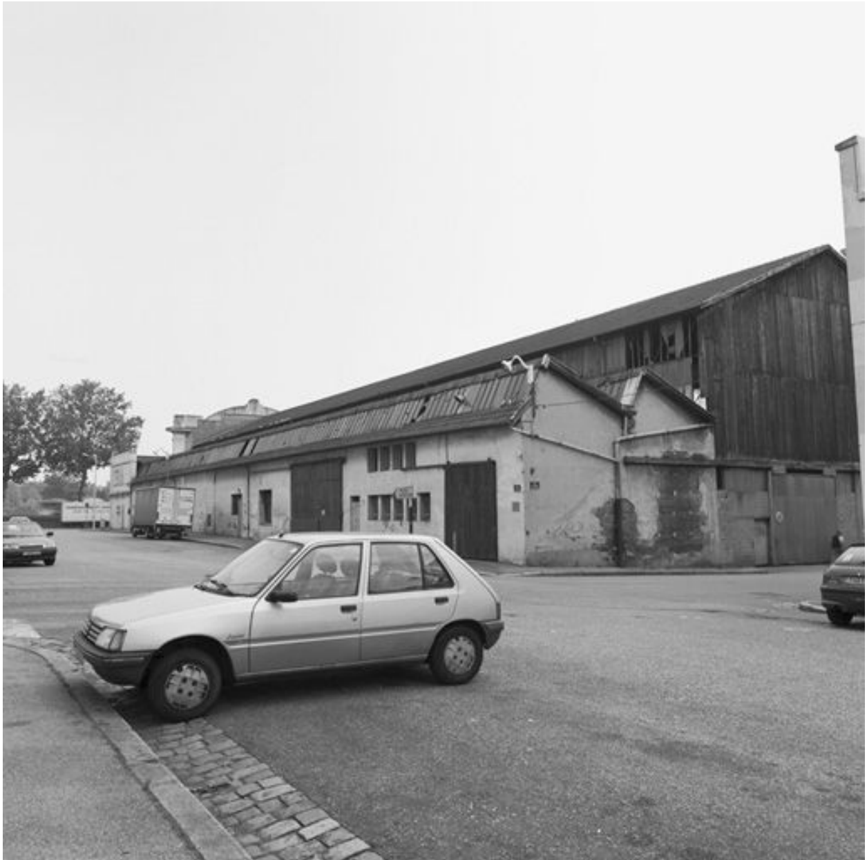
Vue nord-ouest des ateliers de fabrication : grande halle et shed
