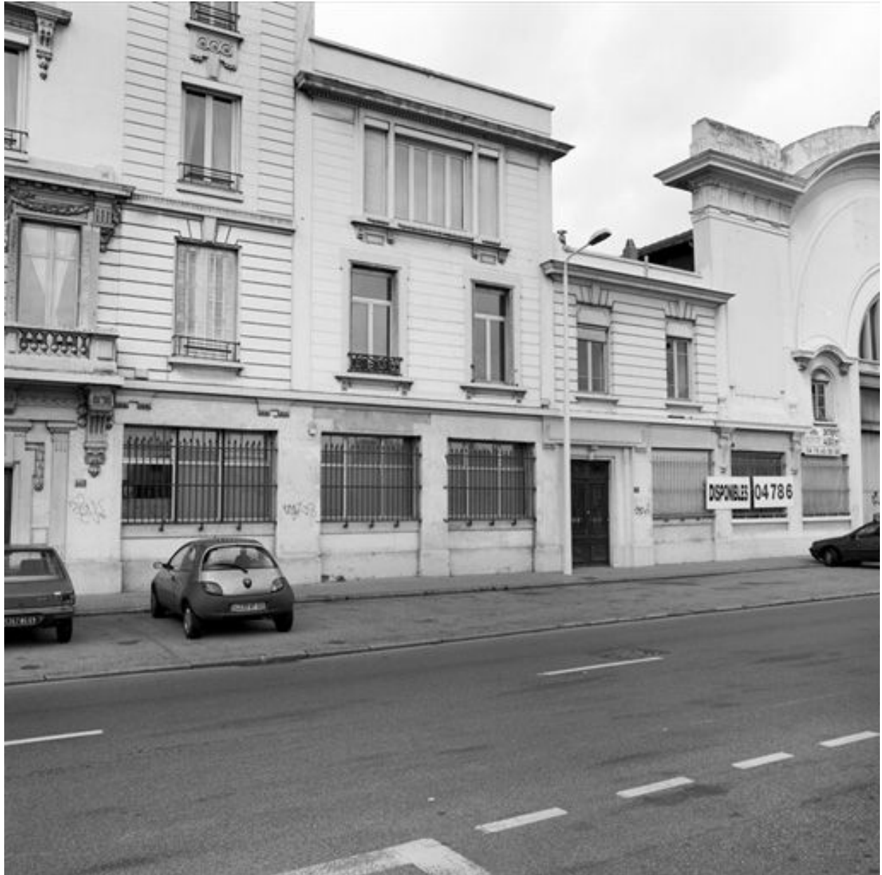
Vue est, façade bureau administration
