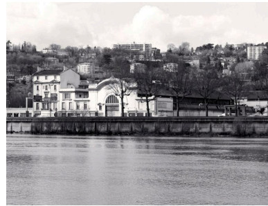
Vue d'ensemble depuis l'est Phot. Eric Dessert IVR82_20026903025X
